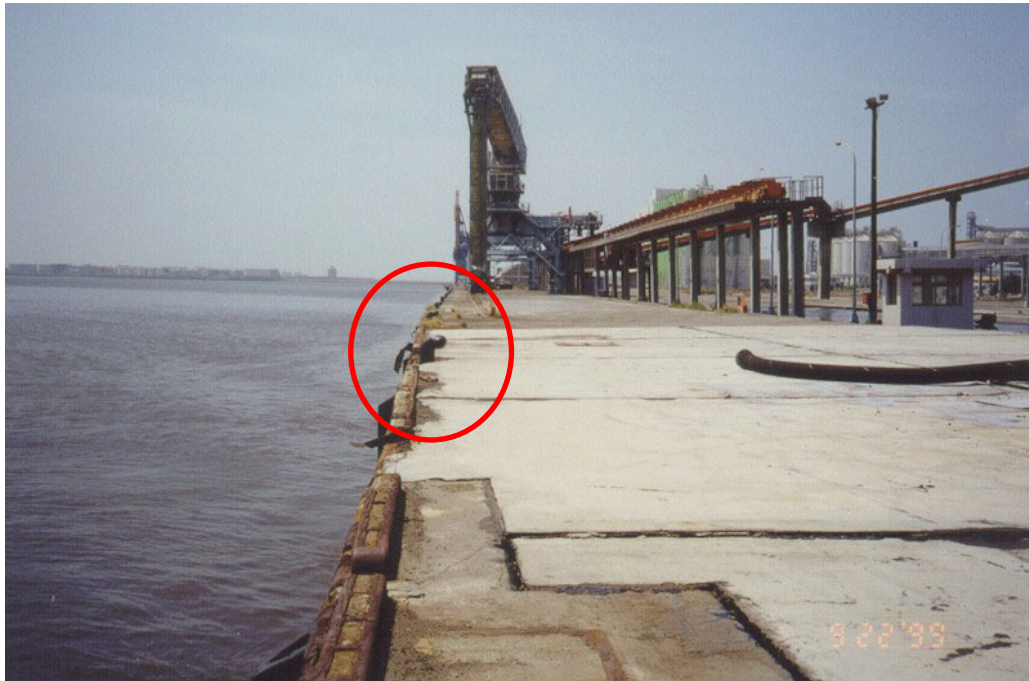
圖 3.1 #1~#4 沉箱式碼頭法線變位側視圖
