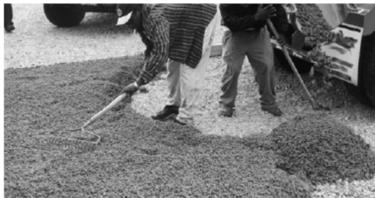
照片 3.3 藉由耙子攤平透水混凝土
