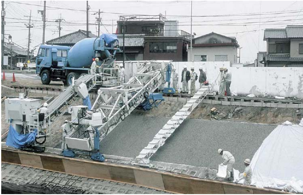
照片 2.4 透水混凝土護坡施工澆置情形(GOMACO 公司)
