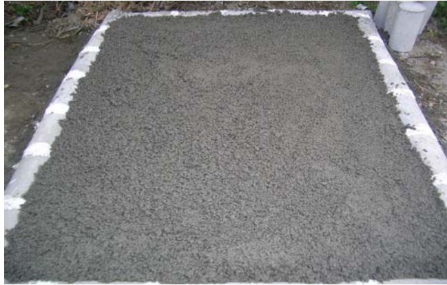
照片 6.4 為預拌廠試鋪透水混凝土完成面
