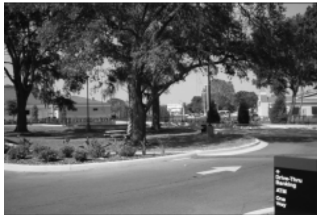
圖12 透水混凝土鋪面鋪設於樹木滴水區
