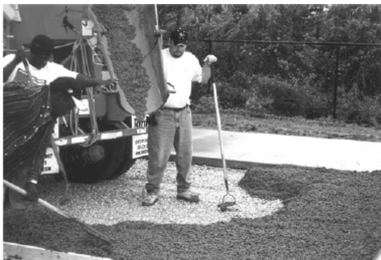
照片 3.1 藉由預拌車尾端卸料澆置透水混凝土
