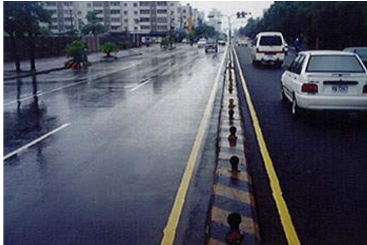
圖 2.6 臺南市中華西路之排水性瀝青路面
