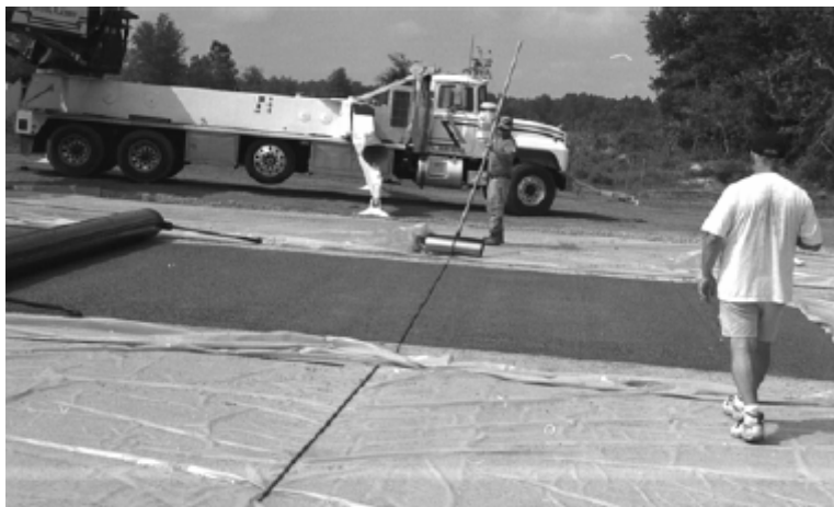
照片 3.11 壓密透水混凝土後應迅速使用塑膠紙覆蓋養護鋪面
