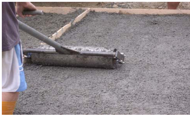
照片 6.14 透水混凝土使用小滾筒滾壓情形
