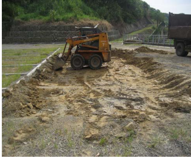
照片 6.7 現地停車格開挖情形
