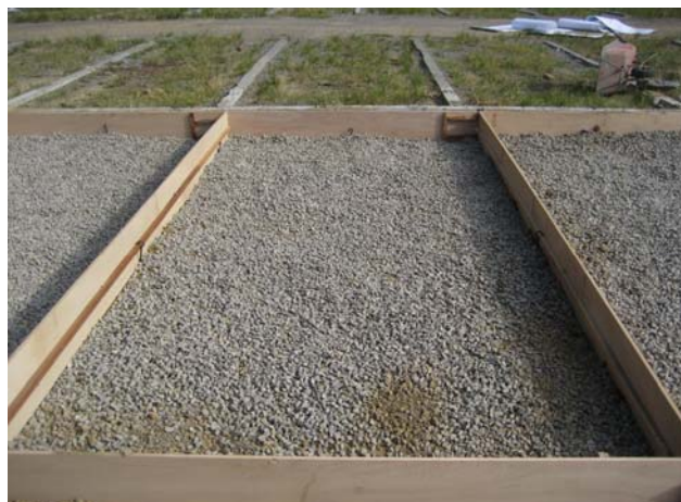
照片 6.9 停車格底層鋪設約 5 公分礫石
