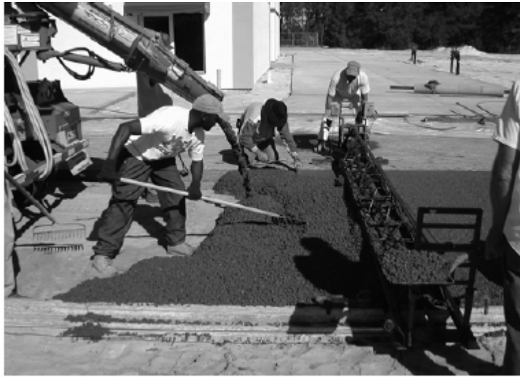
照片 3.4 藉由振動刮板進行搗實透水混凝土
