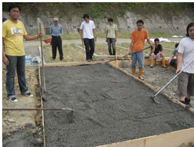
照片 6.12 透水混凝土拌合料刮平情形
