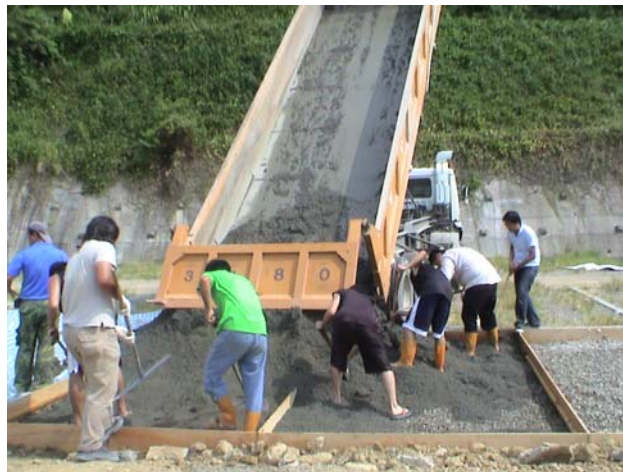
照片 6.11 透水混凝土使用卡車尾端傾倒卸料澆置停車格
