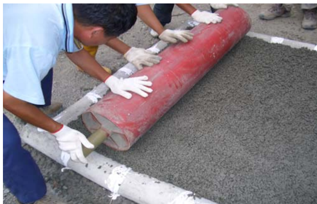
照片 6.3 預拌廠試鋪透水混凝土滾筒壓密之施作
