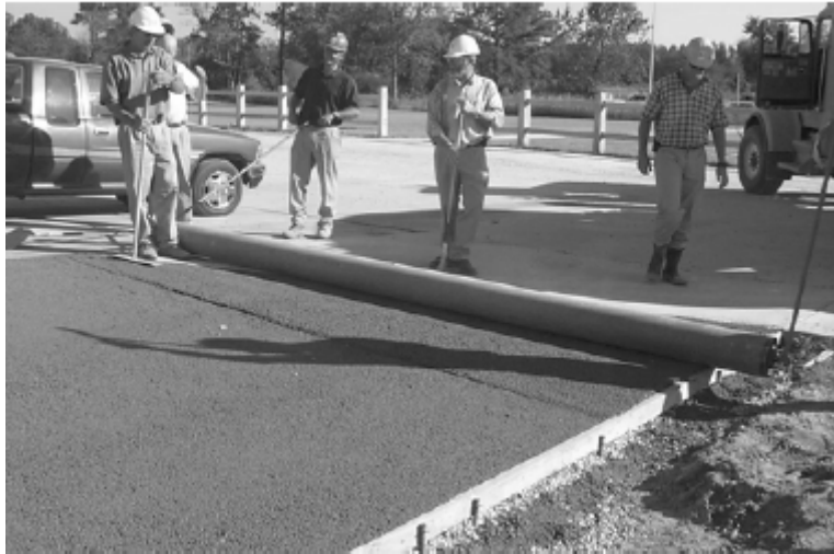
照片 3.5 藉由滾筒壓密透水混凝土
