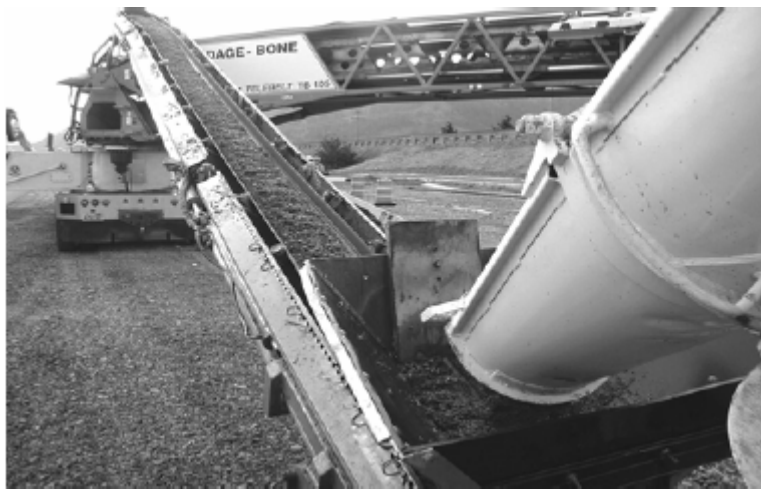
照片 3.2 藉由輸送帶澆置透水混凝土
