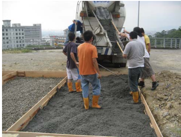
照片 6.10 透水混凝土使用預拌車尾端卸料澆置停車格
