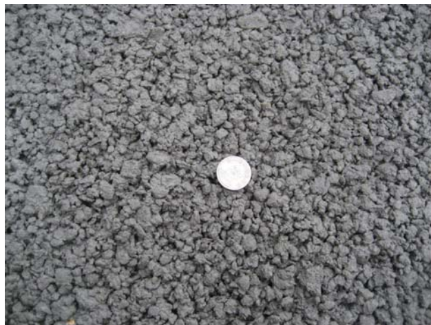
照片 6.15 新拌透水混凝土滾壓完成面
