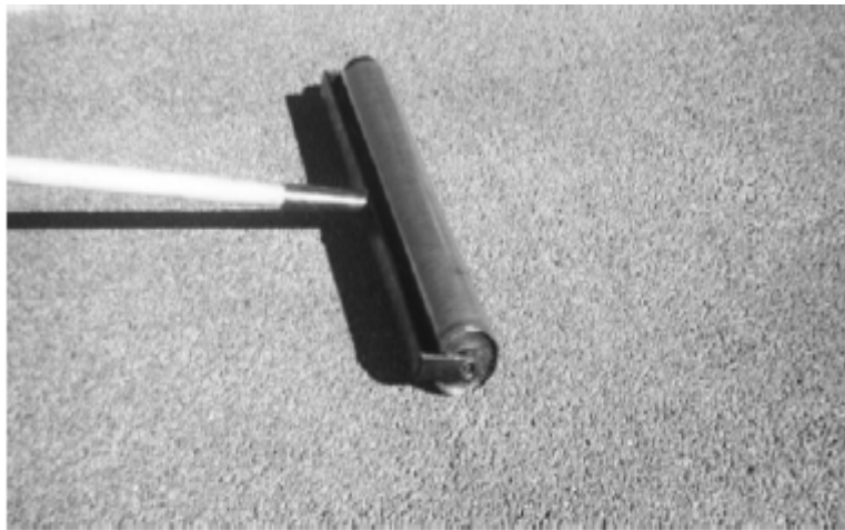
照片 3.6 藉由小滾筒壓密小區域透水混凝土
