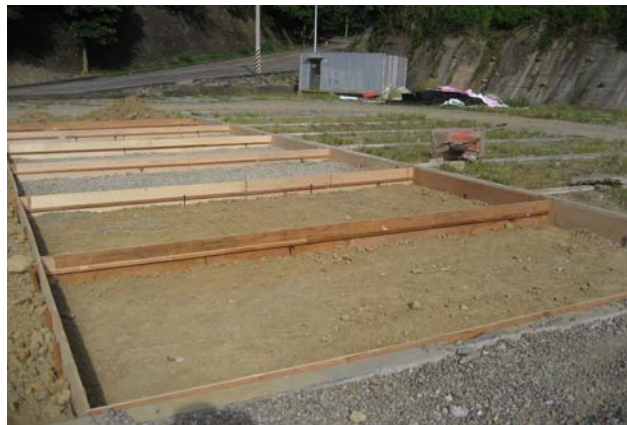
照片 6.8 六個 5.5 公尺長*2.4 公尺的停車格現地模版組立
