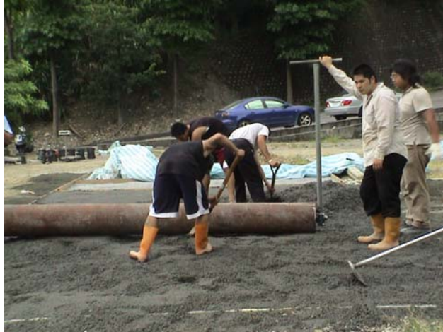
照片 6.13 透水混凝土使用大滾筒滾壓情形
