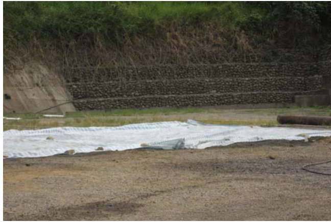
照片 6.16 塑膠布覆蓋養護新拌透水混凝土鋪面
