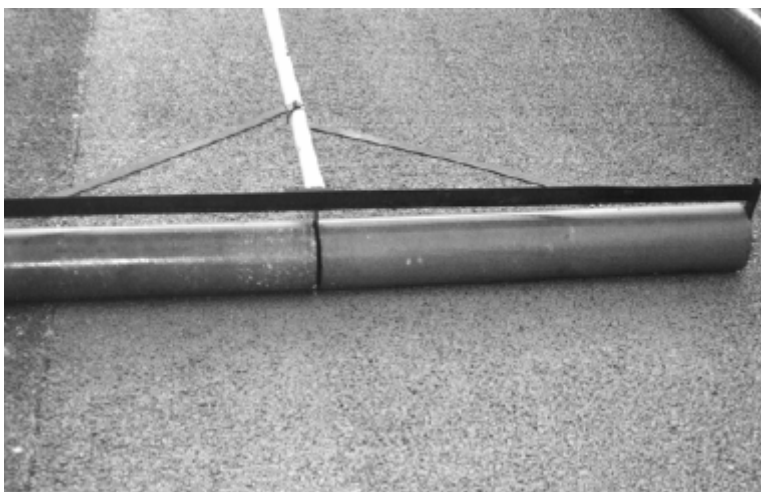
照片 3.7 二次橫向滾筒壓密透水混凝土以改善鋪面騎乘品質
