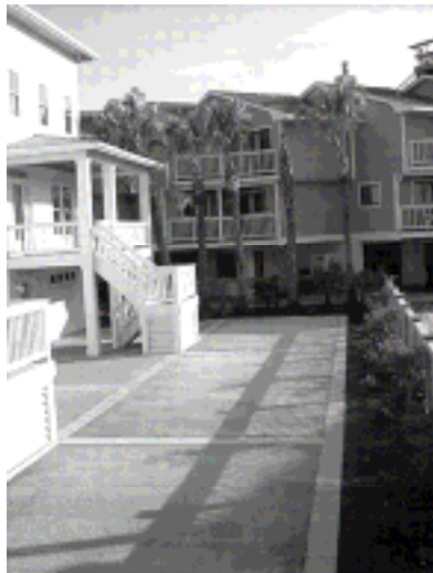
圖13 透水混凝土建造的停車場
