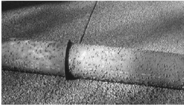
照片 3.10 滾筒附有刀鋒可以縱向切縫透水混凝土鋪面
