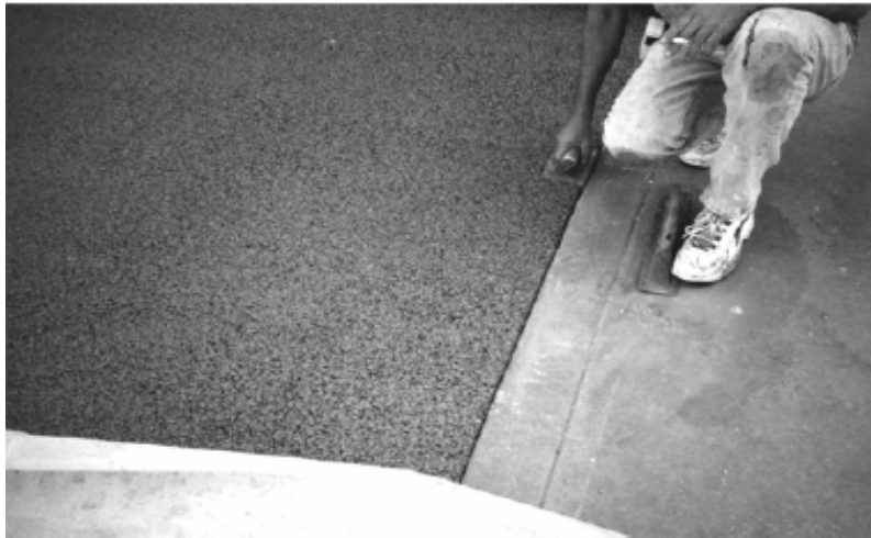
照片 3.8 鋸刀邊飾透水混凝土以改善角落外觀
