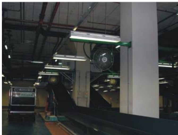
圖 3.25 第二航廈行李分揀完成輸送帶連接道
