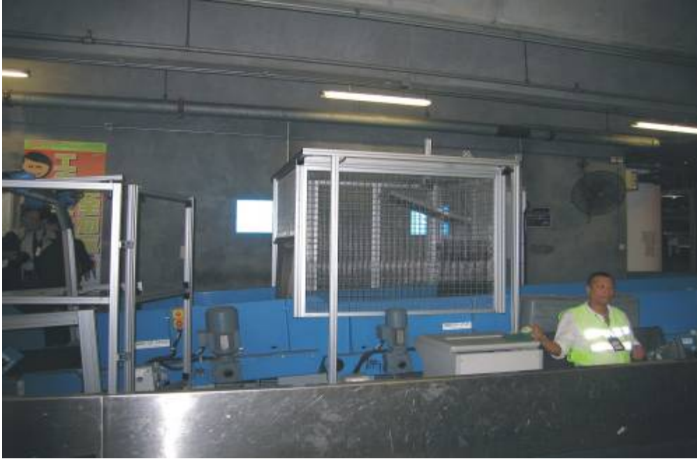
圖 2.15 HKIA 託運行李 RFID Tag 中寫入 LPN 資訊的籠閘
