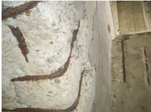
鋼筋外露(北縣中正橋)
