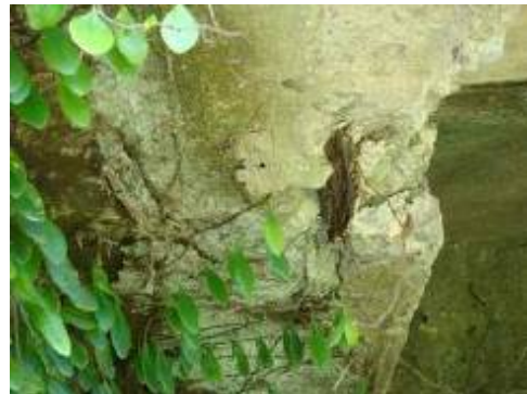
橋鋼筋外露(北縣新興橋(4B-4))
