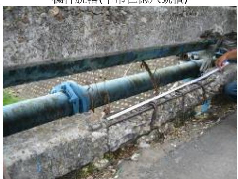
欄杆破損(中縣水尾橋)
