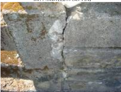
欄杆破損(宜縣零工圍橋)
