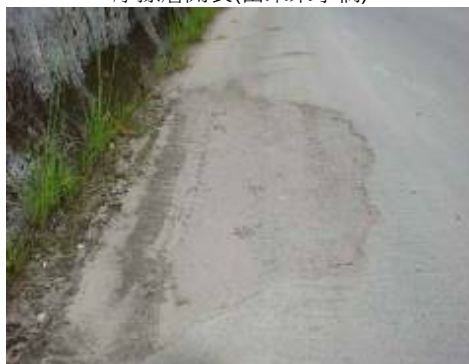
摩擦層破洞(中縣同心橋)
