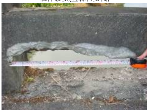
欄杆破損(宜縣東津橋)
