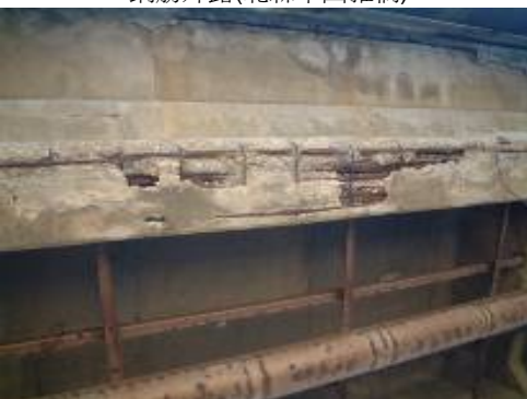
鋼筋外露(桃縣許厝港一號橋)
