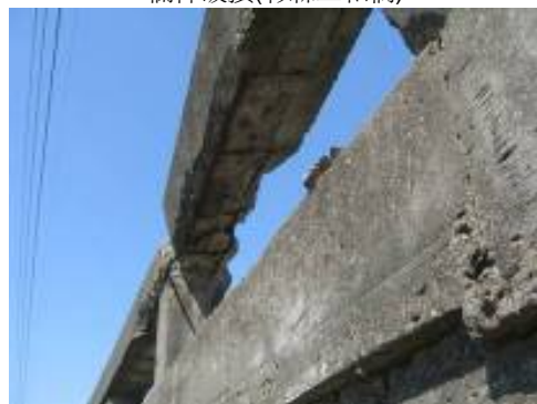
欄杆破損(彰縣太平橋)
