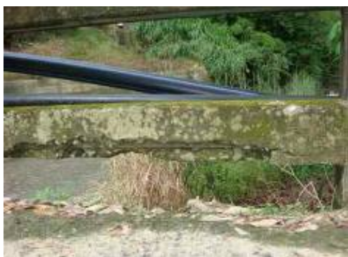
欄杆破損(中縣孟鈴橋)
