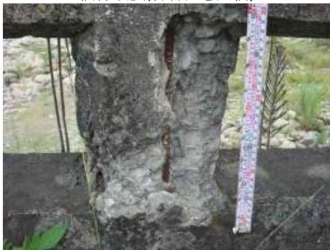
欄杆破損(苗栗大湖二橋)
