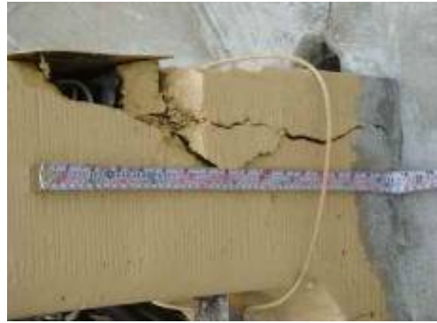
護牆破損(竹市綠水人行路橋)
