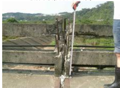
欄杆破損(苗栗水頭屋橋)
