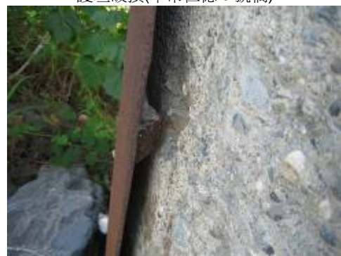
防撞鋼板脫落(臺東北里橋)
