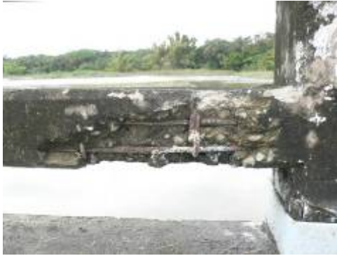
欄杆破損(南縣春暉橋)
