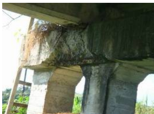
帽梁破損(宜縣零工圍橋)
