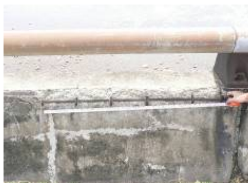
欄杆破損(竹縣振興橋)
