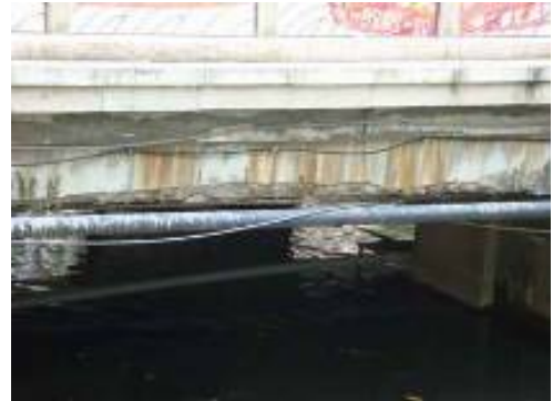
鋼筋外露(竹市大同橋)
