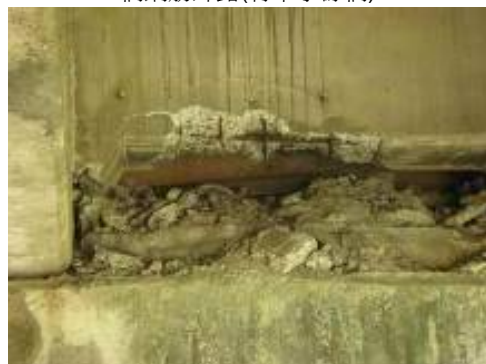
橋鋼筋外露(竹縣褒忠大橋)
