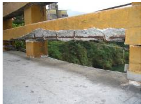
欄杆破損(北縣中正橋)
