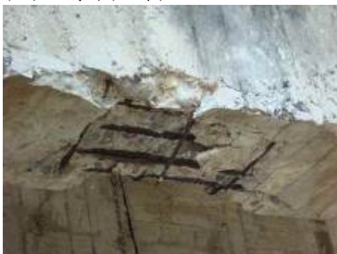
鋼筋外露(北縣公埔子橋)
