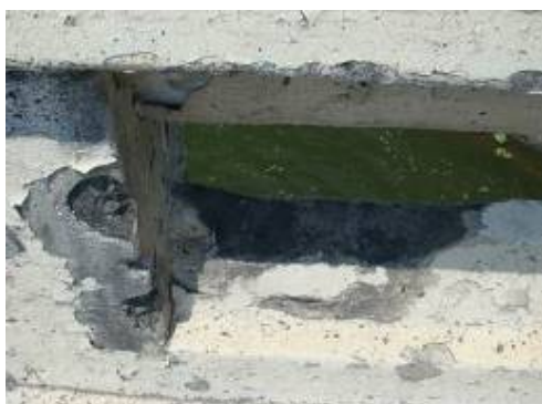
欄杆破損(宜縣竹安橋)
