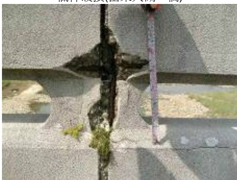
欄杆破損(苗栗平安大橋)
