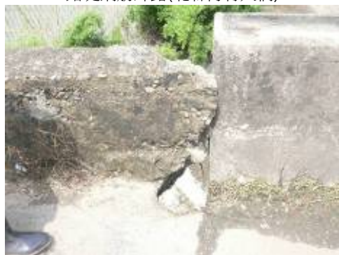
路堤破裂(竹縣振興橋)
