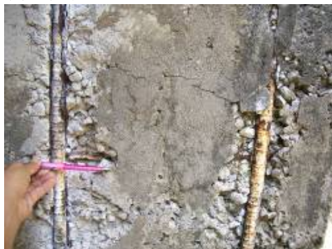
路堤鋼筋外露(北縣梅竹大橋)
