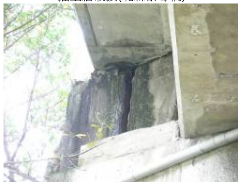
翼牆損傷(竹縣三聖橋)
