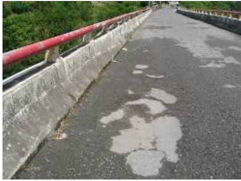
摩擦層破洞(臺東北里橋)
