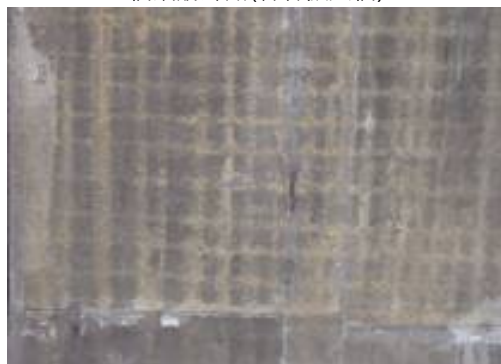
橋鋼筋外露(北縣中山高架橋)
