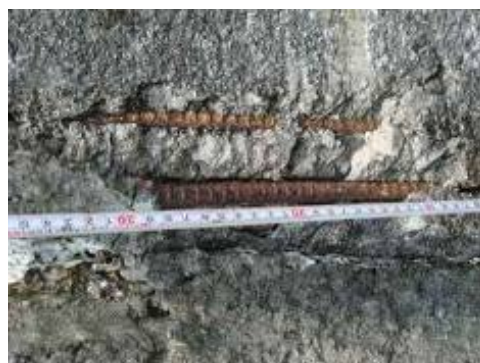
欄杆破損(苗栗恭敬橋)
