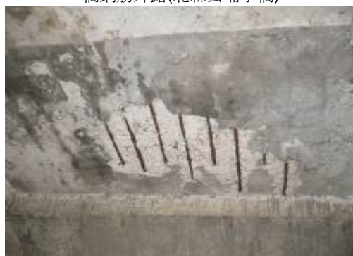
橋鋼筋外露(竹縣振興橋)
