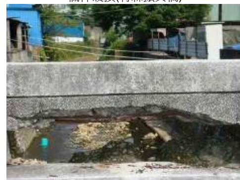
欄杆破損(北縣黎專橋)
