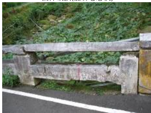
欄杆破損(嘉縣凍興二號橋)
