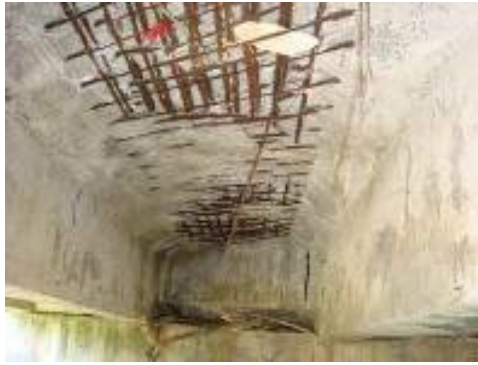
橋鋼筋外露(北縣後寮橋)
