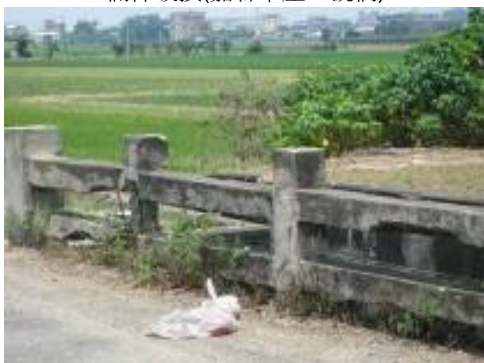
欄杆破損(嘉縣后港橋)
