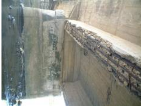
鋼筋外露(桃縣砂崙橋)
