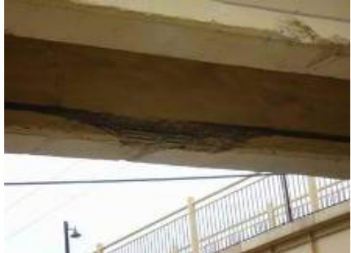
鋼筋外露(竹市綠水人行橋)
