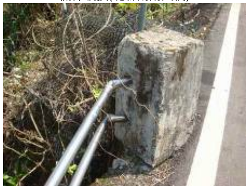
欄杆破損(北縣後寮橋)
