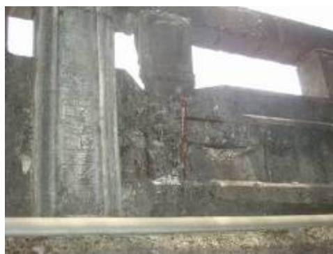
欄杆破損(宜縣刺仔崙橋)
