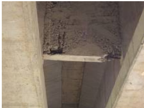
橋鋼筋外露(北縣梅竹大橋)
