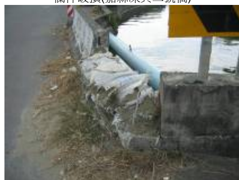
欄杆破損(嘉縣過溝橋)
