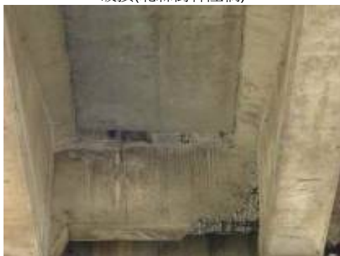
橋鋼筋外露(竹縣雲埔橋)
