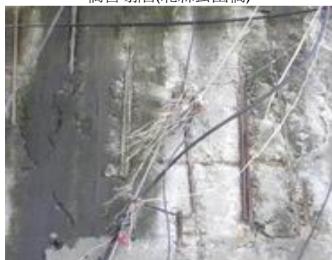
橋台鋼筋外露(北縣江北大橋)
