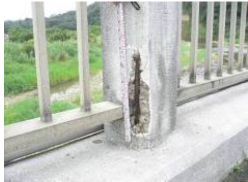
欄杆破損(竹縣三聖橋)
