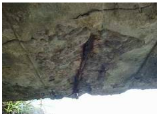
橋鋼筋外露(北縣公埔子橋)
