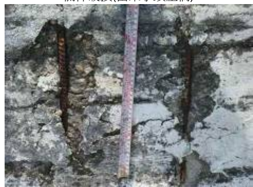
欄杆破損(苗栗田心橋)
