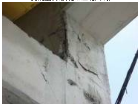
柱頭壓損(竹市綠水人行陸橋)
