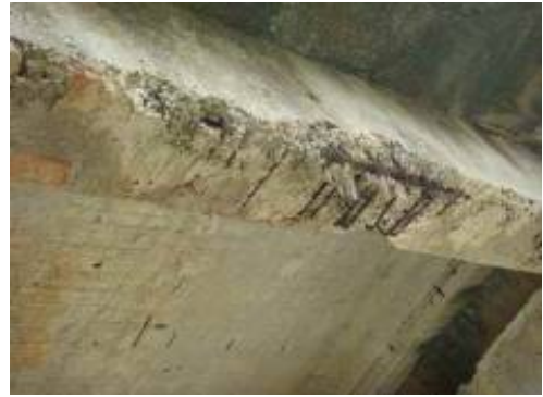
鋼筋外露(北縣大坑二橋)
