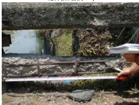
欄杆破損(北縣潭墘橋(3B-5))
