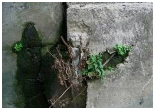
擋土牆破損(北縣營盤橋)
