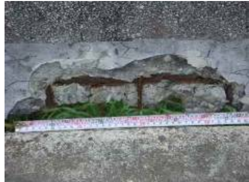
欄杆破損(苗栗八燕坑橋)
