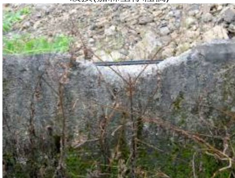
混凝土剝落(苗栗梅象大橋)
