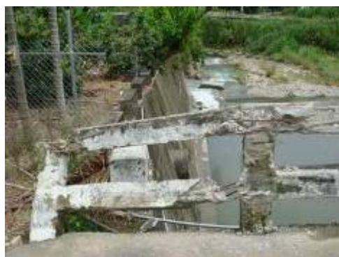
欄杆倒塌(中縣茅埔橋)
