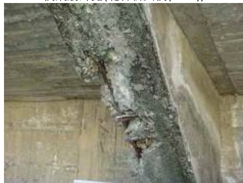
橋鋼筋外露(竹市水源橋)
