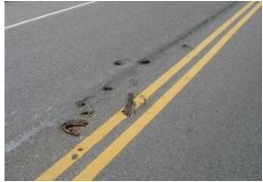
鋼筋凸出(臺東知本溫泉橋)
