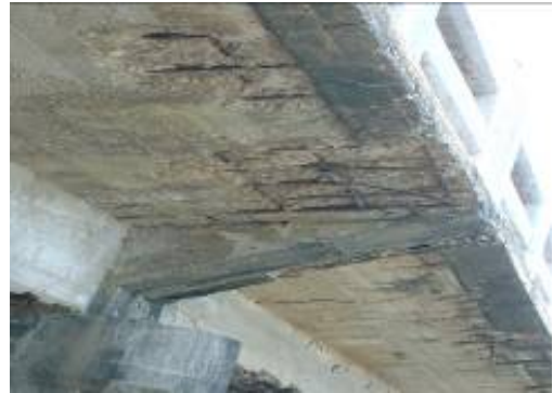
橋鋼筋外露(桃園砂崙橋)
