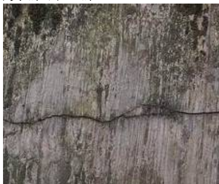
擋土牆破損(北縣黎專橋)
