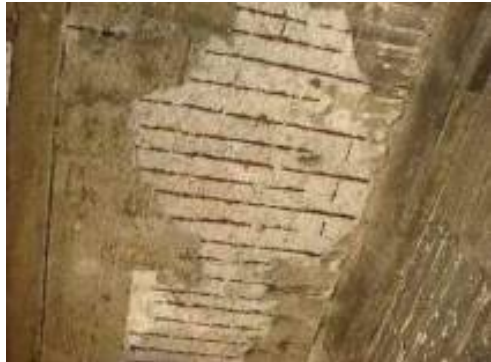
橋鋼筋外露(北縣黎專橋)
