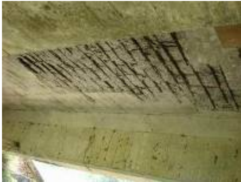
橋鋼筋外露(北縣新興橋(4B-4))
