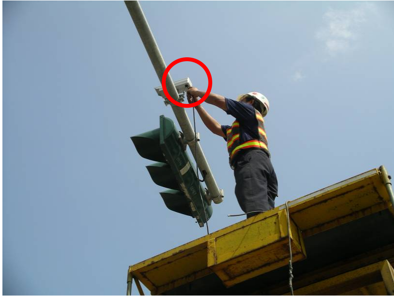
圖 4-16 拍攝行人穿越道方向紅綠燈號之 CCD 攝影機
