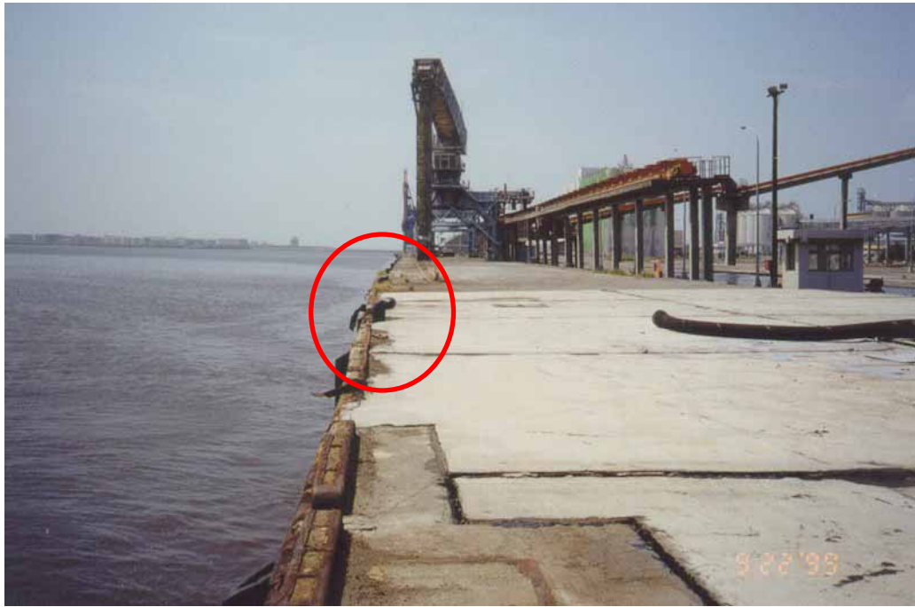
圖 3.1 #1~#4 沉箱式碼頭法線變位側視圖
