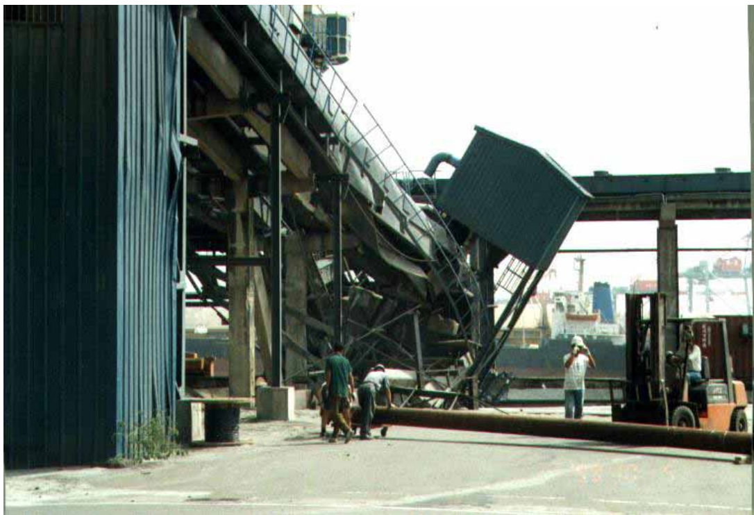
圖 3.4 921 臺中港裝卸設施災損情形
