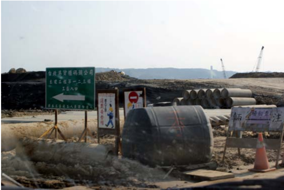
圖 3-21 北碼頭工地現況
