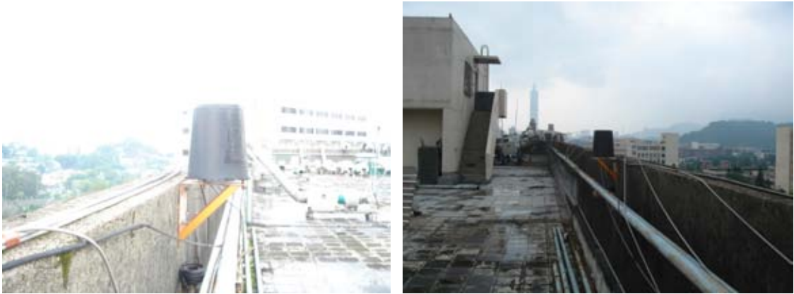
圖 4.25 NTUST-E2 雨量站安裝情形
