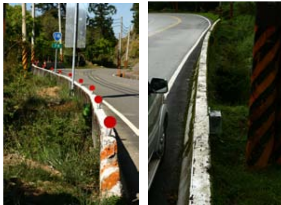
圖 4.23 R-T18-91k+300 雨量站安裝情形
