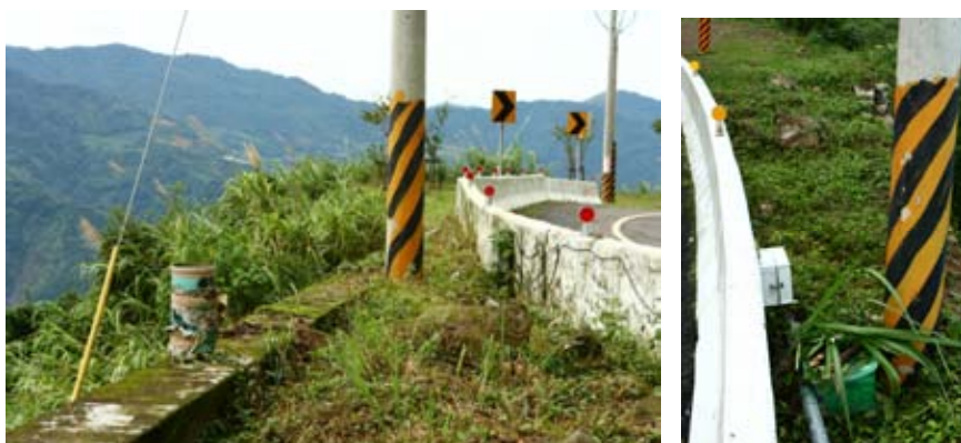
圖 4.19 R-T18-78k+600 雨量站安裝情形
