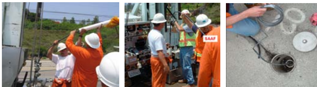
圖 2.43 現場安裝與佈設
