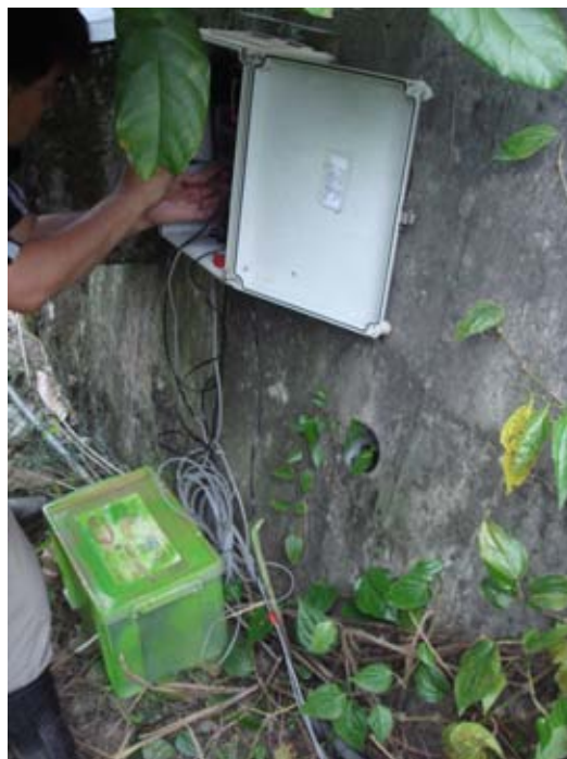
圖 4.4 將電纜線連接資料接收箱與電池
