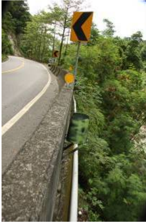
圖 4.11 R-T18-35k+300 雨量站安裝情形
