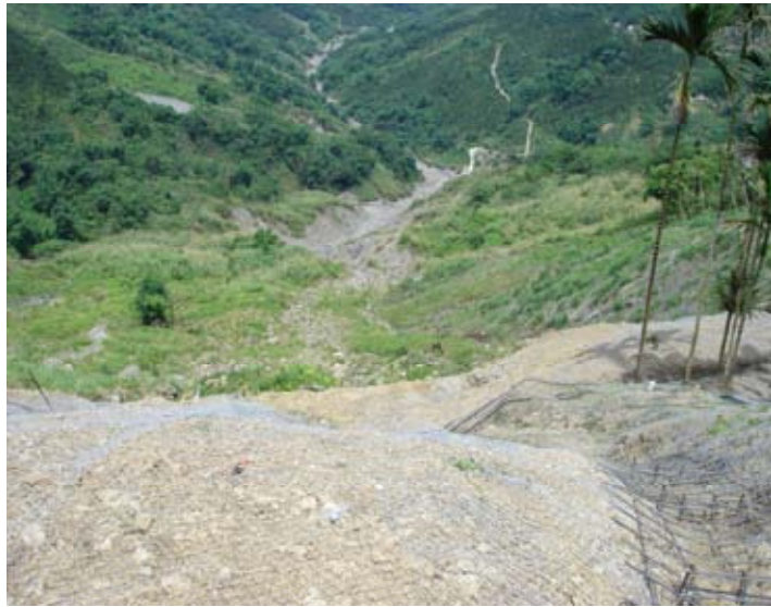
圖 2.9 IHMT-01 200m 傾斜觀測管後方邊坡坡面植生工程
