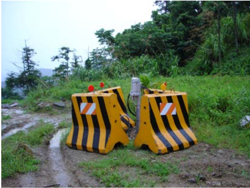
圖 2.15 IHMT-01 孔位光纜架設
