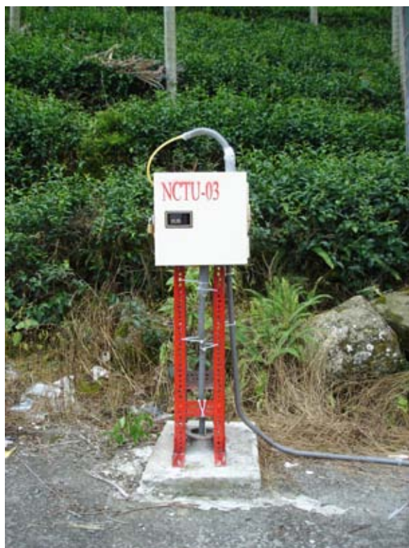
圖 2.17 NCTU-03 光纜架設
