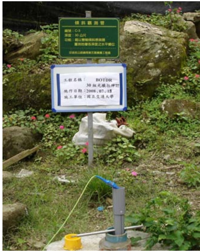
圖 4.3 C-3 30m 傾斜觀測管安裝 6 組 BOTDR 光纖拉伸計
