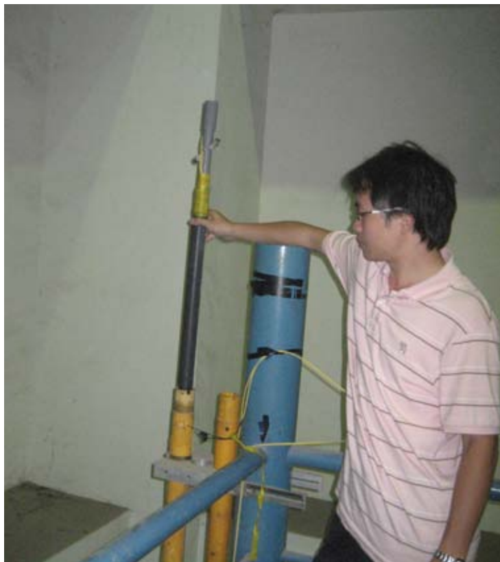
圖 3.12 光纖拉伸計架設於室內九米傾斜觀測管
