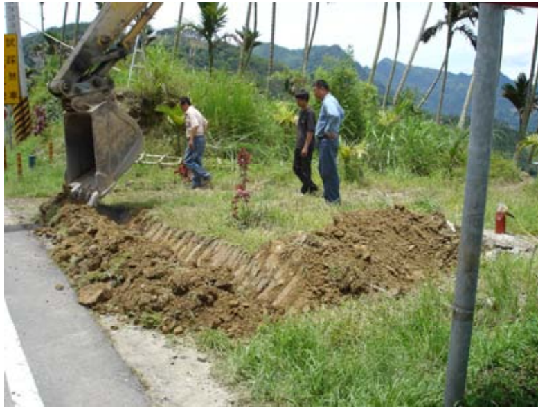
圖 2.11 IHMT-01 孔位光纜佈放工程
