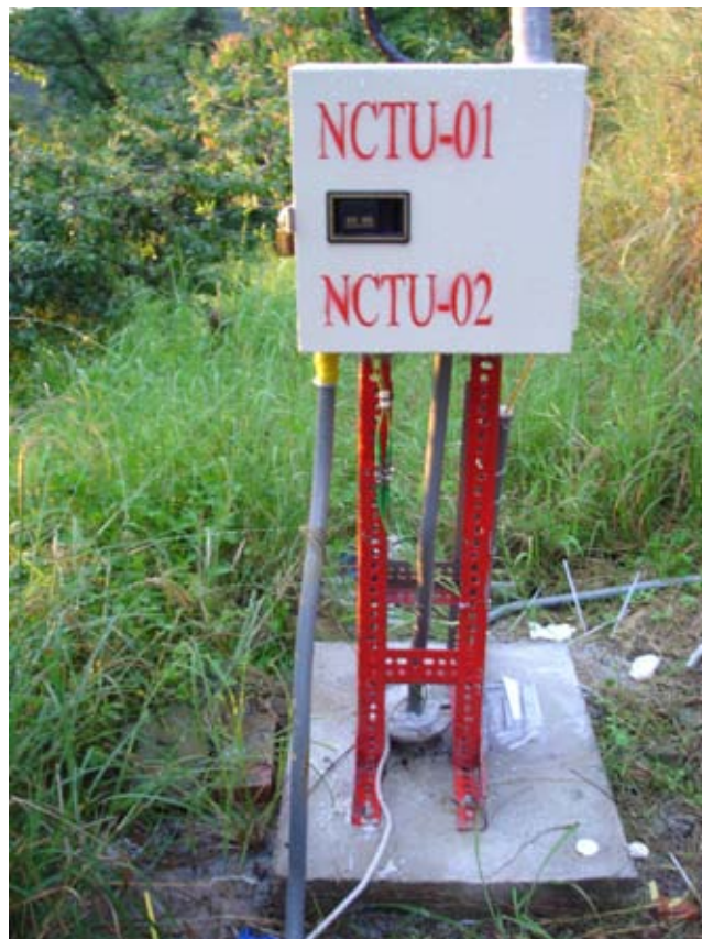
圖 2.16 NCTU-01 及 NCTU-02 光纜架設
