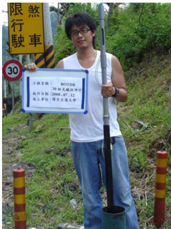
圖 4.4 C-12A 40m 傾斜觀測管安裝 7 組 BOTDR 光纖拉伸計
