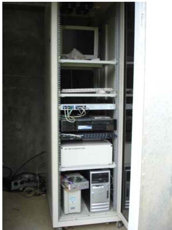
圖 2.12 監測小屋光纜配線盒裝設工程
