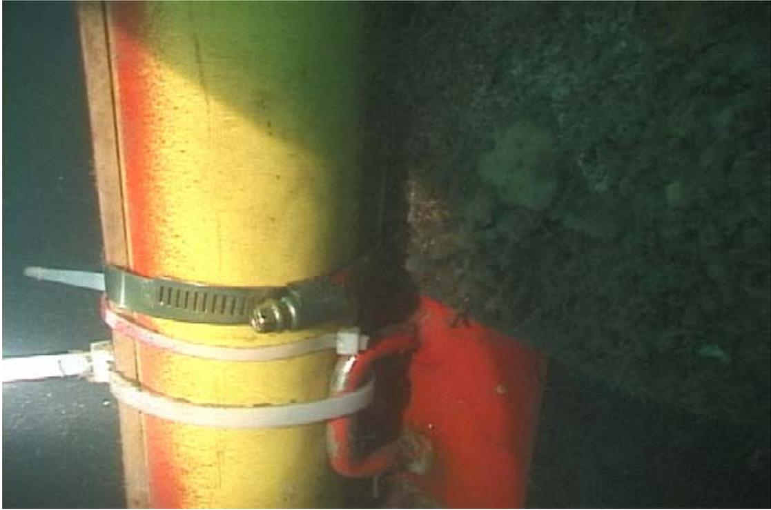
圖 4.19 光纖基樁變位感測元件連結於套環完成圖
