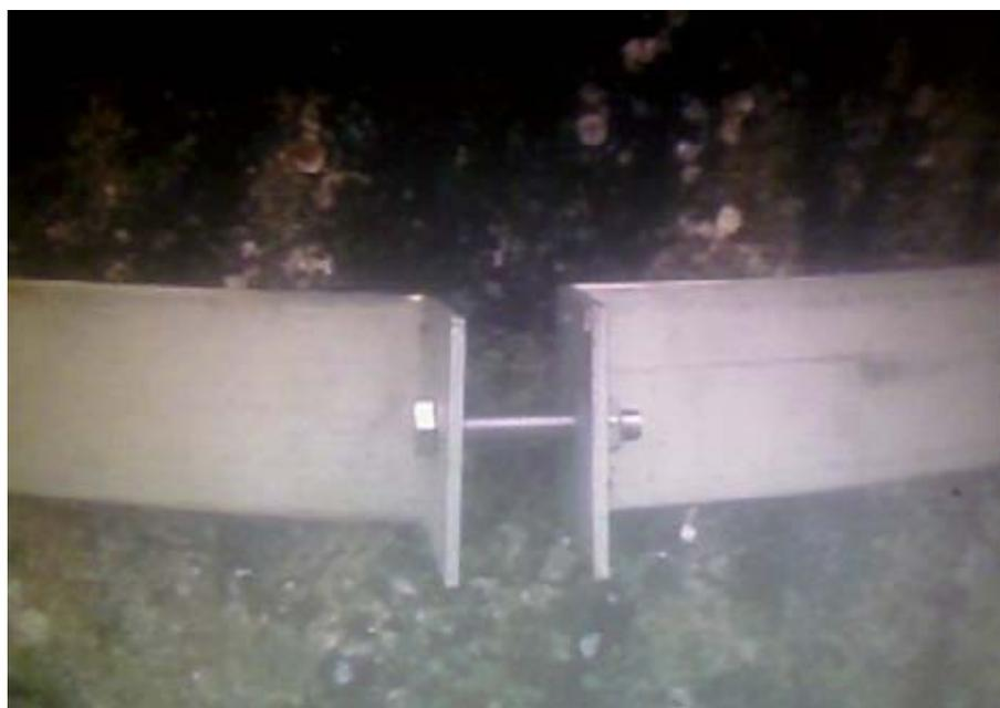
圖 4.17 基樁連結套環裝置完成圖
