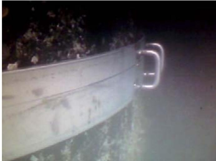
圖 4.6 基樁變位固定套環組裝完成圖
