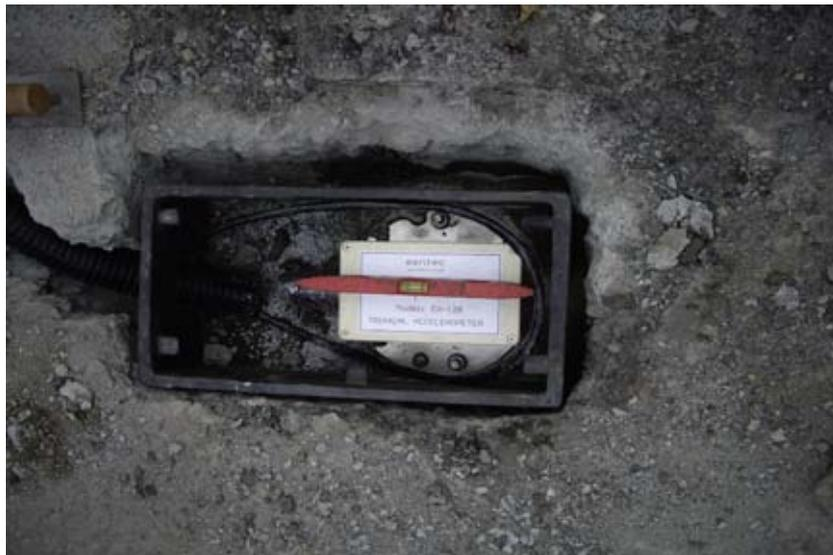
圖 4.22 裝設水表箱外罩與調整水平
