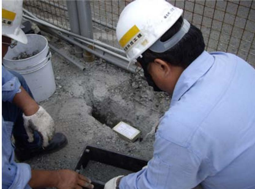
圖 4.21 開挖後裝設陸上地震儀
