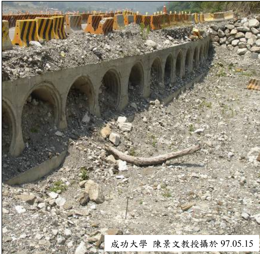
圖 3-37 97.5.15 現地拍攝照片(箱涵後方)
