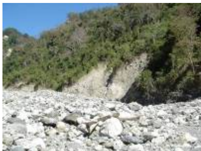
編號 22 號崩塌地現況
