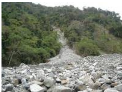
編號 19 號崩塌地現況
