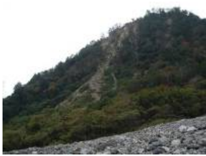
編號 1 號崩塌地現況
