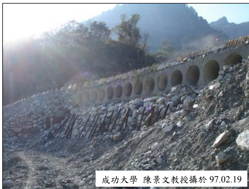
圖 3-36 97.02.19 現地拍攝照片(下邊坡)
