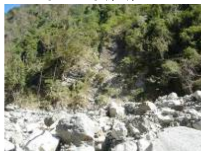
編號 18 號崩塌地現況
