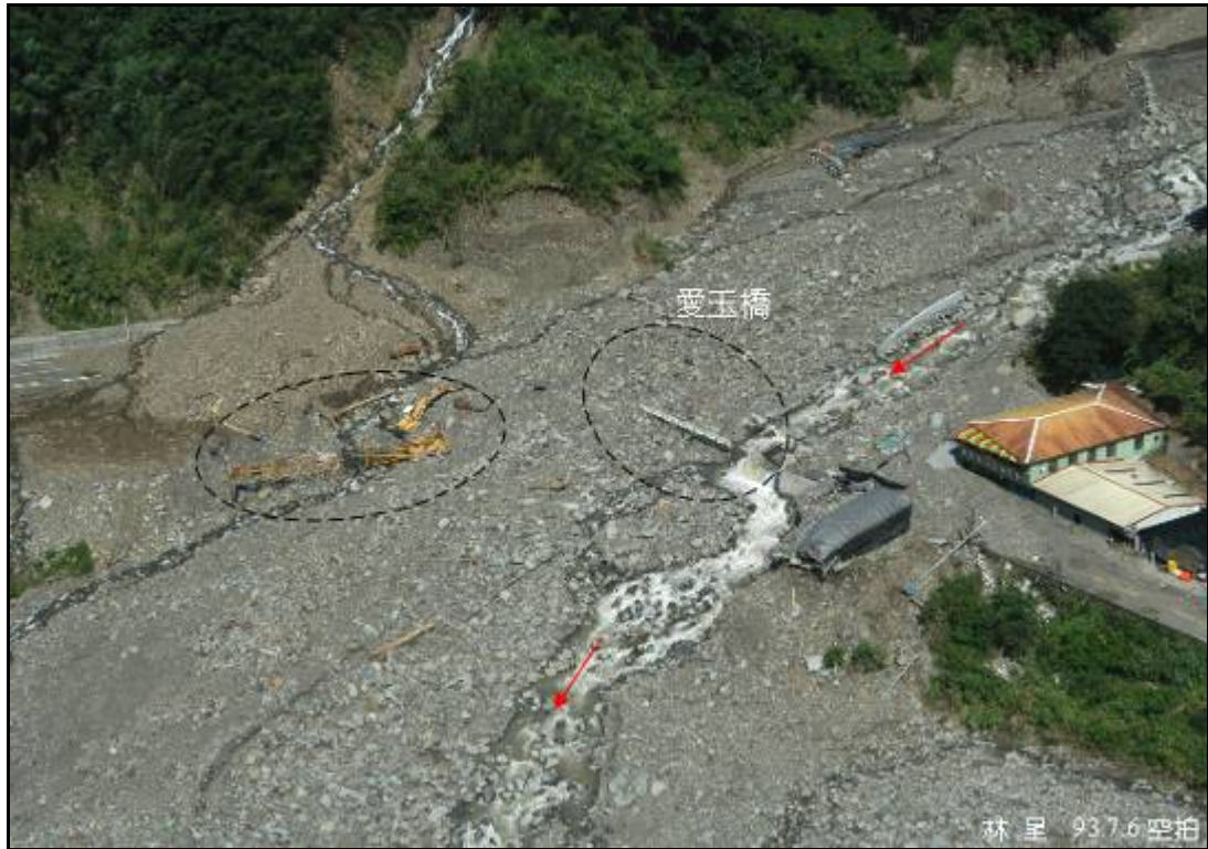
圖 3-72 敏督利颱風後愛玉橋遭土石流淤塞及施工機具遭掩埋之情況 資料來源：交通部公路總局，2005
