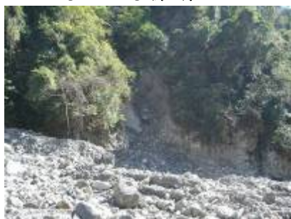
編號 17 號崩塌地現況
