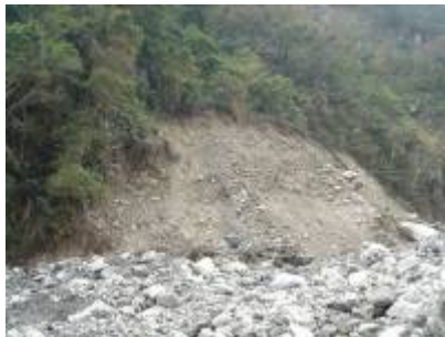
編號 5 號崩塌地現況
