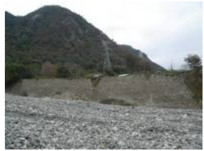
編號 3 號崩塌地現況
