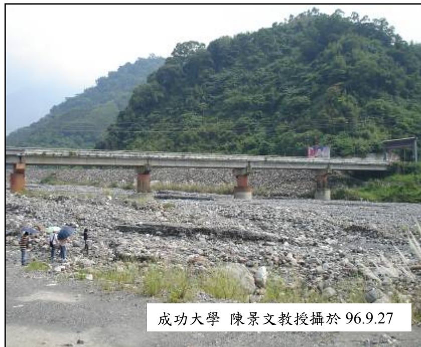
圖 3-48 信義橋修建後現況
