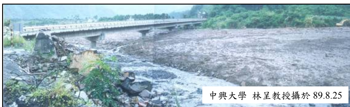
圖 3-58 碧利斯颱風後十八重溪橋上游側土石流沖積扇擠壓河道情形
