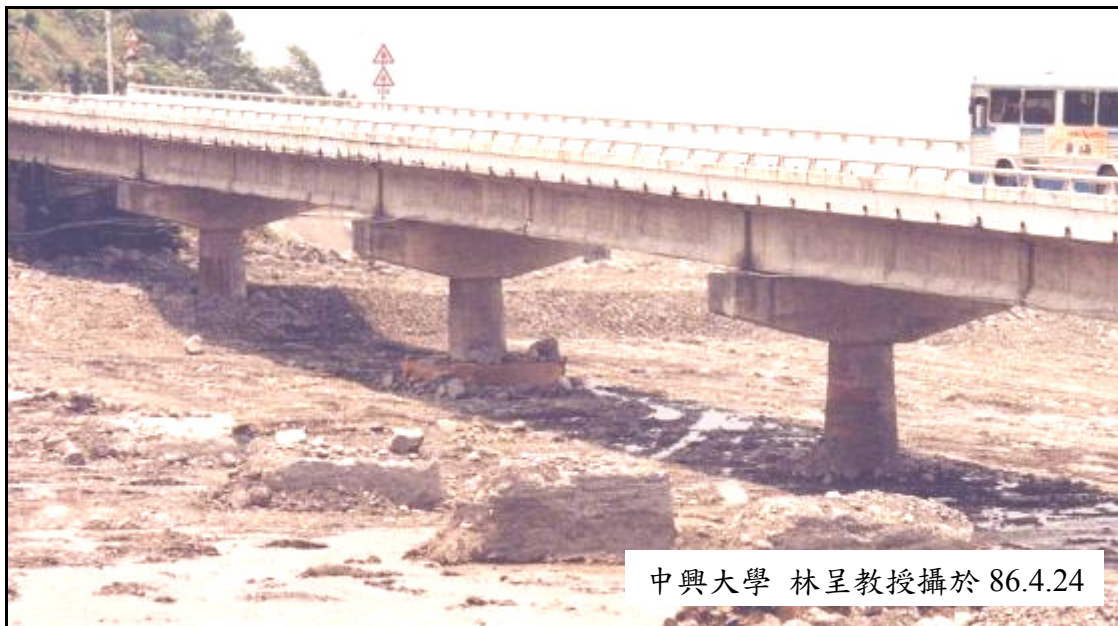
圖 3-44 賀伯颱風過後，信義橋進行 P4 橋墩包墩補強
