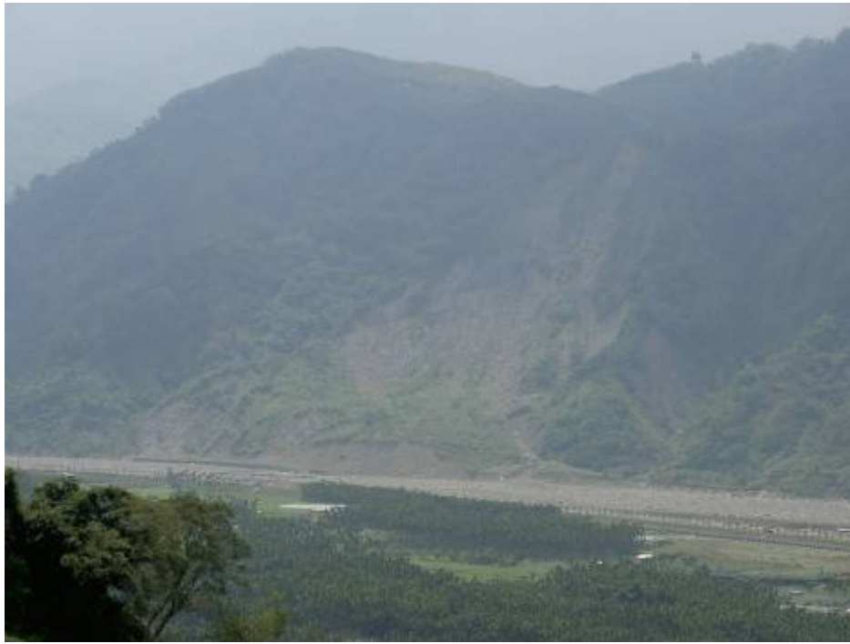
圖 3-5(a) 陳有蘭溪主流左側之河岸崩塌 (郡坑三廊坑溪匯流處對面)
