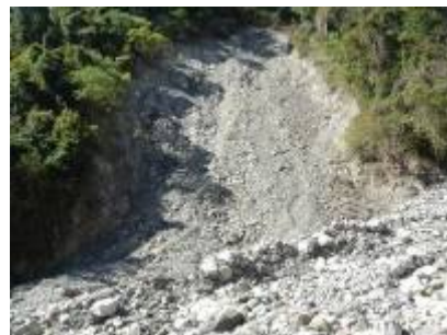
編號 21 號崩塌地現況
