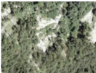
編號 29 號崩塌地現況
