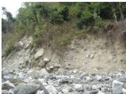
編號 10 號崩塌地現況
