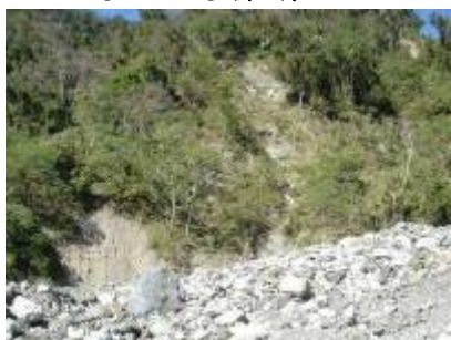
編號 16 號崩塌地現況
