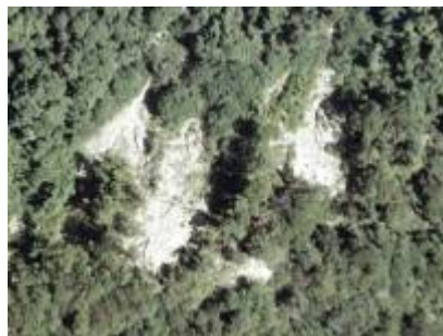
編號 30 號崩塌地現況
