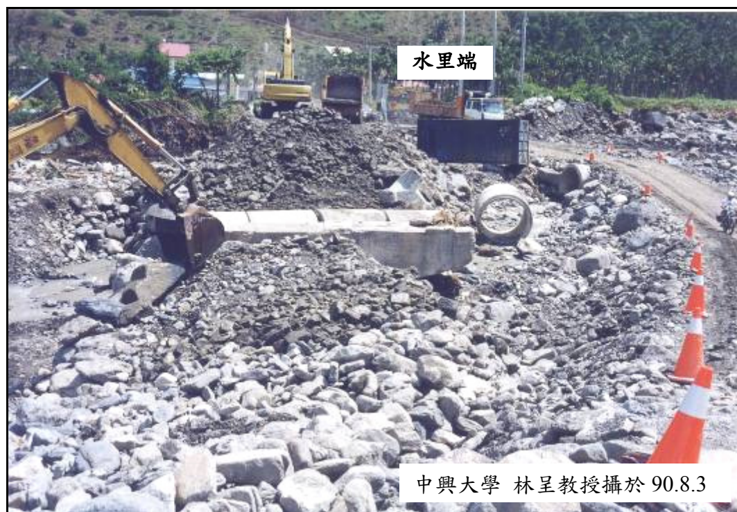
圖 3-47 怪手堆置管涵、清理河道
