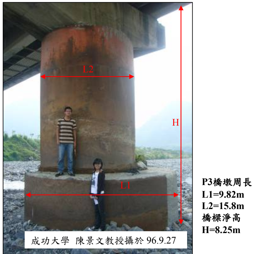
圖 3-49 信義橋修建後 p3 橋墩情形
