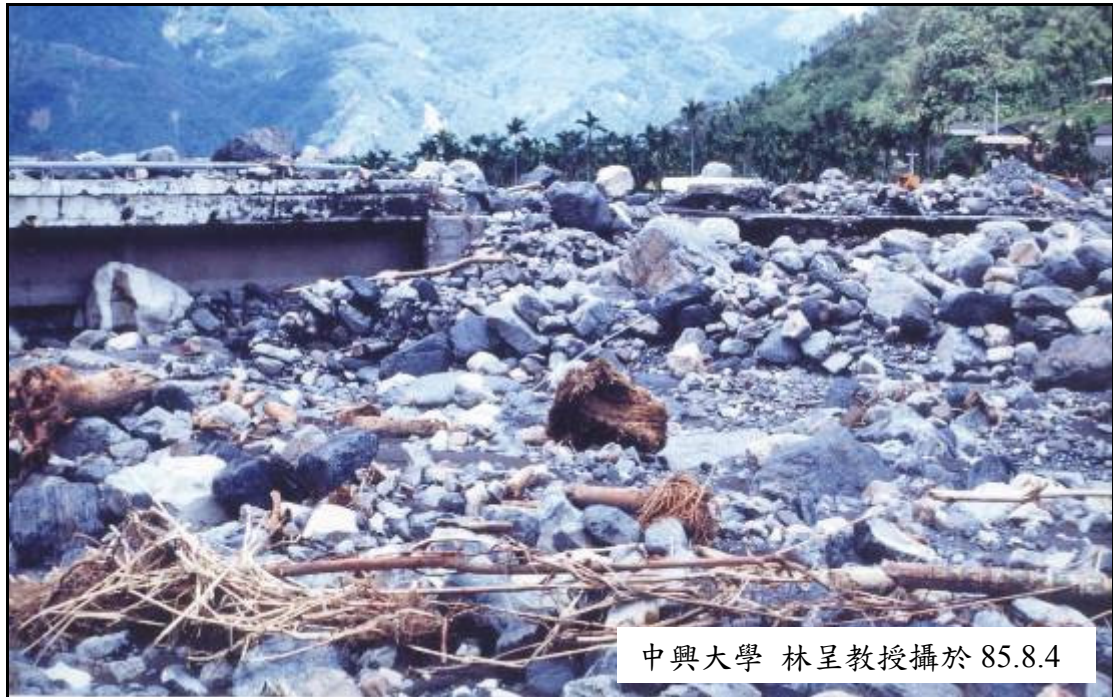
圖 3-40 賀伯颱風期間信義橋 A1 橋台附近大量土石淤積災況 資料來源：交通部公路總局，2005
