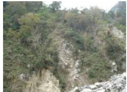
編號 6 號崩塌地現況
