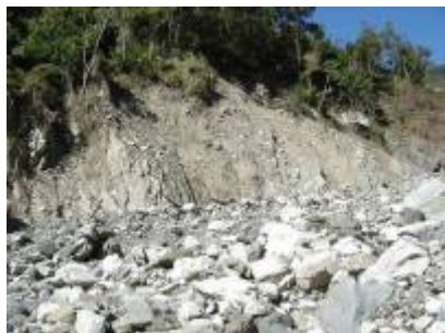
編號 20 號崩塌地現況
