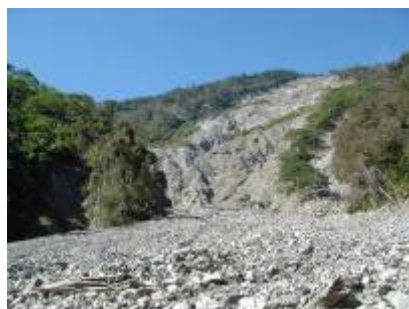
編號 25 號崩塌地現況
