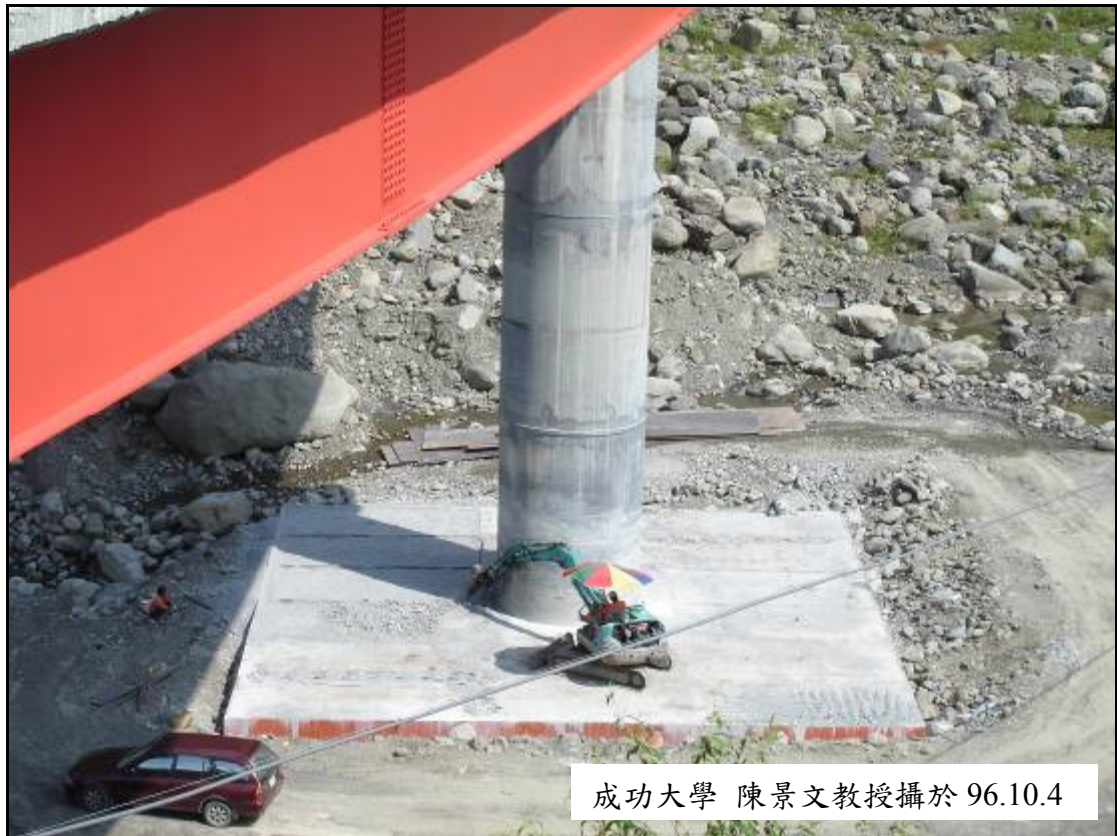
圖 3-79 愛玉橋 P2 橋墩基礎補強情形
