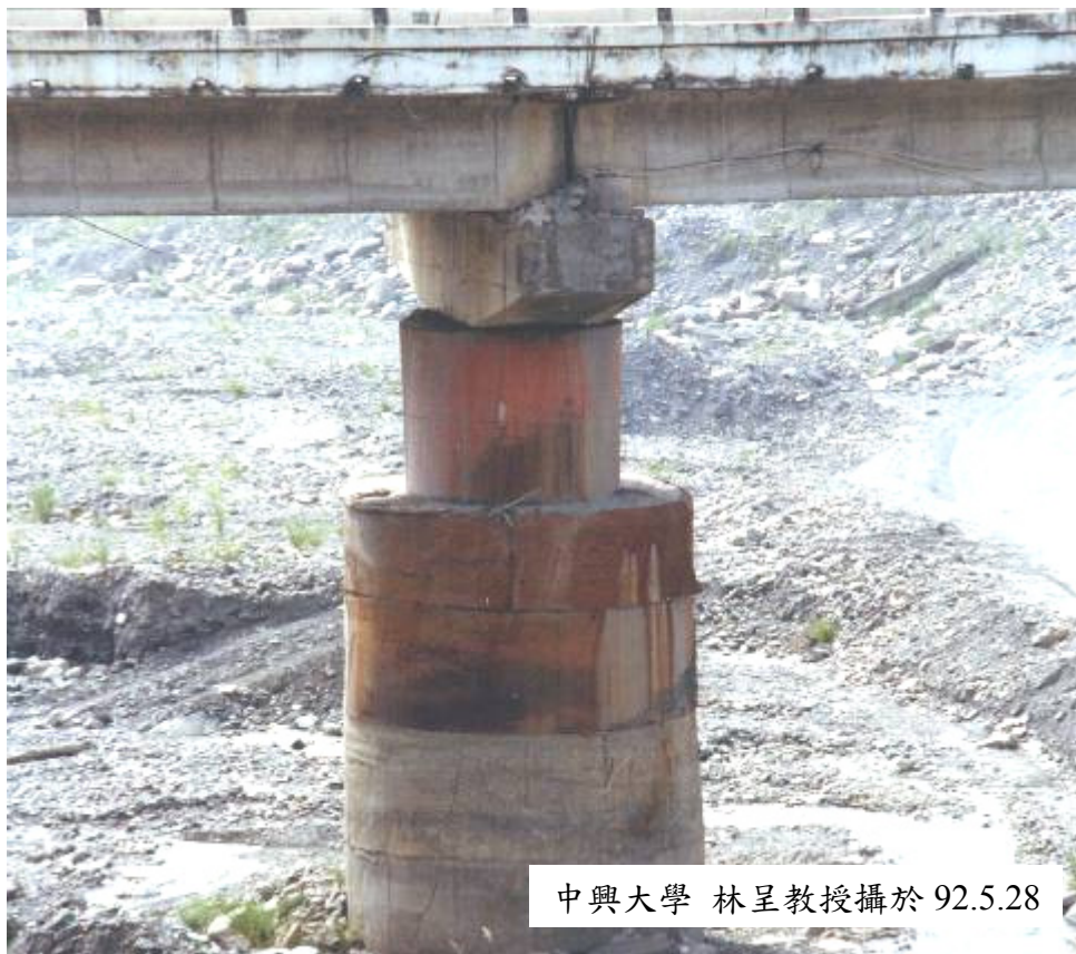
圖 3-45 民國 89 年 921 地震過後，信義橋再度進行包墩補強作業 資料來源：交通部公路總局，2005
