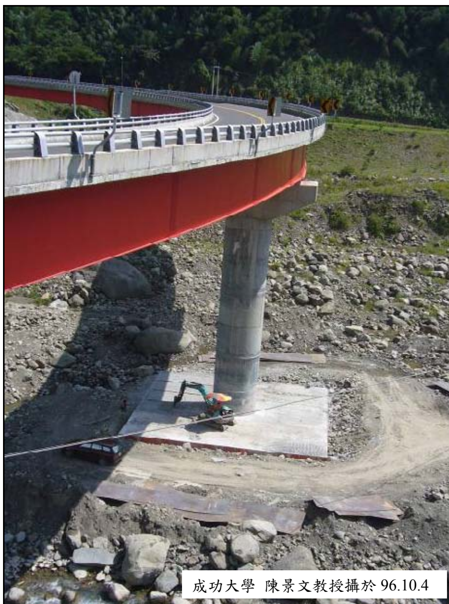
圖 3-78 愛玉橋復建工程完工後現況
