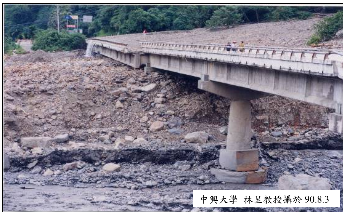
圖 3-54 桃芝颱風過後十八重溪橋 A1 橋台錯位破壞
