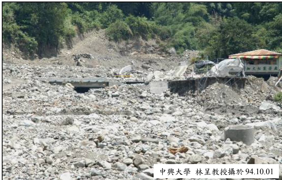
圖 3-73 敏督利颱風後愛玉橋上下游野溪河道遭土石嚴重淤滿之畫面 資料來源：交通部公路總局，2005
