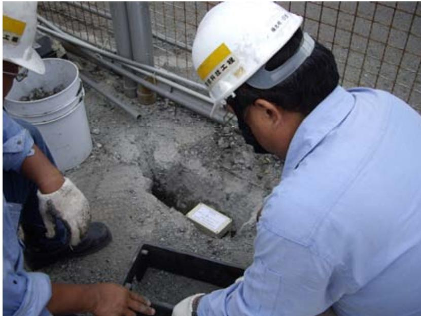
圖 7.21 開挖後裝設陸上地震儀
