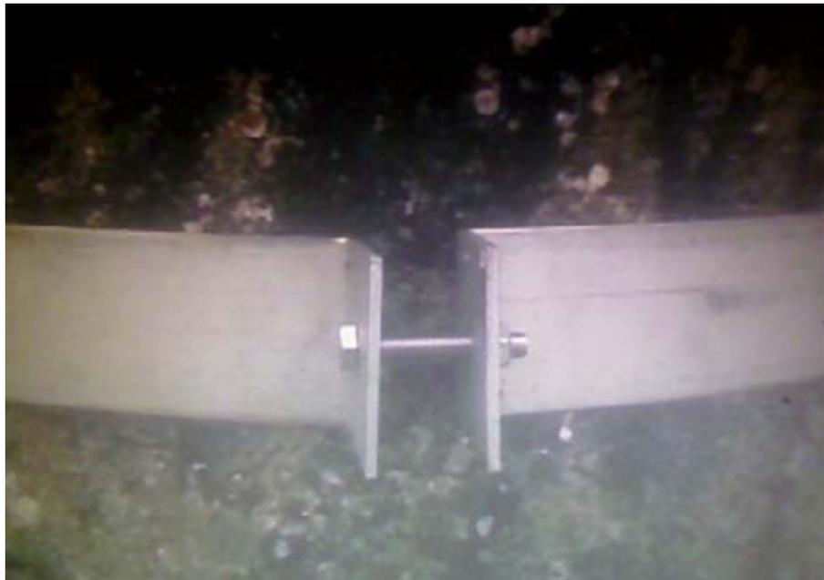
圖 7.17 基樁連結套環裝置完成圖
