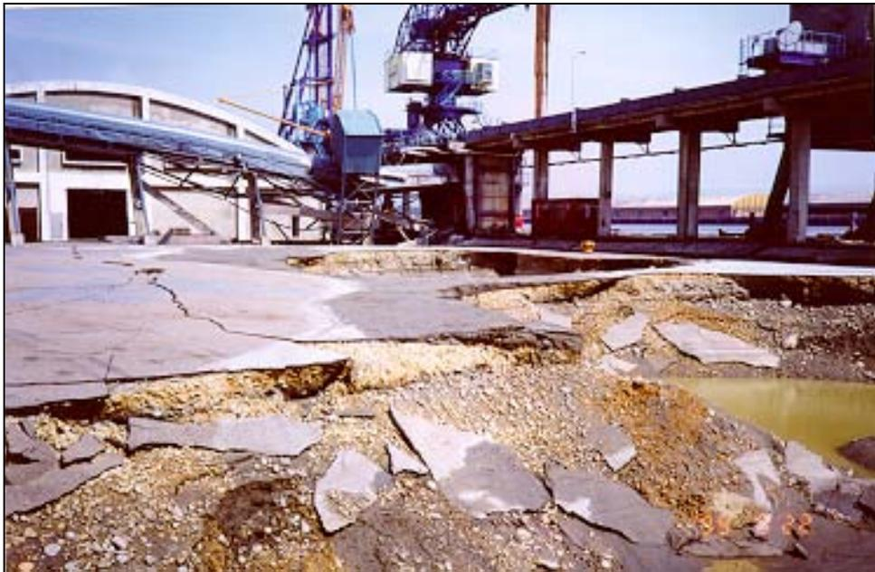
照片 台中港1號碼頭後線背填土之砂液化流失，造成約4-5m深之大坑洞，地表並留下約10cm厚之噴砂
