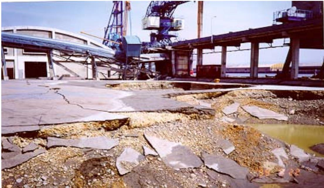
照片 3.3 民國 88 年 921 地震，臺中港 1 號碼頭後線背填土之砂液化流失，造成約 4-5m 深之大坑洞，地表並留下約 10cm 厚之噴砂
