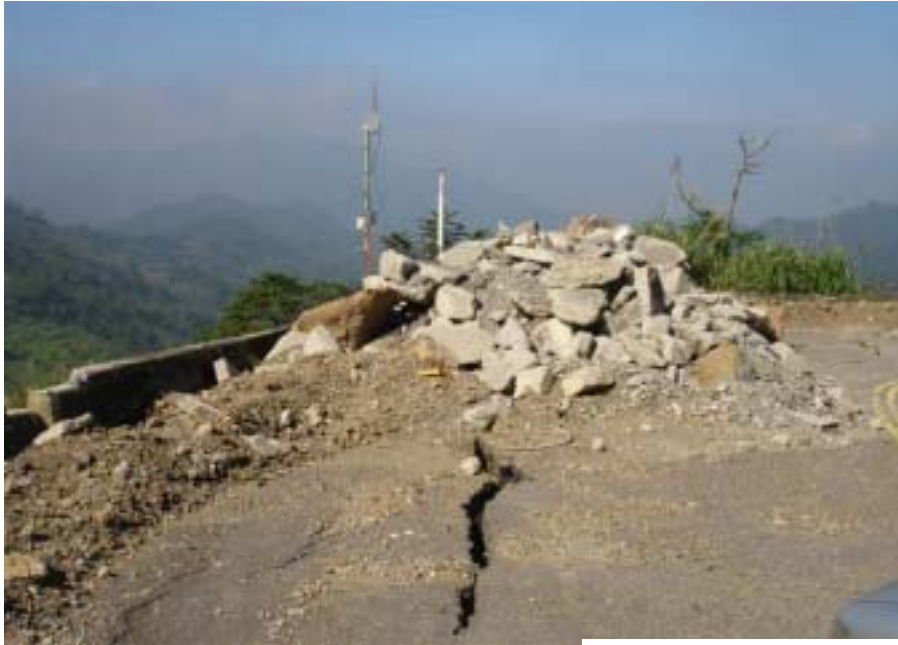
圖 4 - 35 天線 rGPS4 電線桿位移破壞情形
