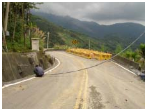
圖 3 - 17 施工架設過程
