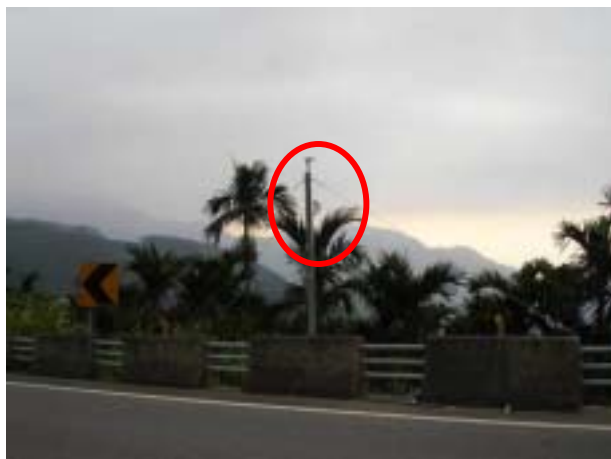
圖 3 - 4 GPS 基站天線位置
