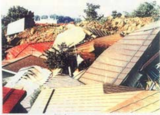
圖 2-2 湯谷小區受損照片
