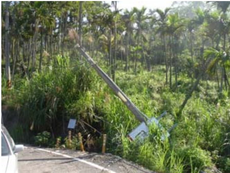
圖 4-34 天線 rGPS3 電線桿位移破壞情形
