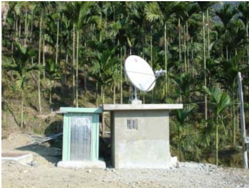
圖 2 - 15 台 18 線 45K 自動化監測儀器小屋
