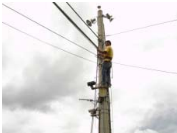
圖 3 - 15 施工配線過程
