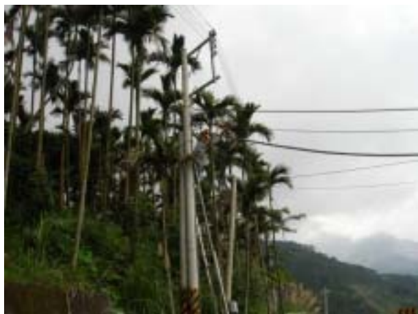
圖 3 - 16 施工架設過程
