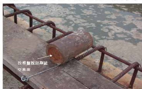
照片 3-5 聯結器拆卸照片(二)
