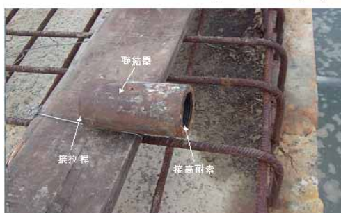
照片 3-4 聯結器拆卸照片(一)
