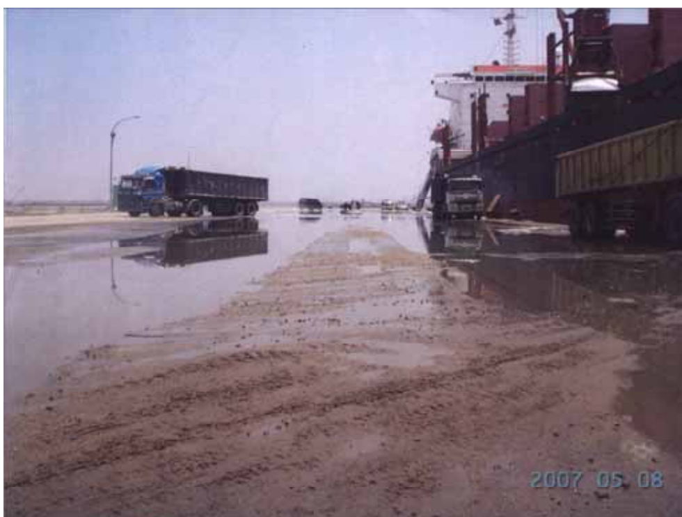
照片 7-1 東 14 號碼頭基地嚴重積水泥濘不堪 (中華顧問工程司提供)
