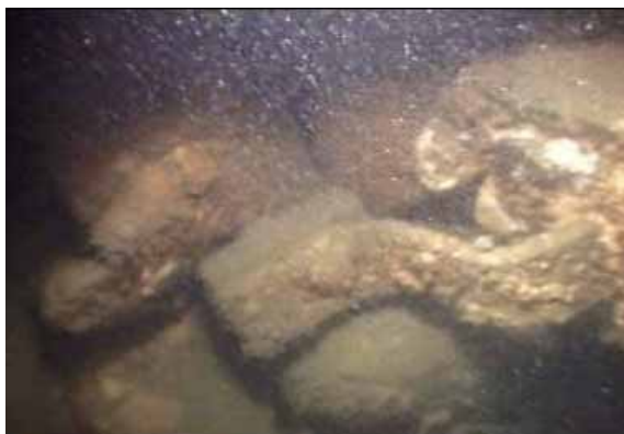
圖 2.18 海床底部陽極塊之鐵蕊鬆脫
