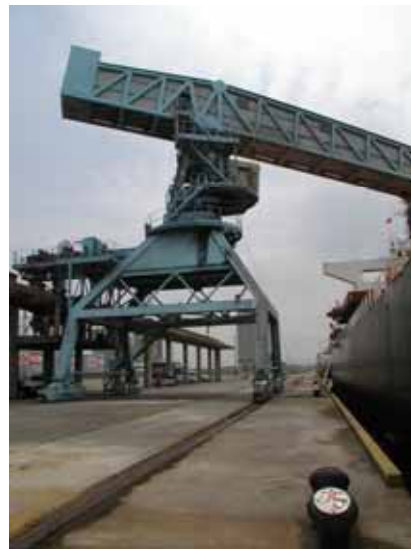
b. 碼頭後線及輸送設施現況
