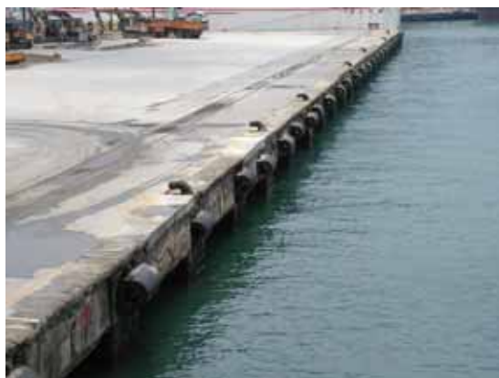
a. 碼頭冠牆及防舷材現況情形
