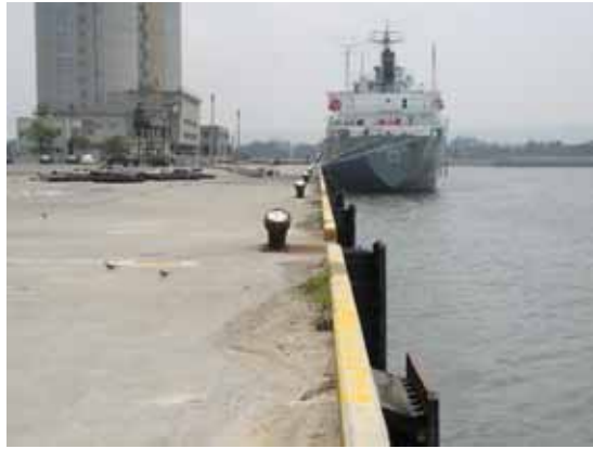
圖 4.11 臺中港 4 號碼頭現況情形
