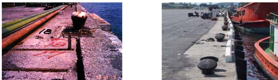
圖 2.7 龜裂、破裂、沉陷、拱起與傾斜之連續循環現象例
