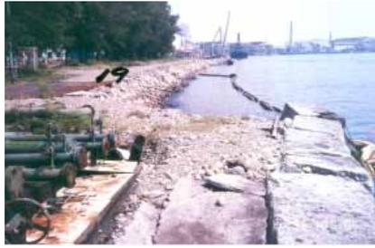
圖 2.8 龜裂、破裂、沉陷、拱起與傾斜之連續循環結果例
