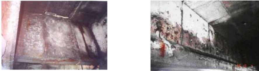
圖 2.5 腐蝕、龜裂與破裂之連續循環現象例
