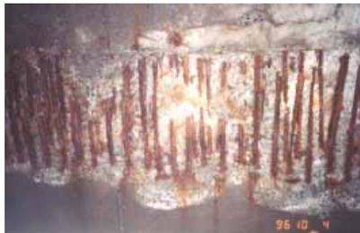
圖 2.6 腐蝕、龜裂與破裂連續循環之結果例
