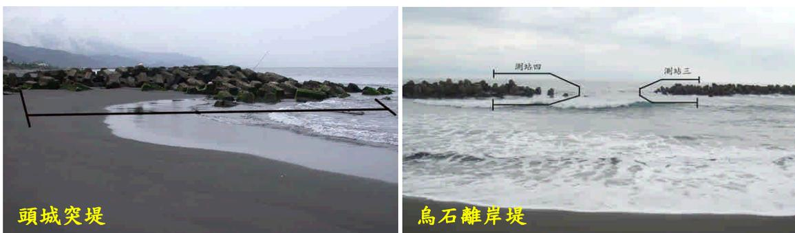
圖 1-5 北部頭城海水浴場南側突堤及北側烏石漁港大坑海堤離岸堤
