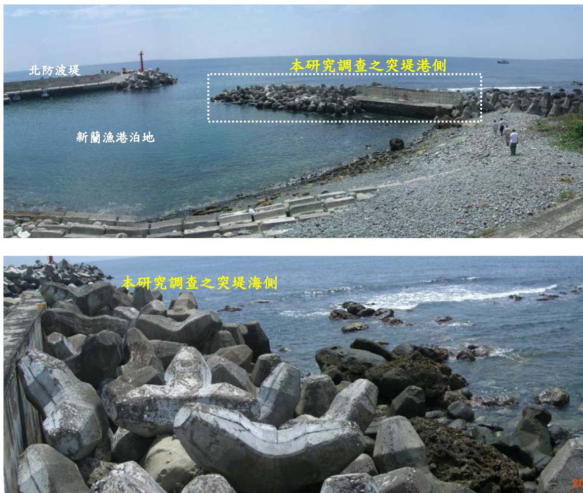
照片 2-3 本研究調查之突堤現況（新蘭突堤）
