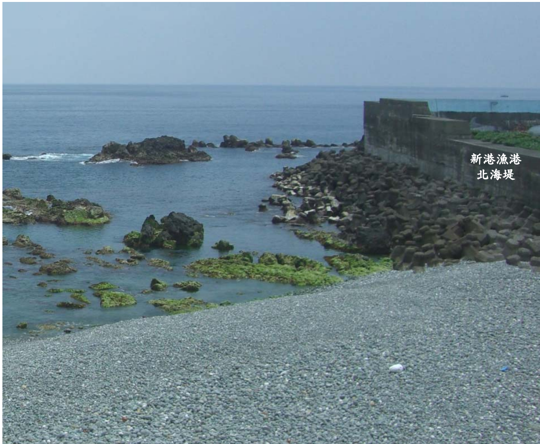
照片 2-2 本研究調查之海堤現況（新港海堤）
