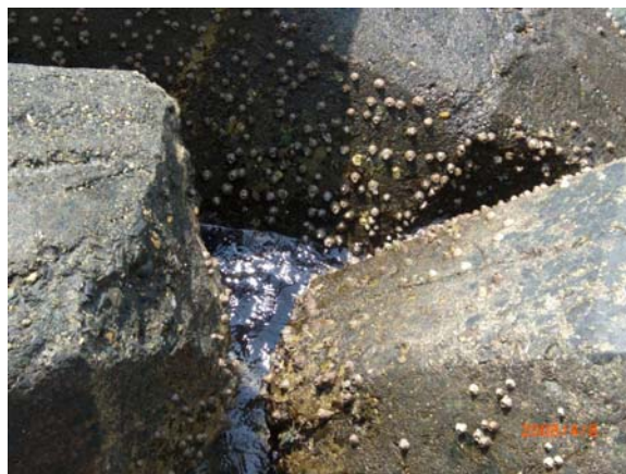
突堤消波塊上著生情形
