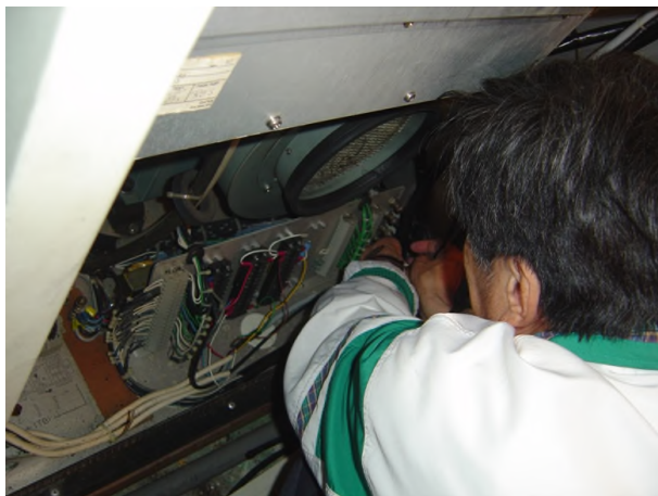
圖 3.3-8 發射機背面施工與接線面板(接 SCA 1 接頭)(花蓮台)
