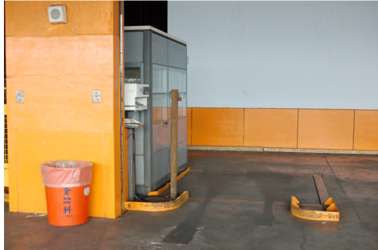
圖 7.122 散貨進倉節點 Dock Door Portal 實體圖(調整前)
