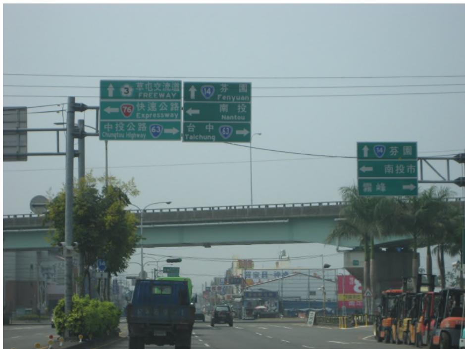
圖 A4.2-6 F 型懸臂式標誌桿例圖
