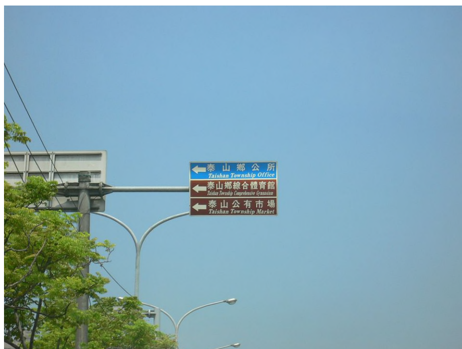
圖 A4.2-4 雙 L 型懸臂式標誌桿例圖
