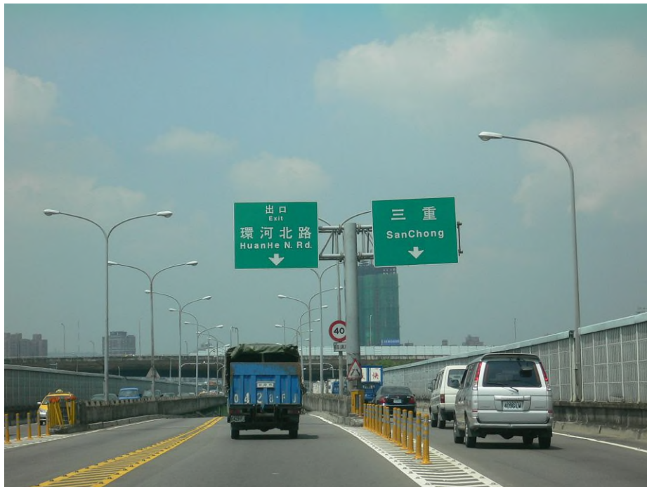
圖 A4.2-8 雙 F 型懸臂式標誌桿例圖
