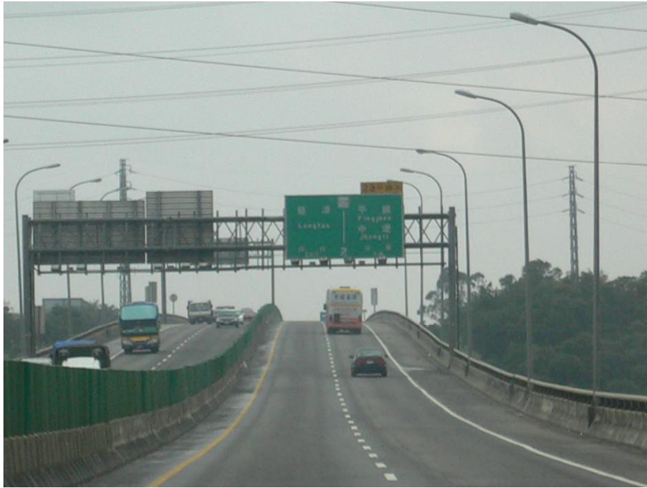
圖 A4.3-1 門架式標誌桿例圖
