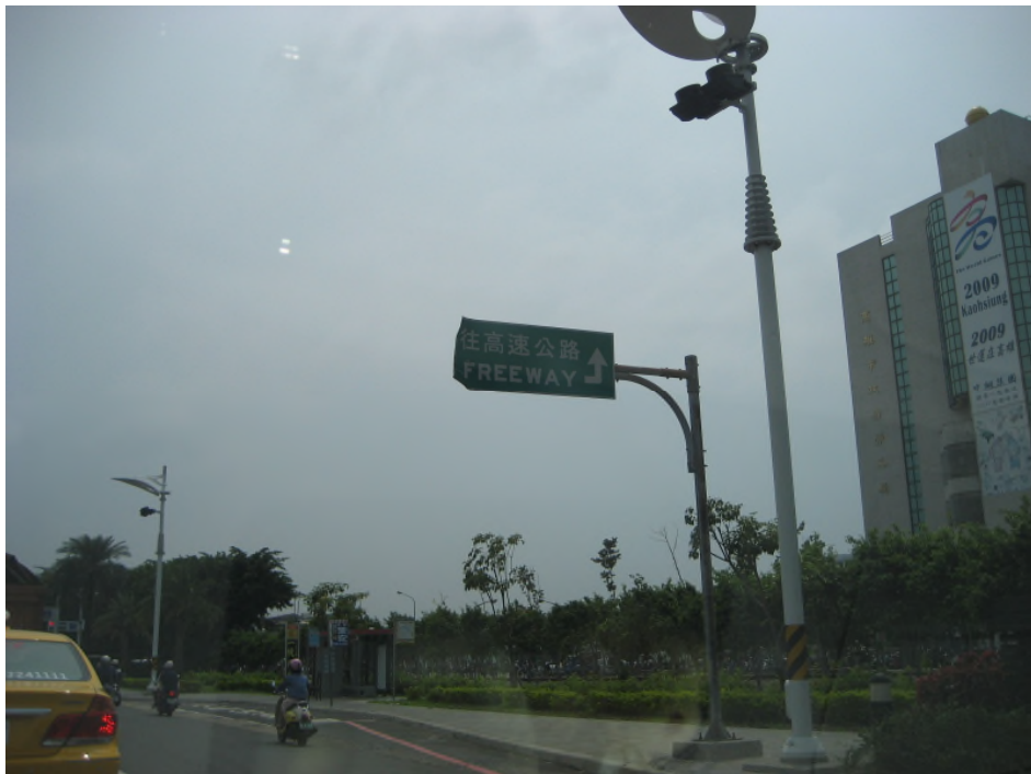
圖 A4.2-2 L 型懸臂式標誌桿例圖
