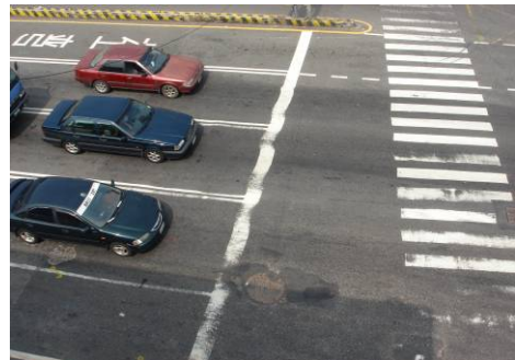
B. 鋪面車轍破壞嚴重
