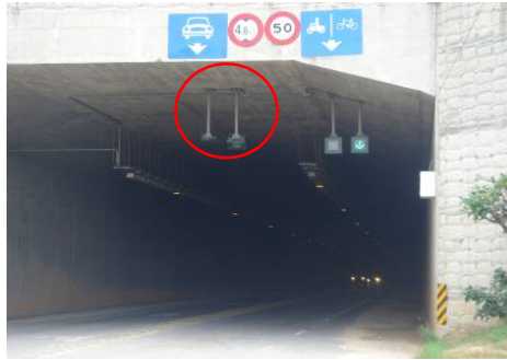
C. 車道管制號誌破損
