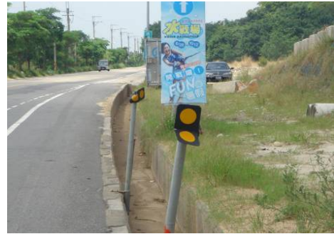
D. 第三類反光導標破損
