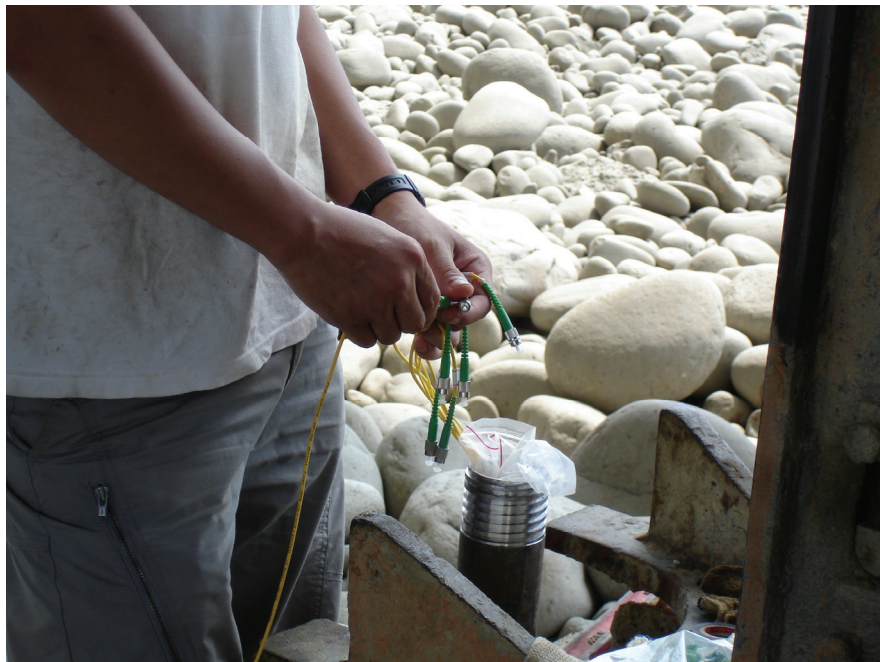
圖 3.12 現地水壓計鑽孔內安裝
