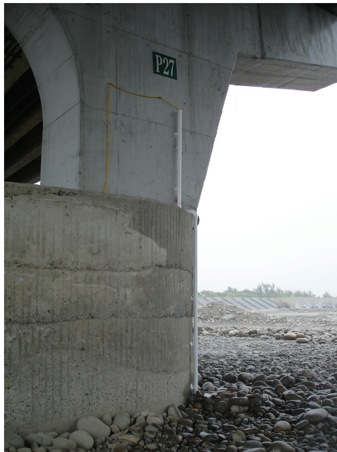
圖 3.16 單一組光纖水壓計保護鋼管安裝完成圖
