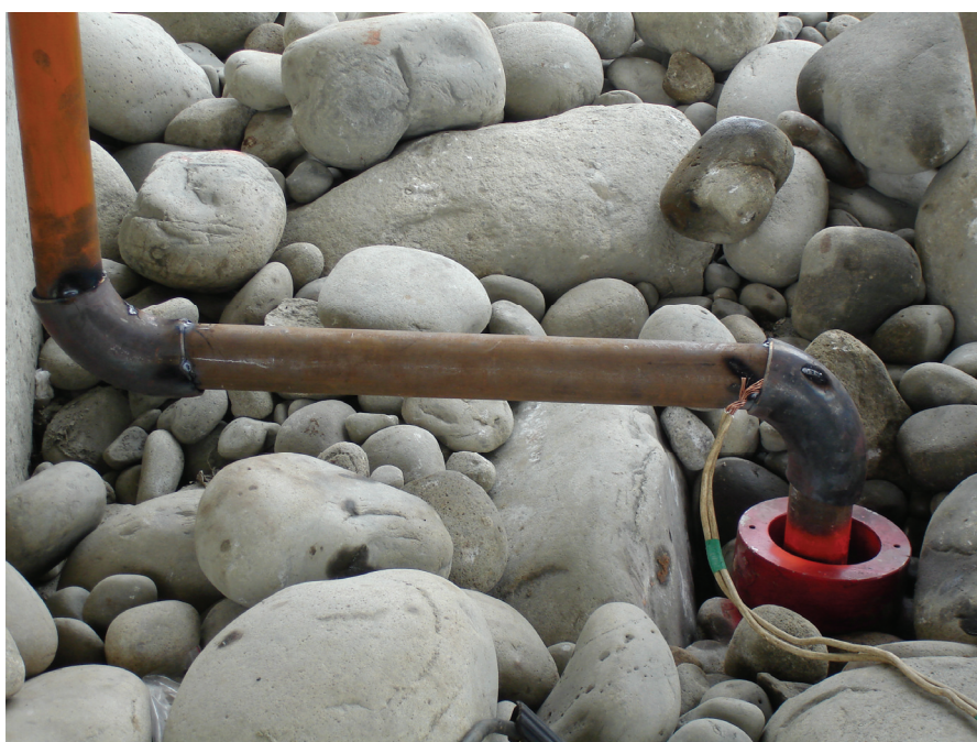
圖 3.14 地面光纖線路保護鋼管
