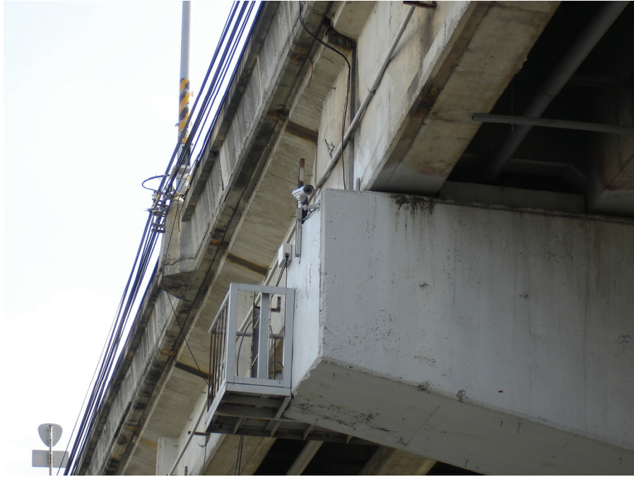
圖 3.22 攝影機安裝完成圖
