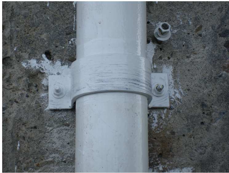
圖 3.15 光纖線路保護鋼管固定於橋墩上
