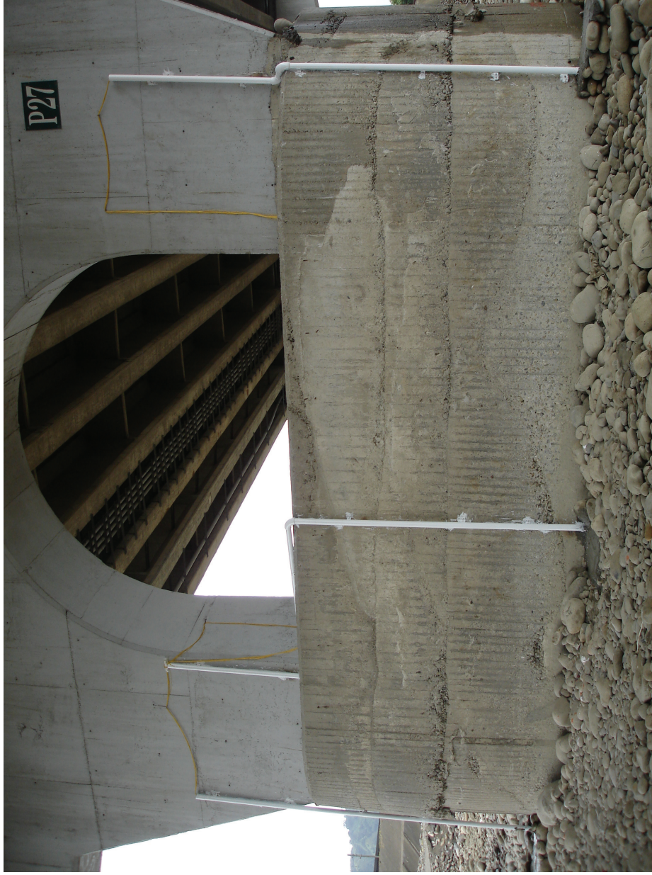
圖 3.17 三組光纖水壓計保護鋼管安裝完成圖
