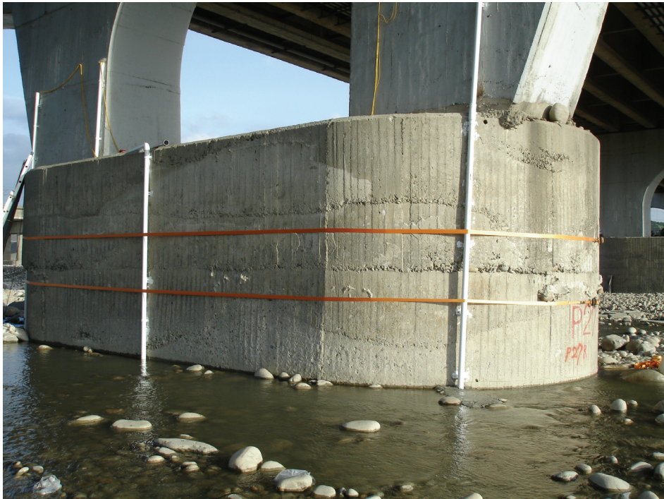
圖 3.19 強力束帶保護安裝完成圖
