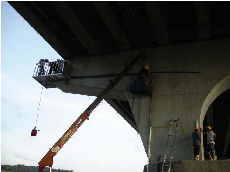
圖 3.21 光纜架設施工圖
