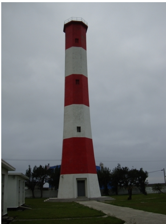
圖 1.7 台中港高美燈塔
