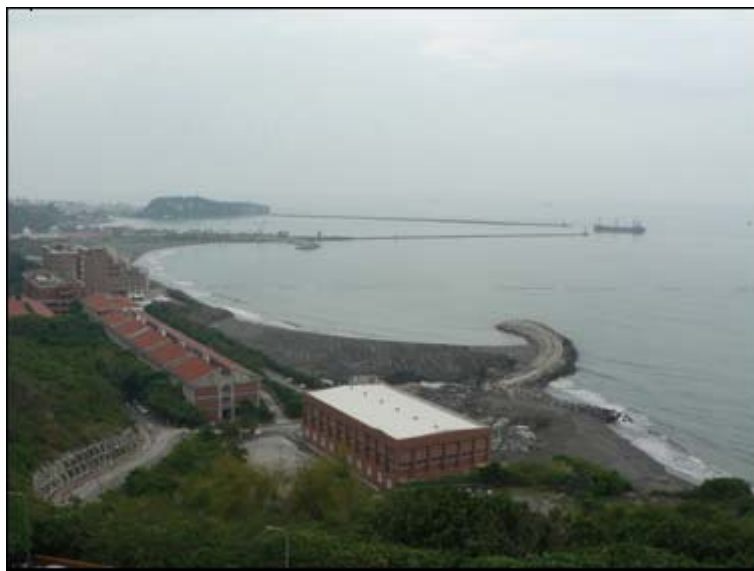
圖 1.4 人工岬灣及養灘工程完工後之月彎型沙灘(郭少谷等，2008)
