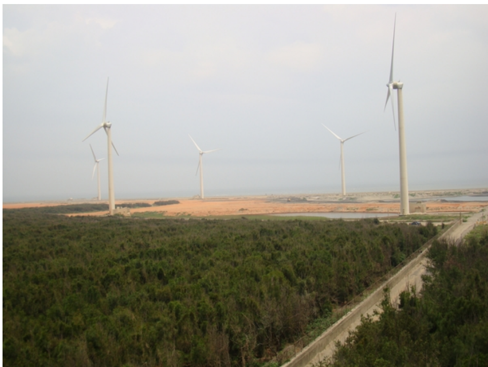
圖 1.6 台中港觀測塔位置右側海域圍堤內之風力發電場址
