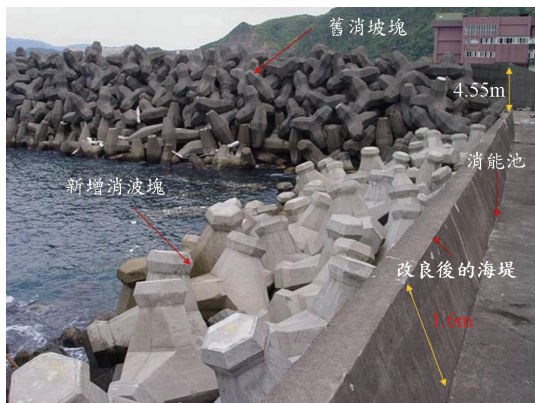
照片 10(c) 降低堤頂高程後之海洋大學工學院後方海堤
