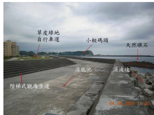
照片 10(c) 降低堤頂高程後之海洋大學工學院後方海堤
