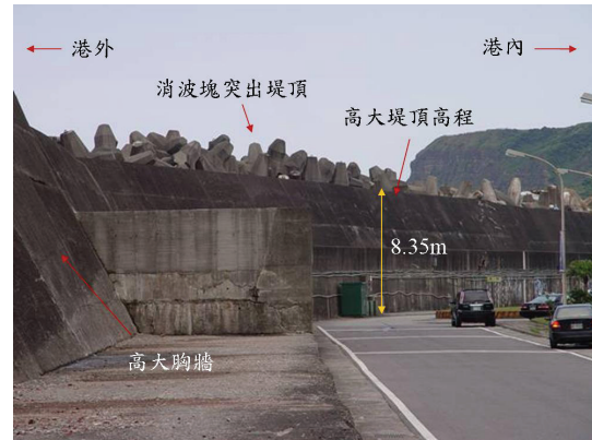
照片 10(b) 以高大海堤及消波塊構成之海岸保護工法(左視)
