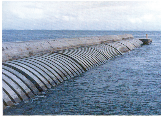
圖 37 凸型曲面防波堤(日本船川港)
