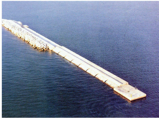
圖 37 凸型曲面防波堤(日本船川港)
