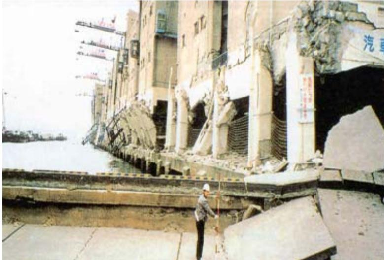
圖 2.4 日本阪神地震神戶港鈹樁式碼頭岸肩沈陷受損情形
