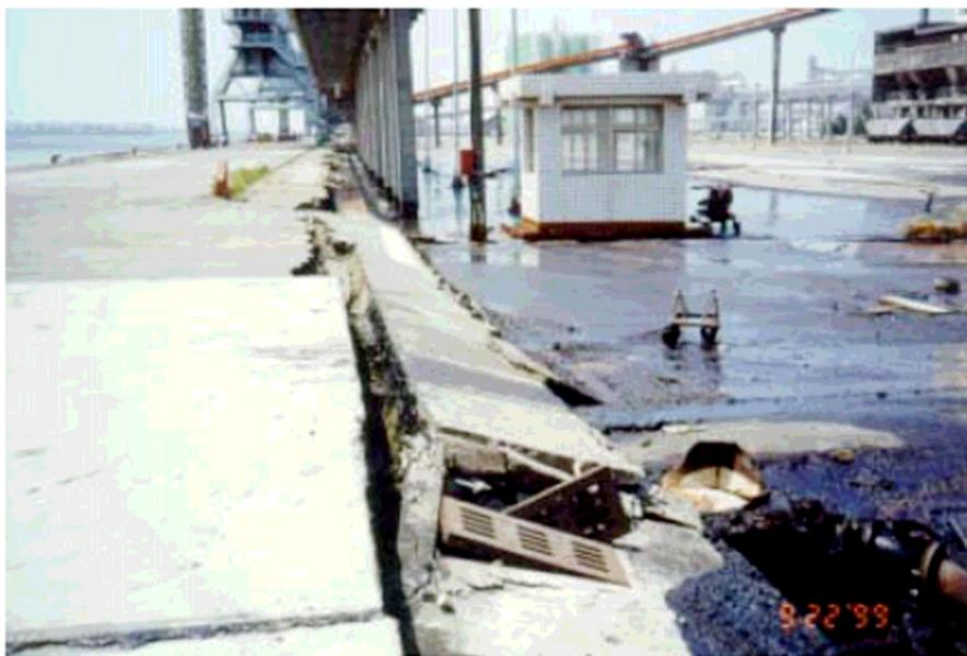
圖 2.2 臺中港#1~4 沈箱碼頭於 921 震後碼頭岸肩與後線高程差側視圖
