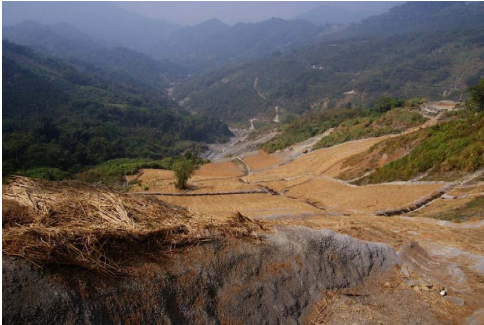
圖 3-16 GPS 監測區災前護坡工程
