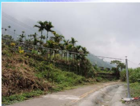
高架線路支撐固定
