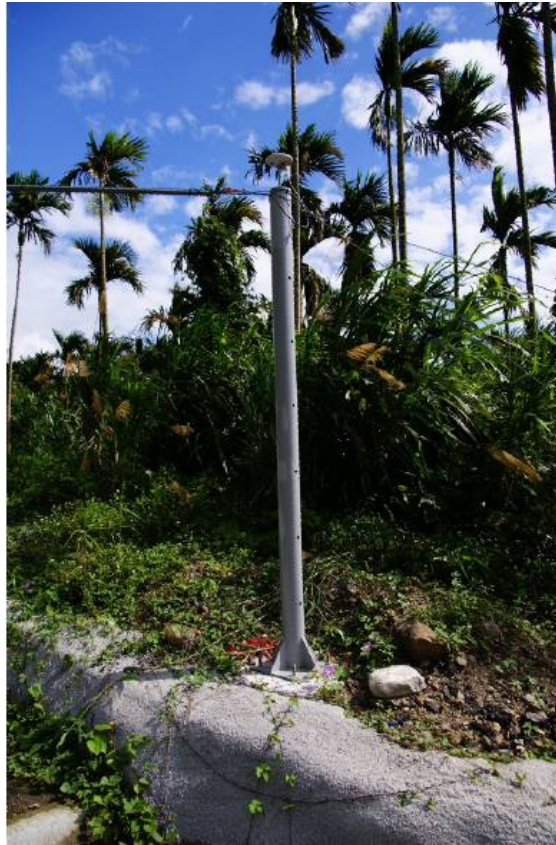
圖 3-5 98 年 6 月 16 日現場維護作業
