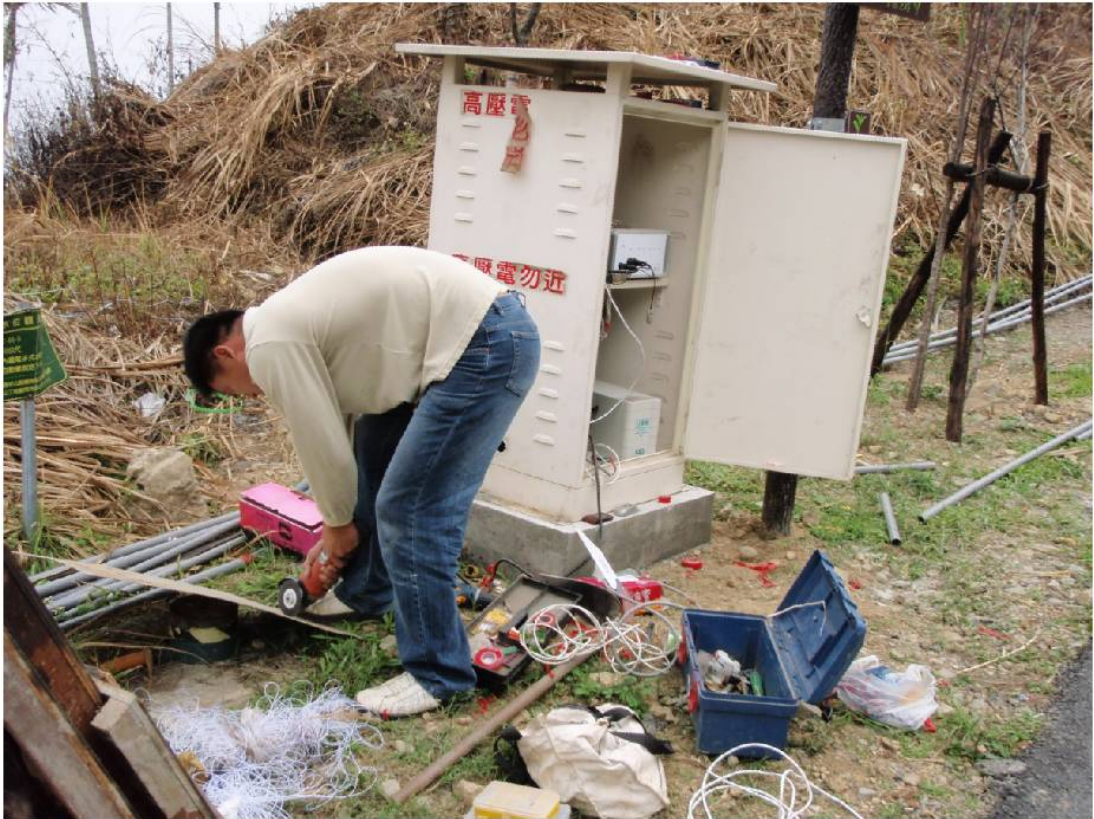
圖 4-42 接收主機安裝架設
