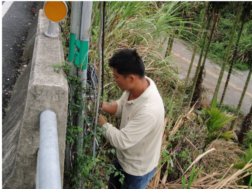
圖 4-41 訊號配線作業
