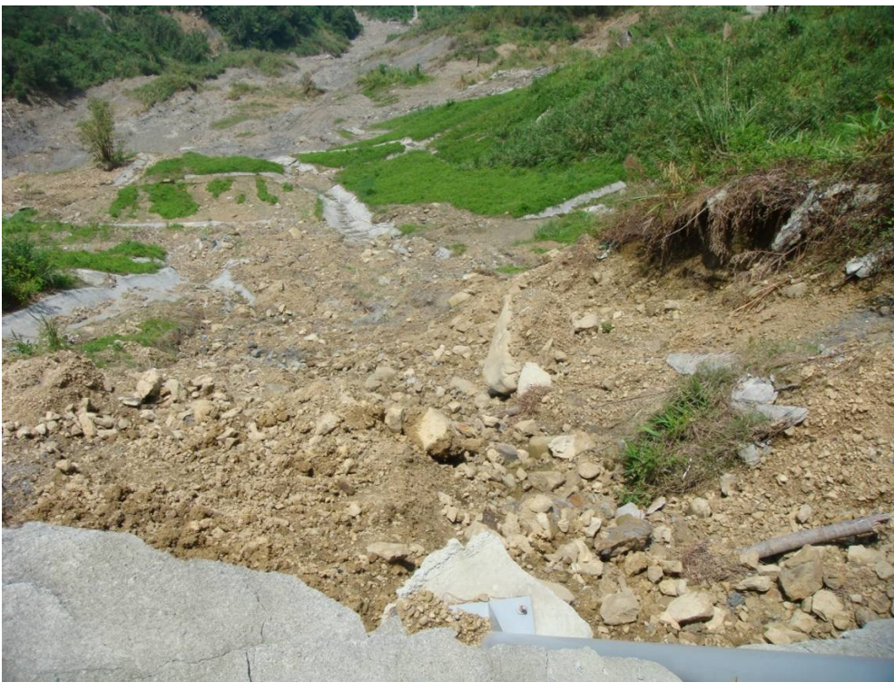
圖 3-17 GPS 監測區災後崩塌
