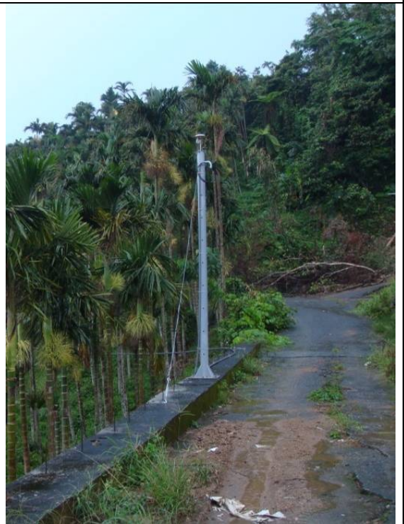
基站天線正常
