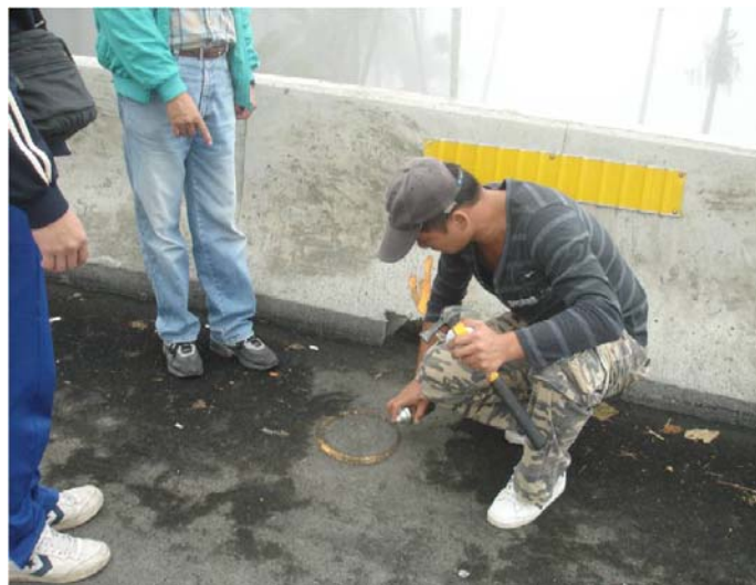
圖 5-21 第四彎靜態測量位置現勘
