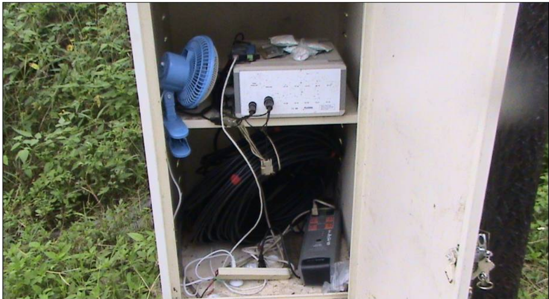
圖 3-18 98 年 9 月 23 日現場維護作業
