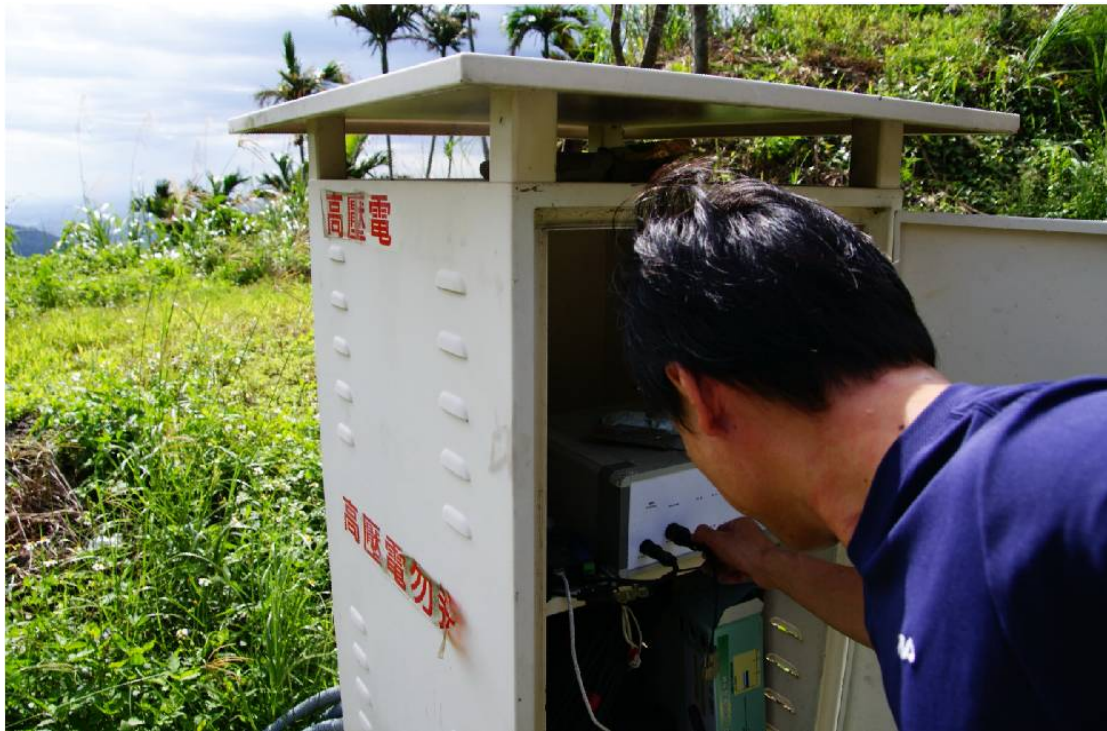
圖 3-7 98 年 7 月 24 日現場維護作業
