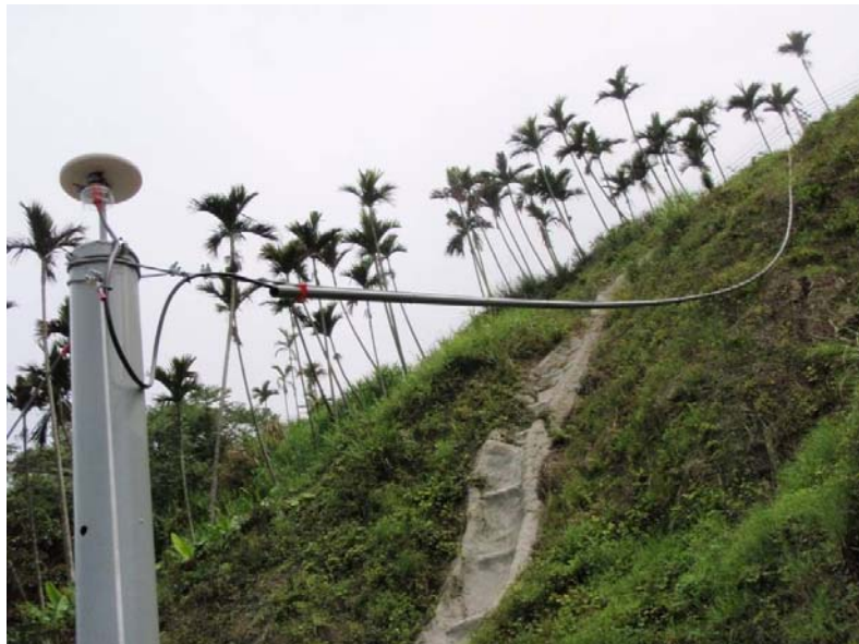
圖 4-14 PVC 管保護傳輸線作業情形
