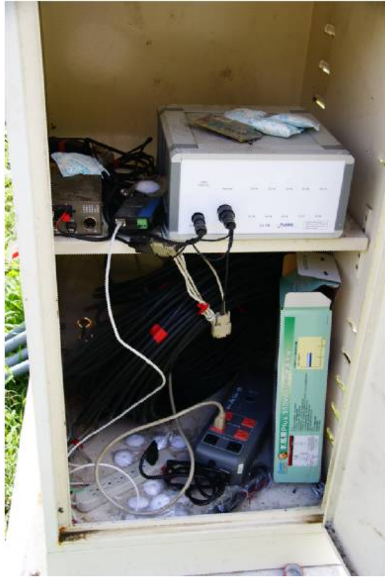
圖 3-4 98 年 5 月 28 日現場維護作業
