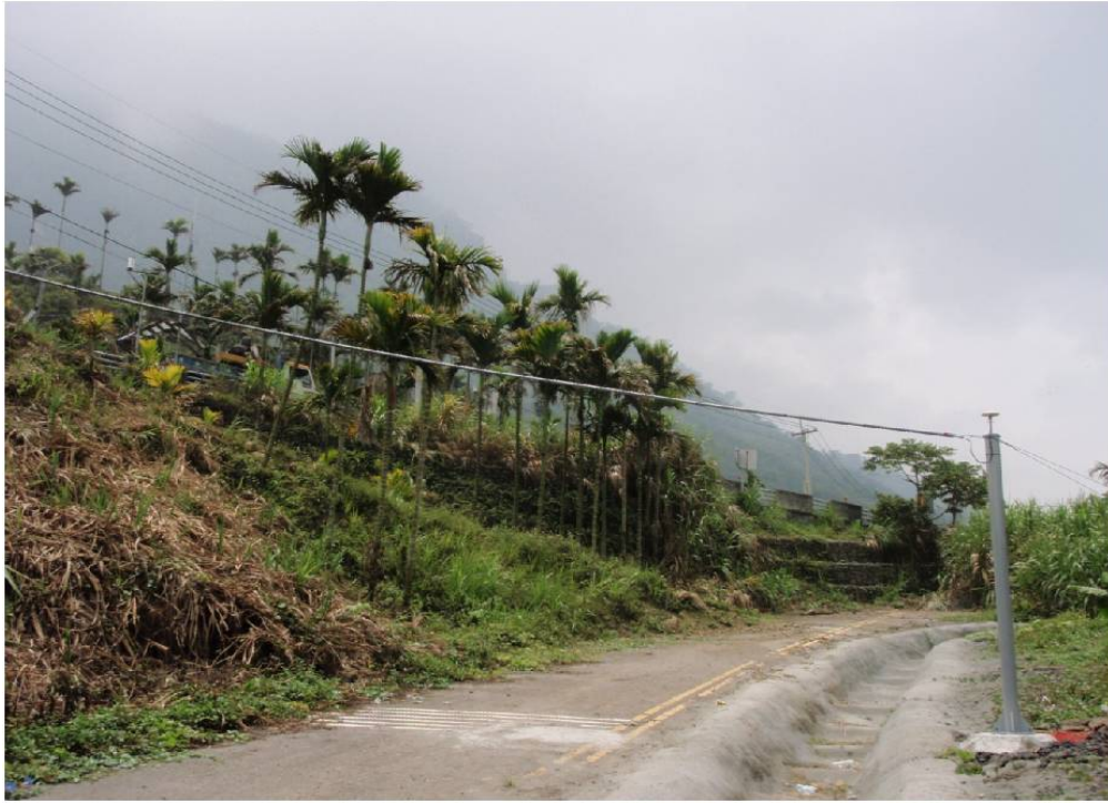
圖 4-40 高架線路強化保護固定
