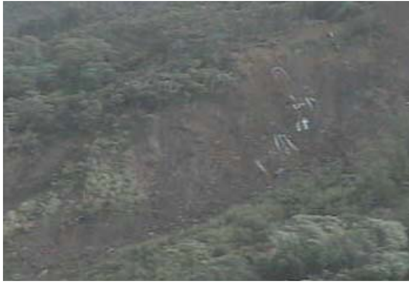
圖 2-14 小公田村 CCD#2 傳回之崩塌區影像
