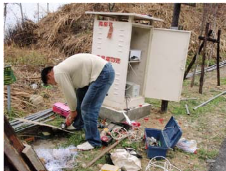
接收主機機箱架設
