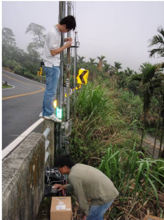
圖 3-2 98 年 4 月 21 日現場維護作業
