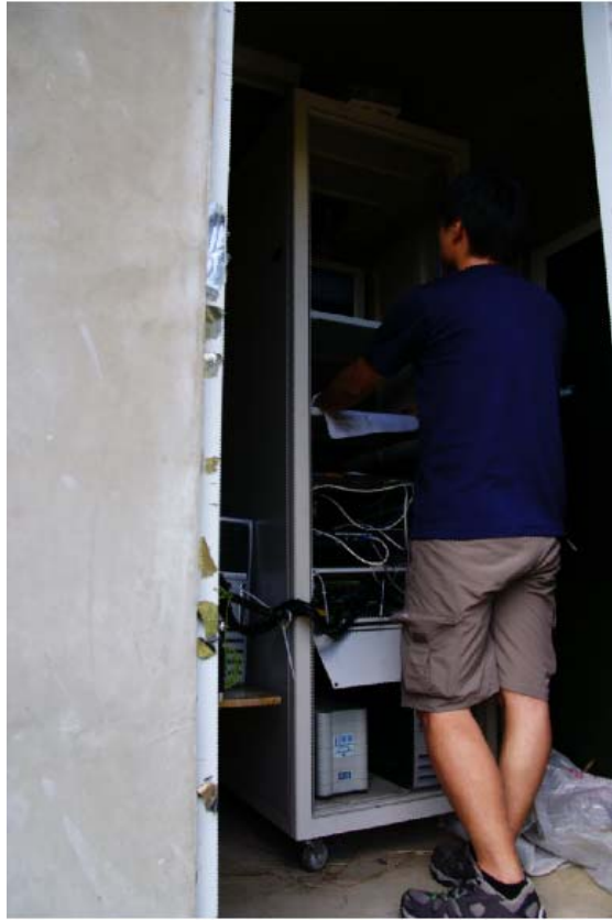
圖 3-6 98 年 6 月 20 日現場維護作業
