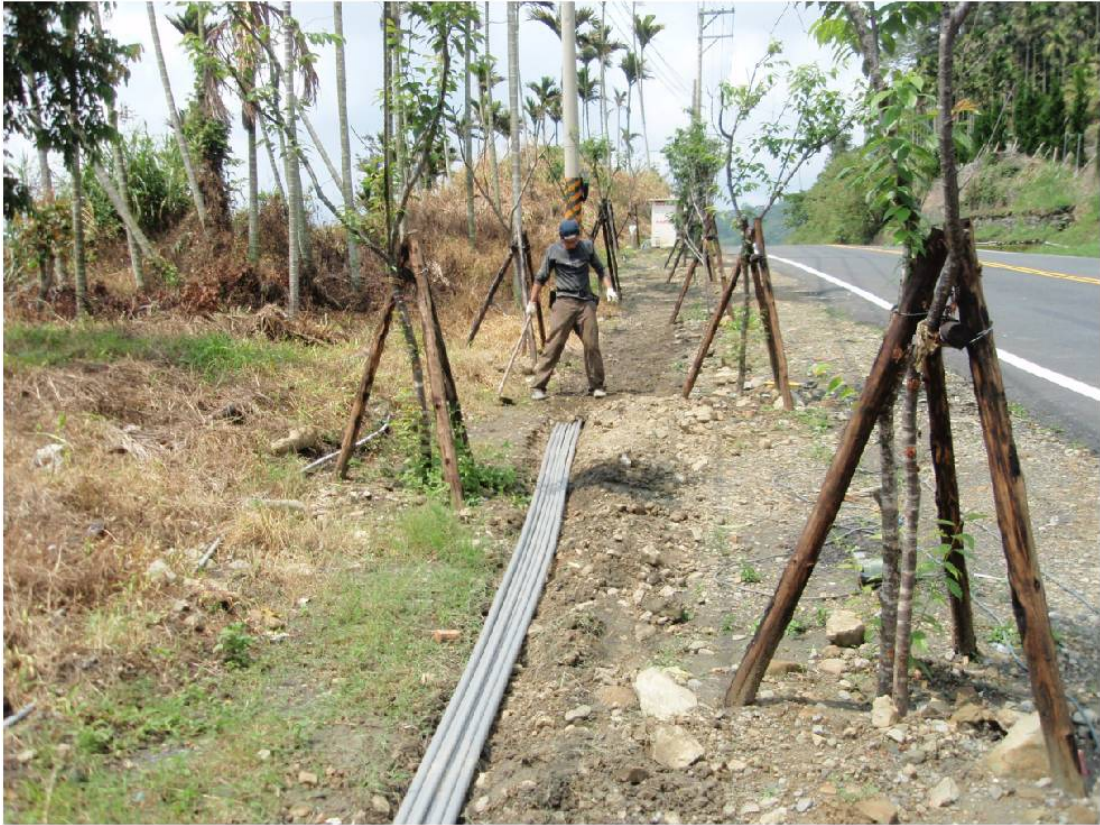
圖 4-43 線路埋設作業
