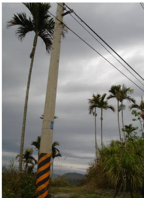
圖 4-19 GPS3 架設位置現勘
