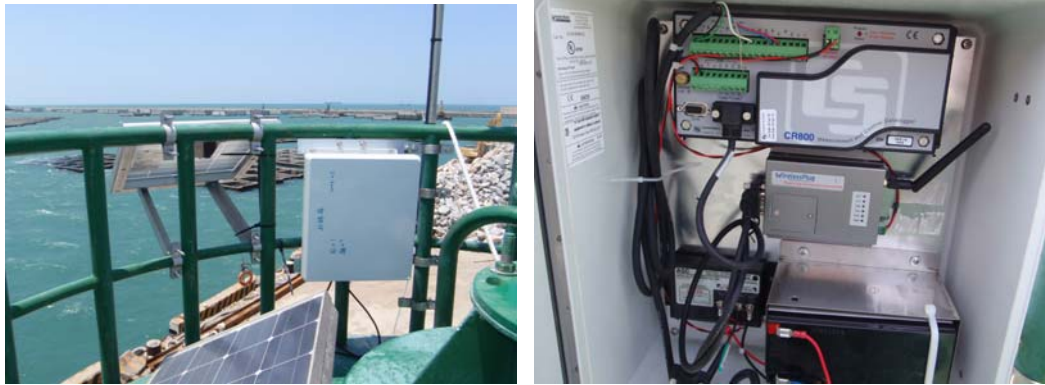
圖 2.5 臺北港堤頭風速計觀測系統設置工作
