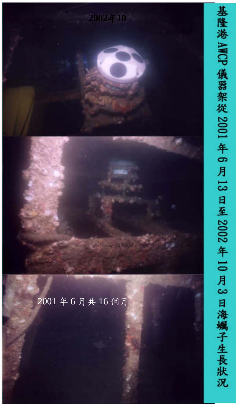
圖 2.14 AWCP 監測系統水下安裝後之狀況圖(3)
