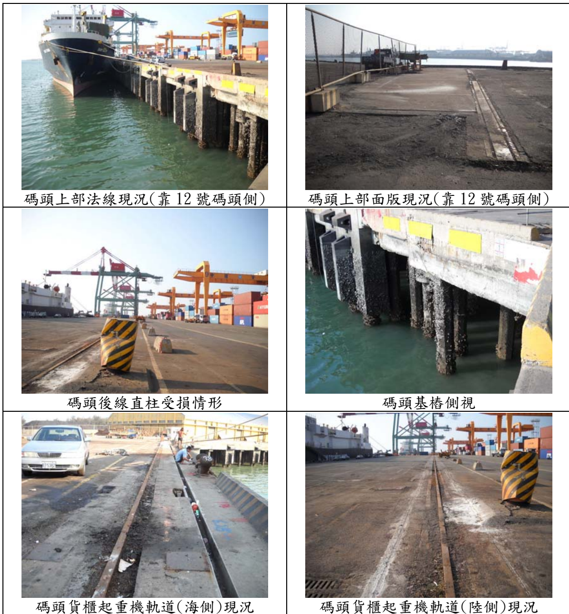
圖 21 臺中港 11 號碼頭上部結構檢測項目相關照片
