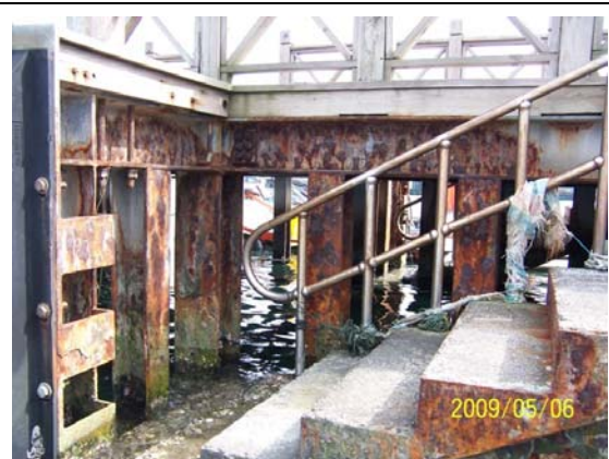
棧橋碼頭基樁鋼材鏽蝕情形
