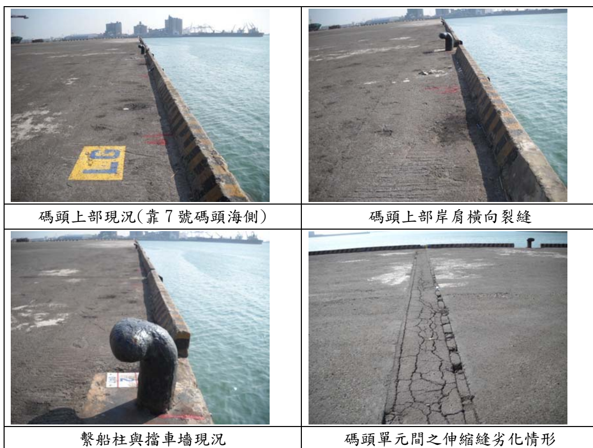
圖 17 臺中港 8A 碼頭上部結構檢測項目相關照片
