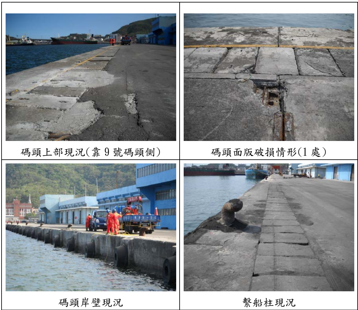
圖 24 蘇澳港 10 號碼頭上部結構檢測項目相關照片
