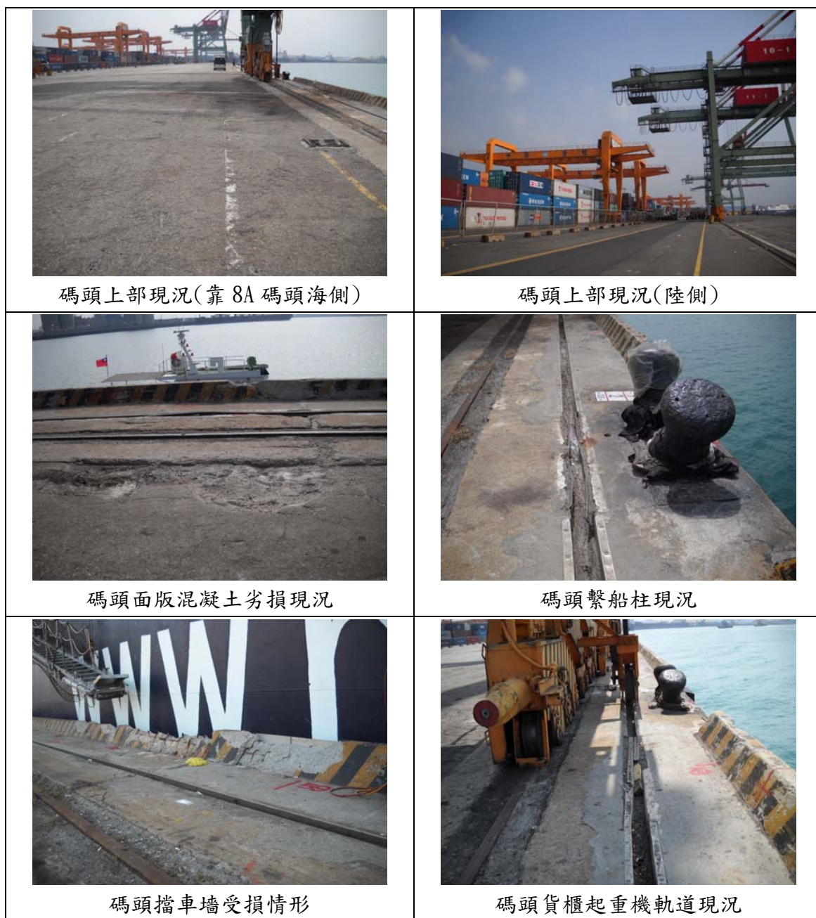
圖 19 臺中港 9 號碼頭上部結構檢測項目相關照片
