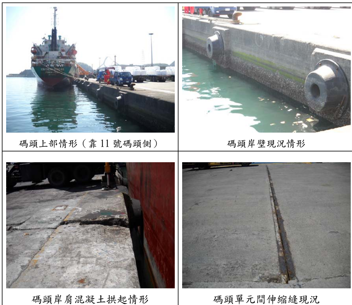
圖 26 蘇澳港 12 號碼頭上部結構檢測項目相關照片
