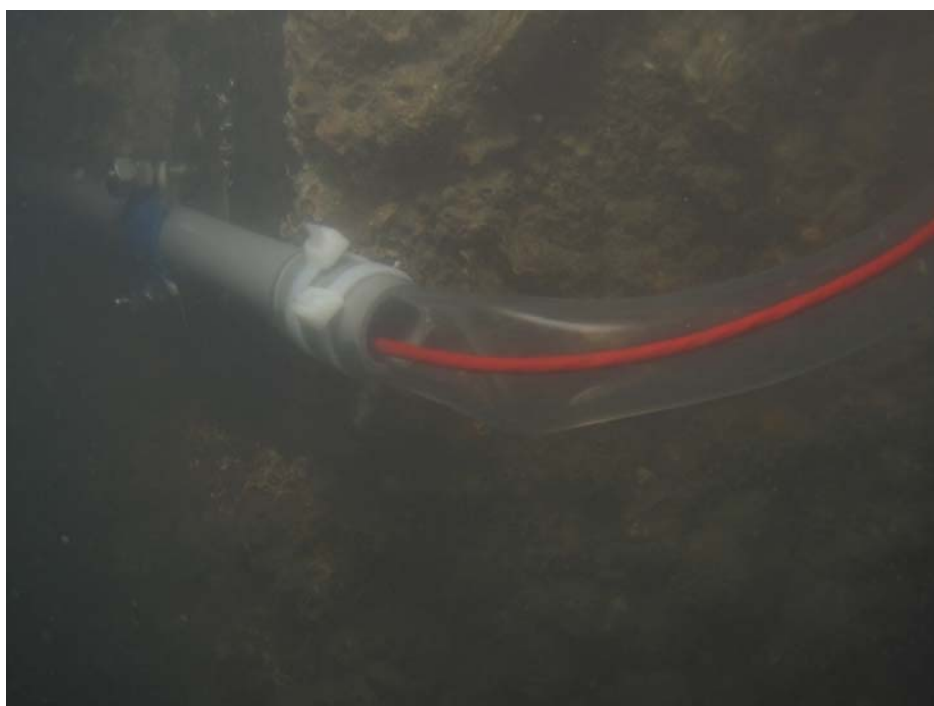
圖 5.4 水下訊號線固定
