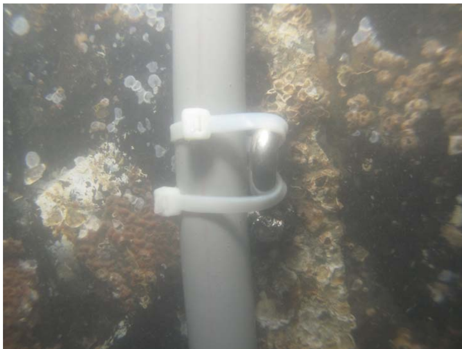
圖 5.3 動態剖面位移計水下安裝完成圖
