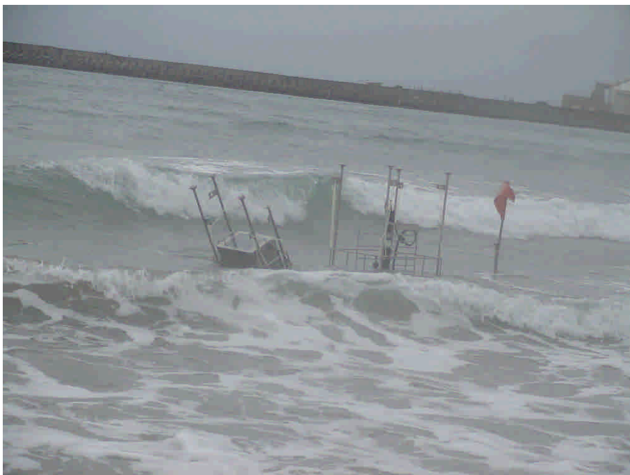
圖 1.9 安裝完成之碎波帶內觀測儀器
