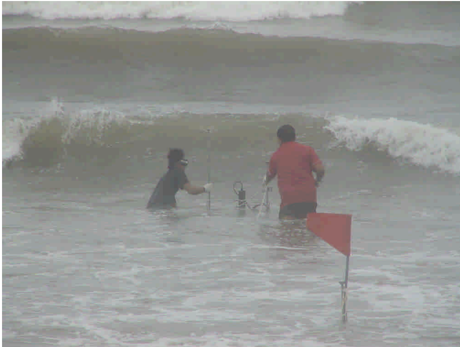
圖 1.8 淡水河口北側之沙崙海岸觀測儀器安裝作業情形
