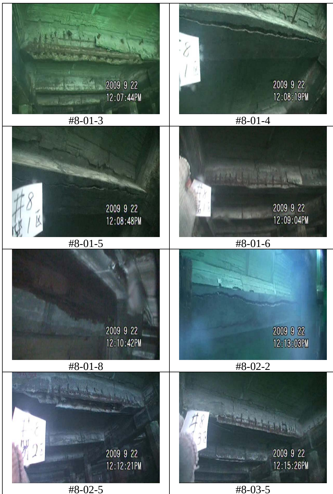
圖 12 臺中港 8 號碼頭調查照片-1
