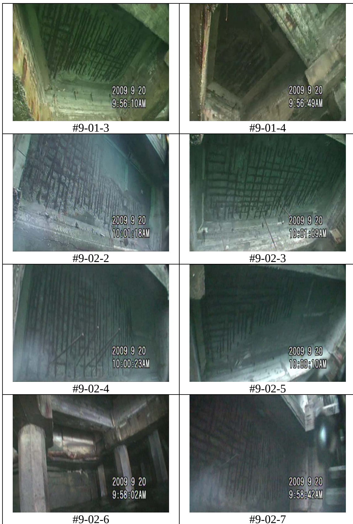
圖 17 臺中港 9 號碼頭調查照片-1
