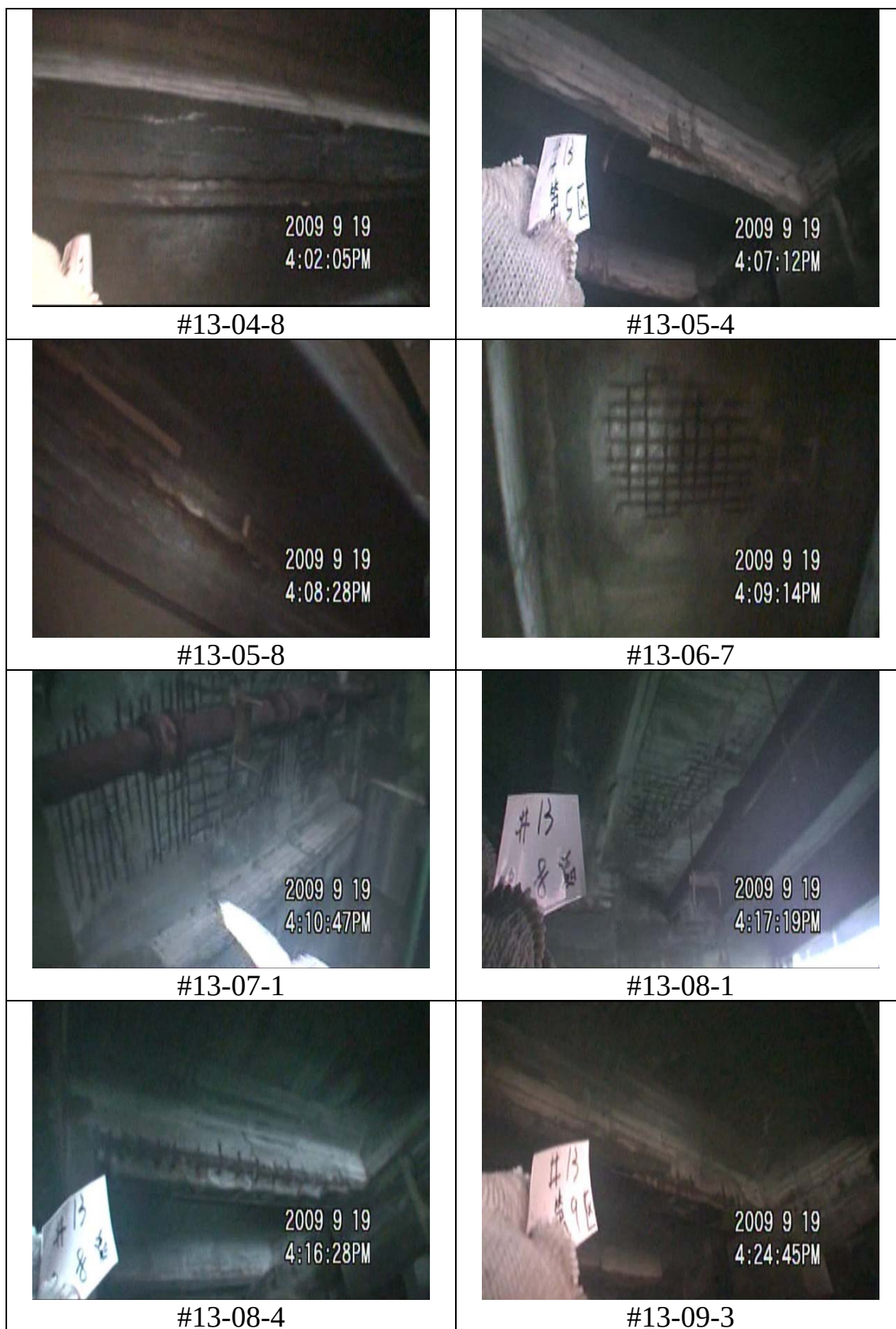
圖 26 臺中港 13 號碼頭調查照片-1
