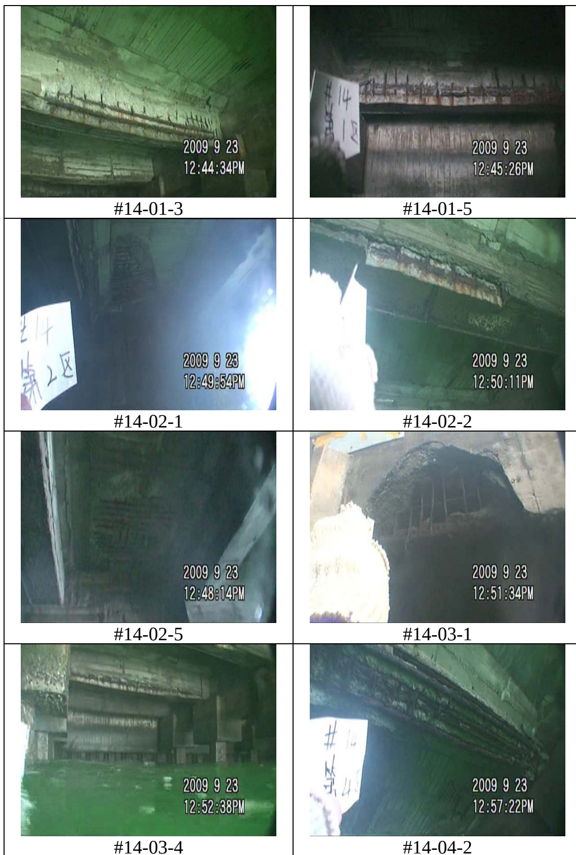
圖 29 臺中港 14 號碼頭調查照片-1
