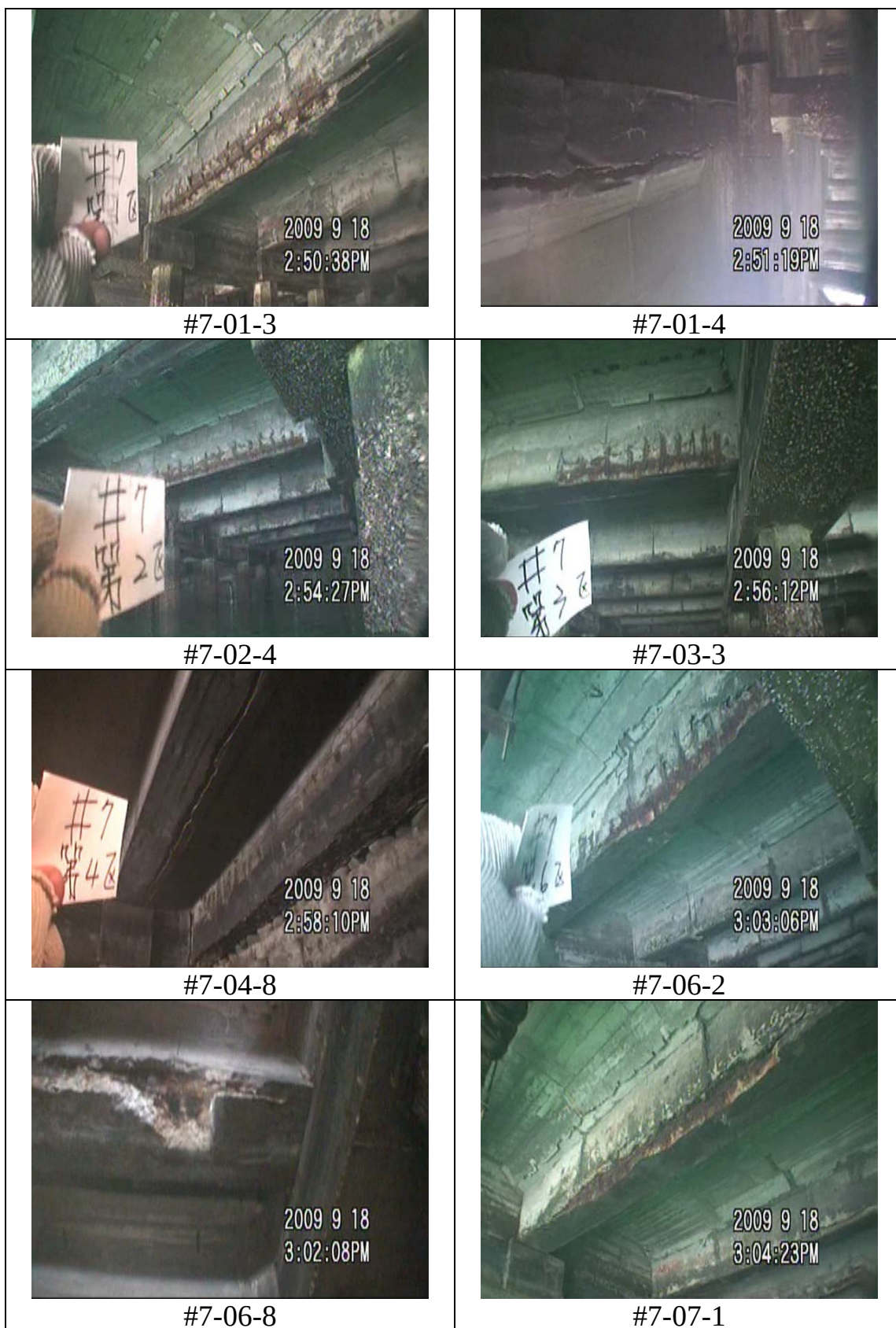
圖 10 臺中港 7 號碼頭調查照片-1
