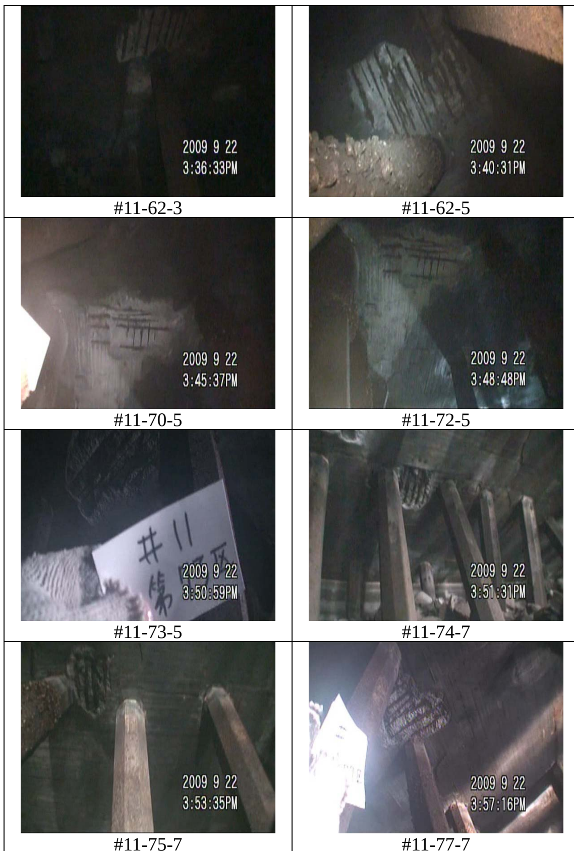
圖 21 臺中港 11 號碼頭調查照片
