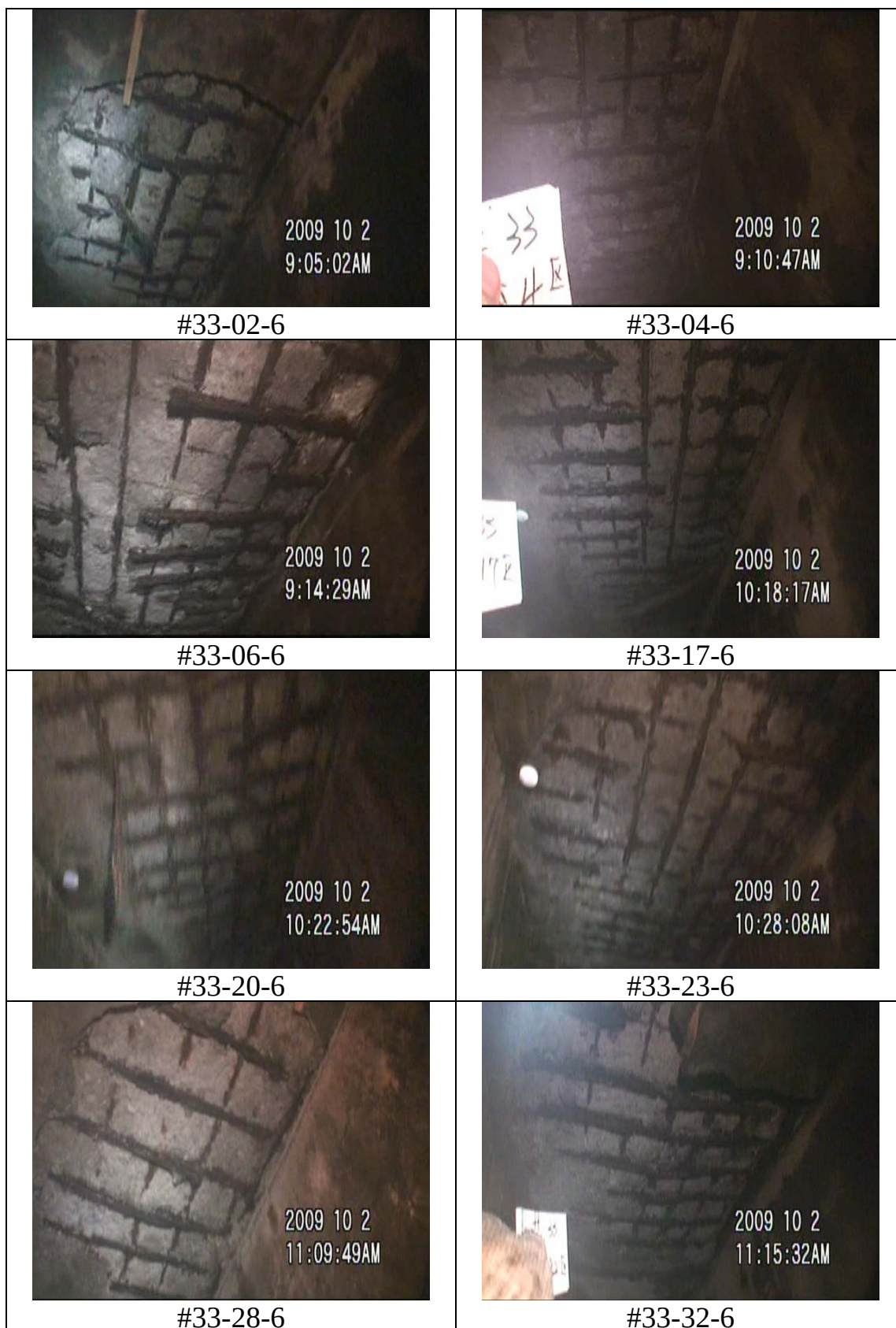
圖 50 臺中港 33 號碼頭調查照片-1
