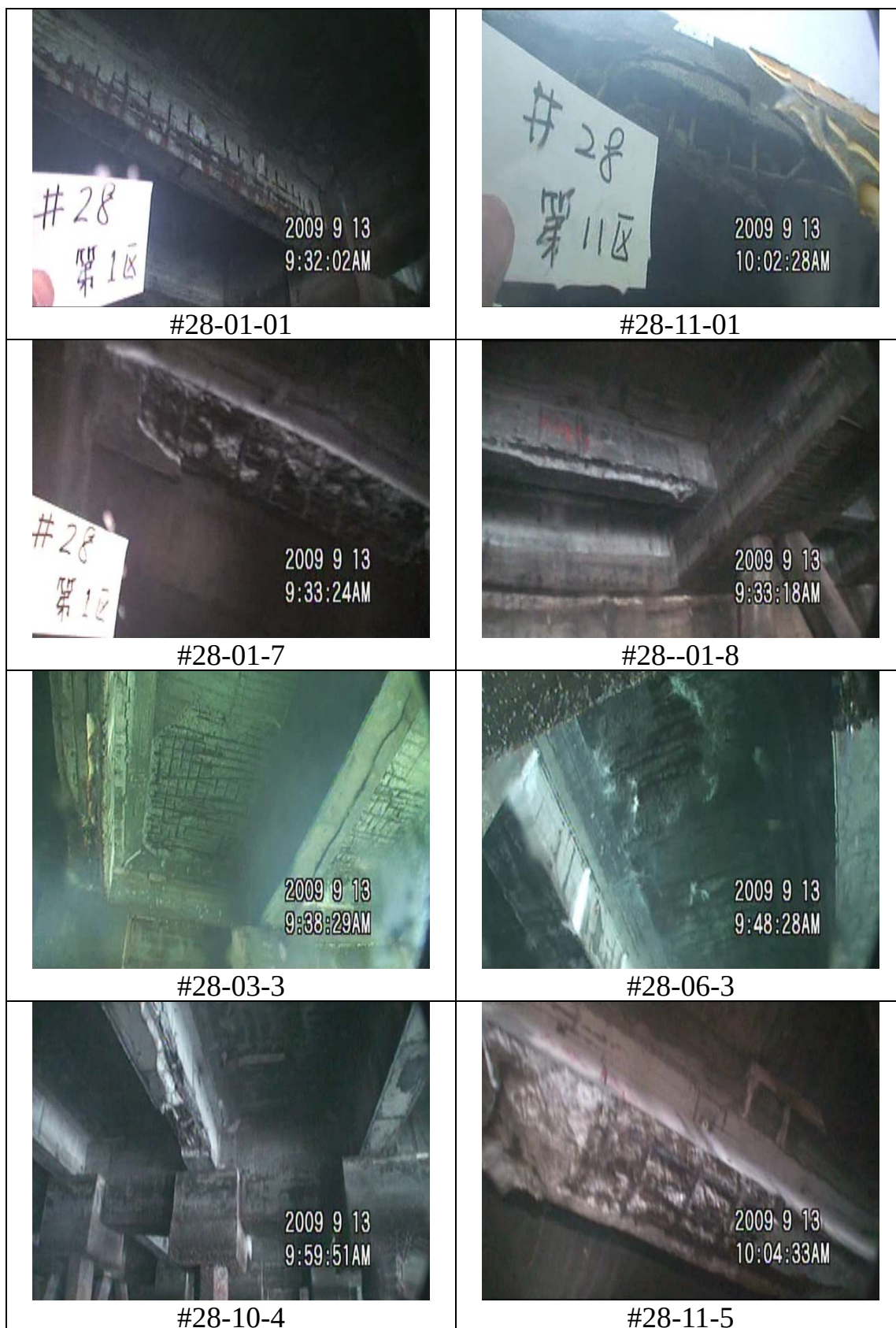
圖 40 臺中港 28 號碼頭調查照片-1
