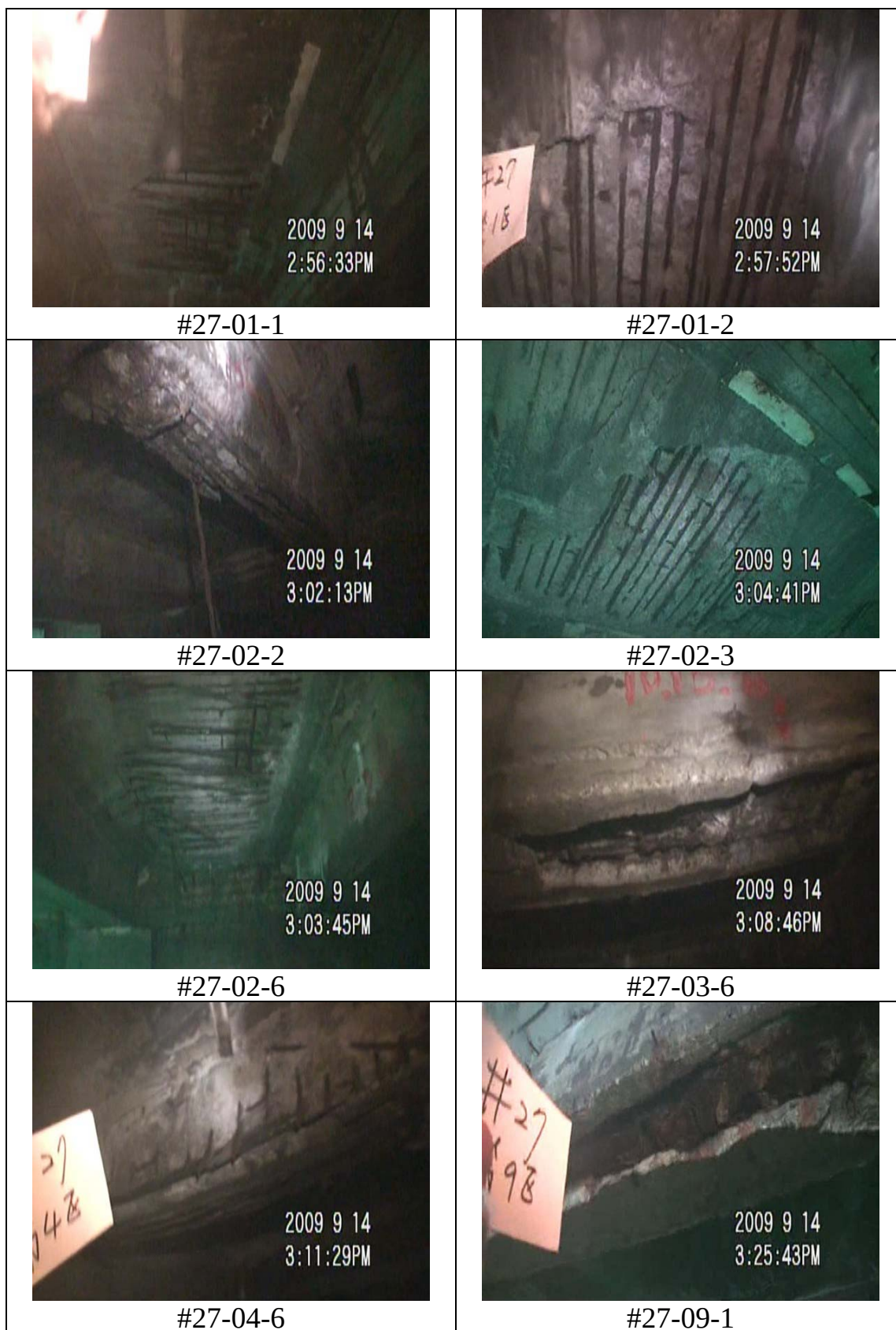
圖 37 臺中港 27 號碼頭調查照片-1
