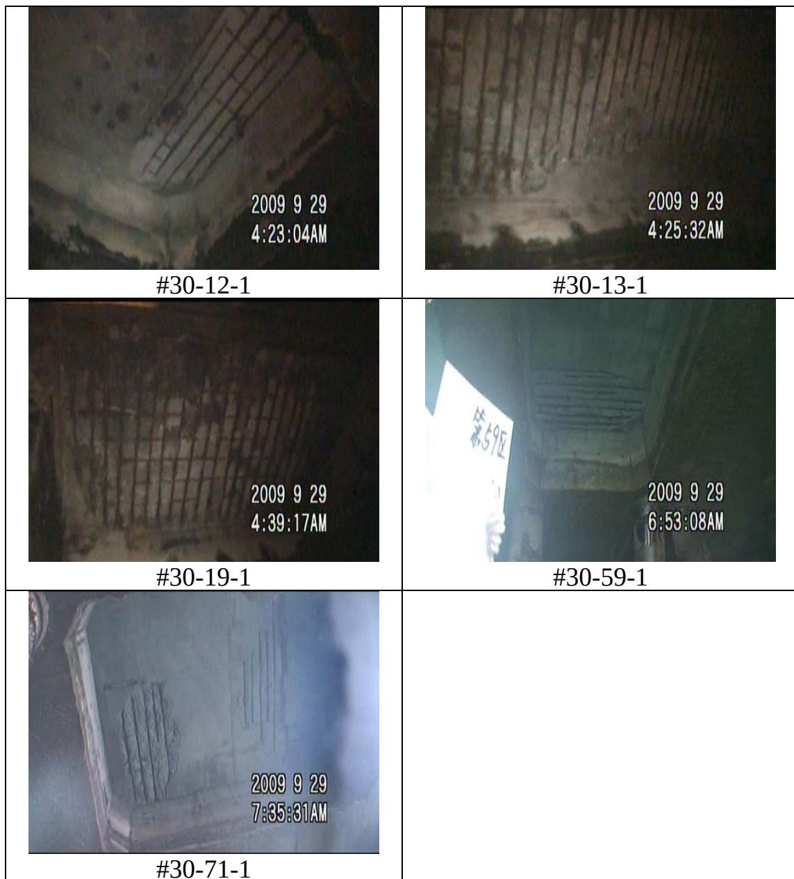
圖 46 臺中港 30 號碼頭調查照片
