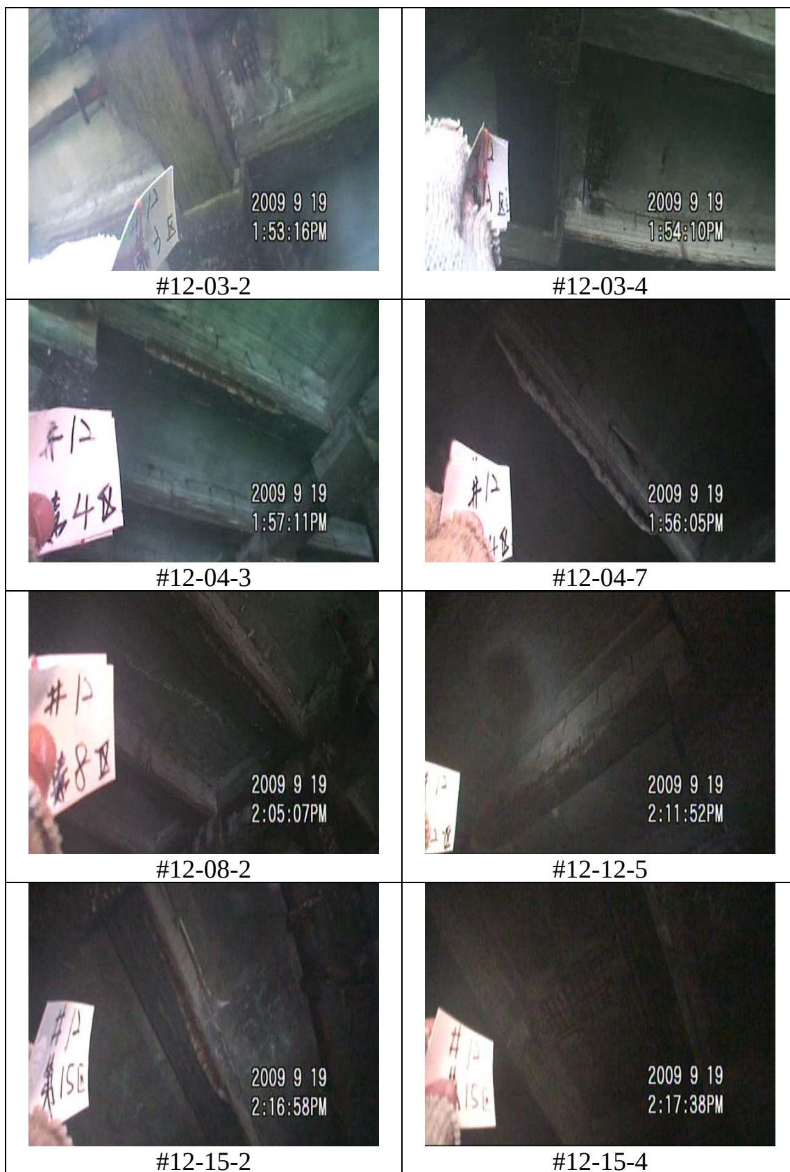
圖 24 臺中港 12 號碼頭調查照片-1
