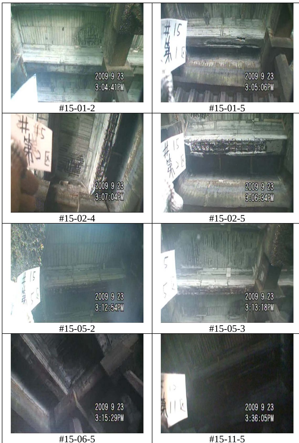
圖 31 臺中港 15 號碼頭調查照片-1
