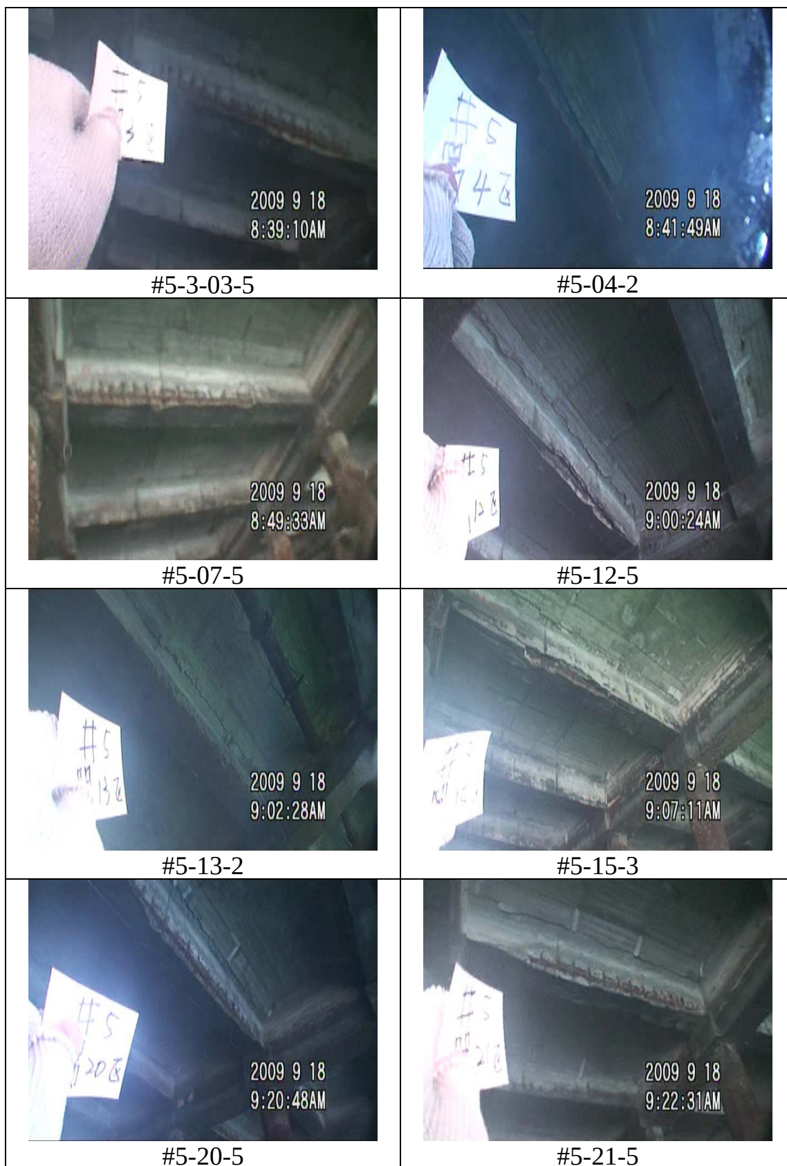
圖 6 臺中港 5 號碼頭調查照片-1
