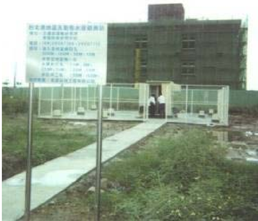
圖 4.6 臺北港區地震分層監測站設置完成外貌狀況
