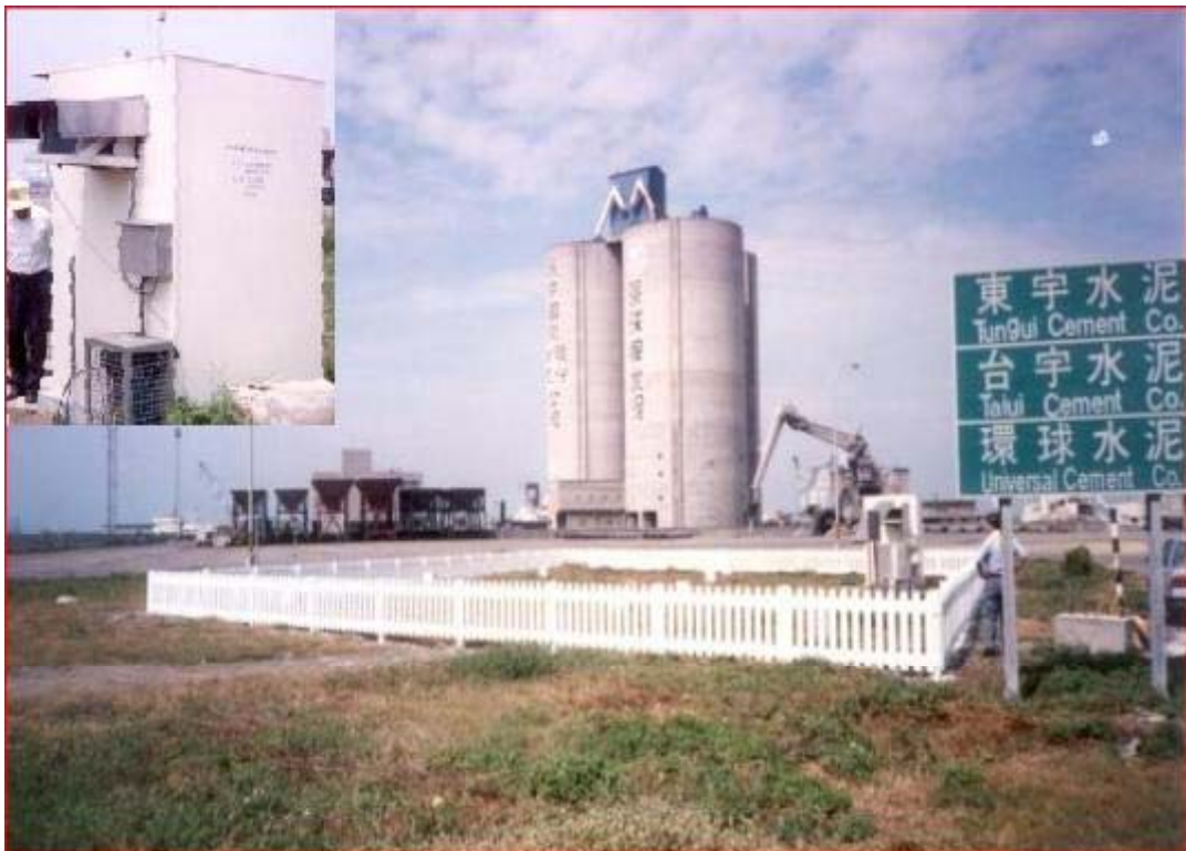
圖 5.7 臺中港區地震分層監測站設置完成外貌狀況
