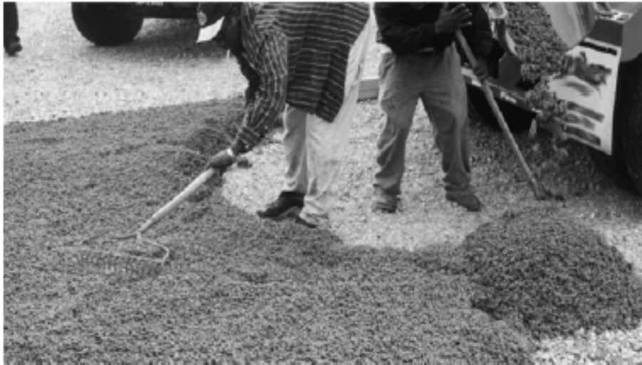
照片 3-3 藉由耙子攤平透水混凝土 [32]
