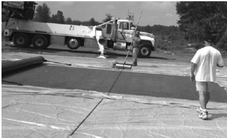
照片 3-11 壓密透水混凝土後應迅速使用塑膠紙覆蓋鋪面養護 [32]
