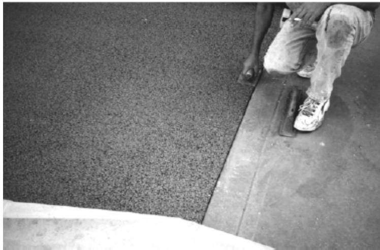
照片 3-8 鋤刀邊飾透水混凝土以改善角落外觀 [32]
