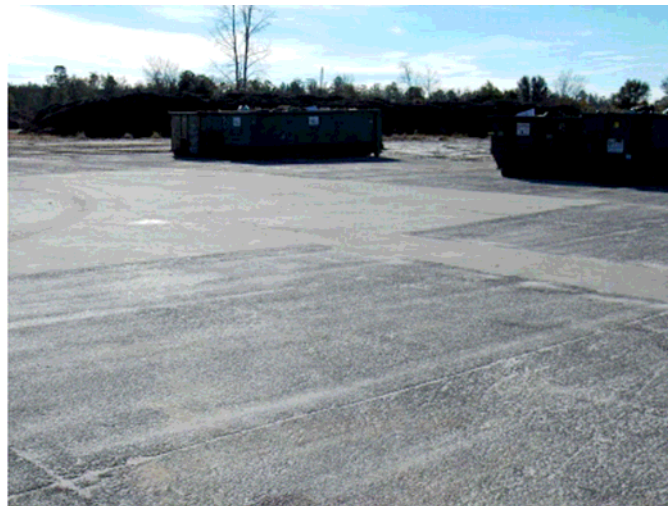
照片 2.12 喬治亞州 Effingham 透水混凝土郡掩埋場 [43]
