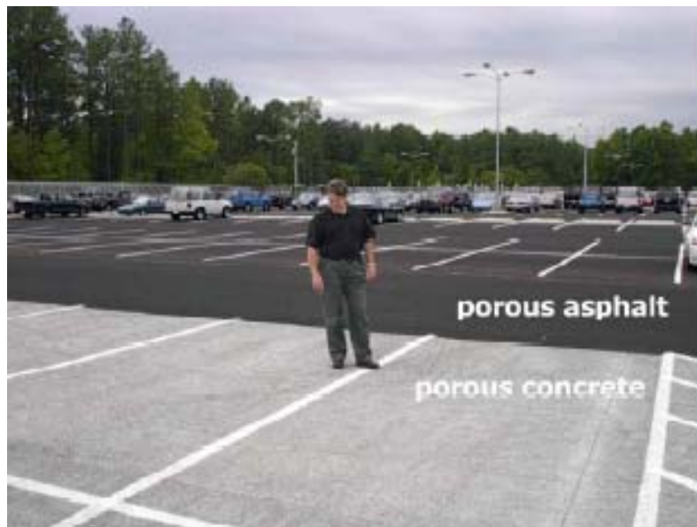
照片 2.14 北卡羅來那大學通勤停車場透水混凝土 [45]
