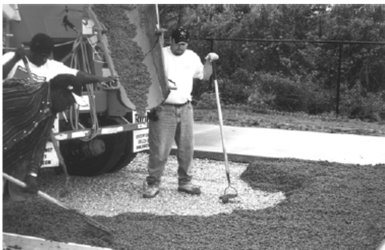
照片 3-1 藉由預拌車尾端卸料澆置透水混凝土 [32]
