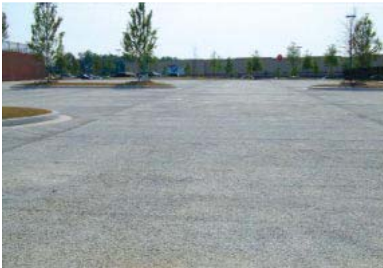
照片2.15(G) 喬治亞州Buford Large concrete停車場
