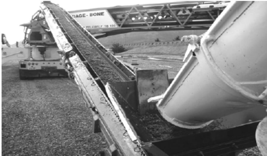
照片 3-2 藉由輸送帶澆置透水混凝土 [32]
