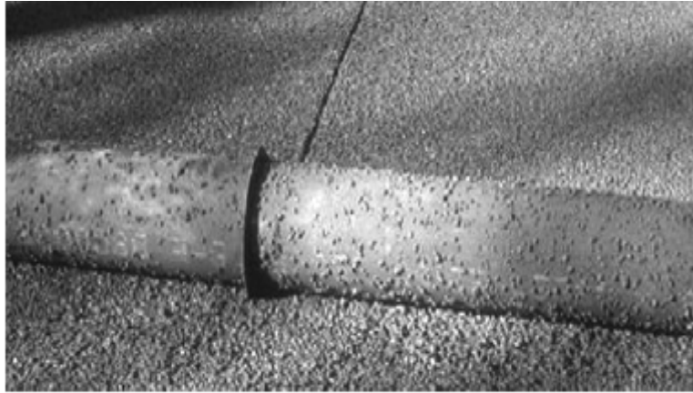
照片 3-10 滾筒附有刀鋒可以縱向切縫透水混凝土鋪面 [32]
