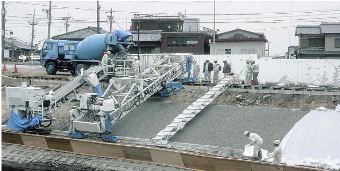
照片 2.5 透水混凝土護坡施工澆置情形 (GOMACO 公司) [12]
