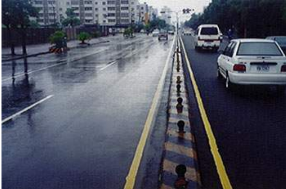
照片 2.4 臺南市中華西路之排水性瀝青路面 [5]
