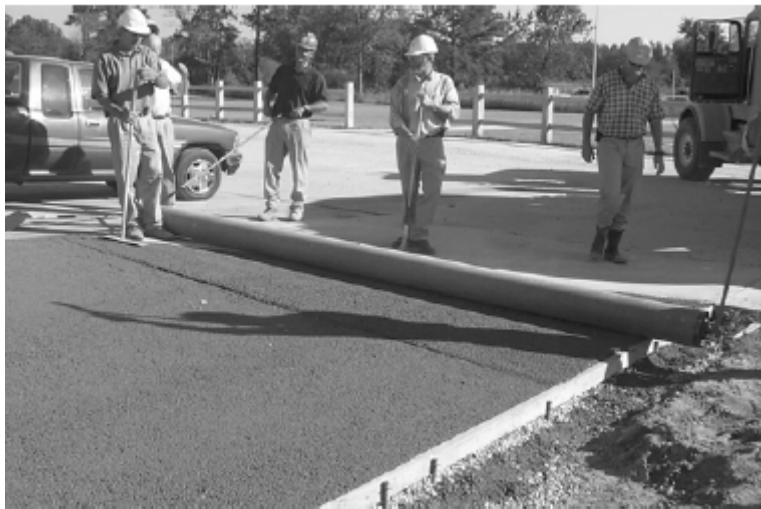
照片 3-5 藉由滾筒壓密透水混凝土 [32]
