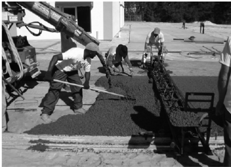
照片 3-4 藉由振動刮板進行搗實透水混凝土 [32]
