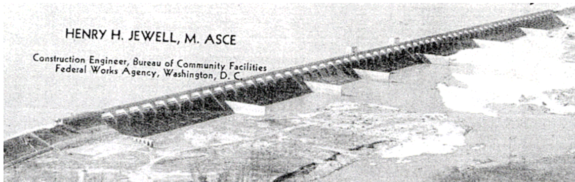
圖 2.19 美國南卡羅來那州 Santee 土石壩與堤防工程 [36]
