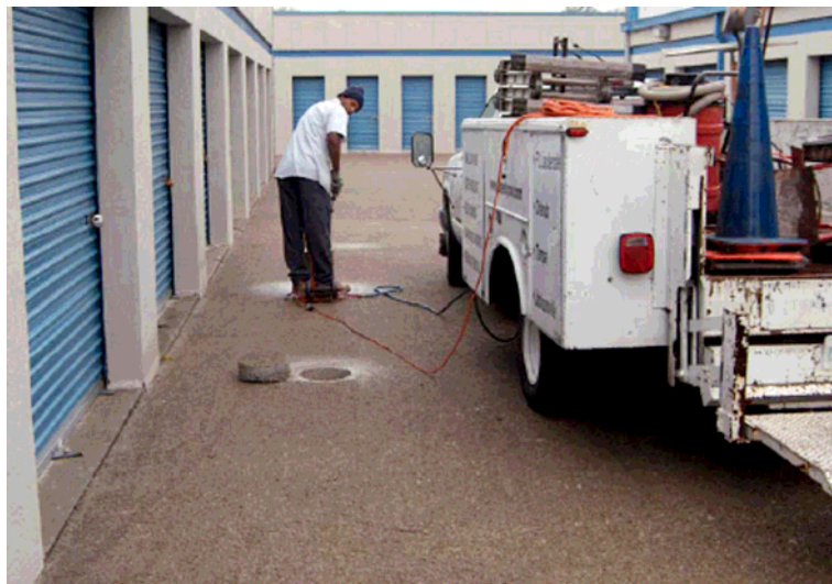
照片 2.9 Sun Ray Store-Away 倉儲設施透水混凝土鋪面 [43]
