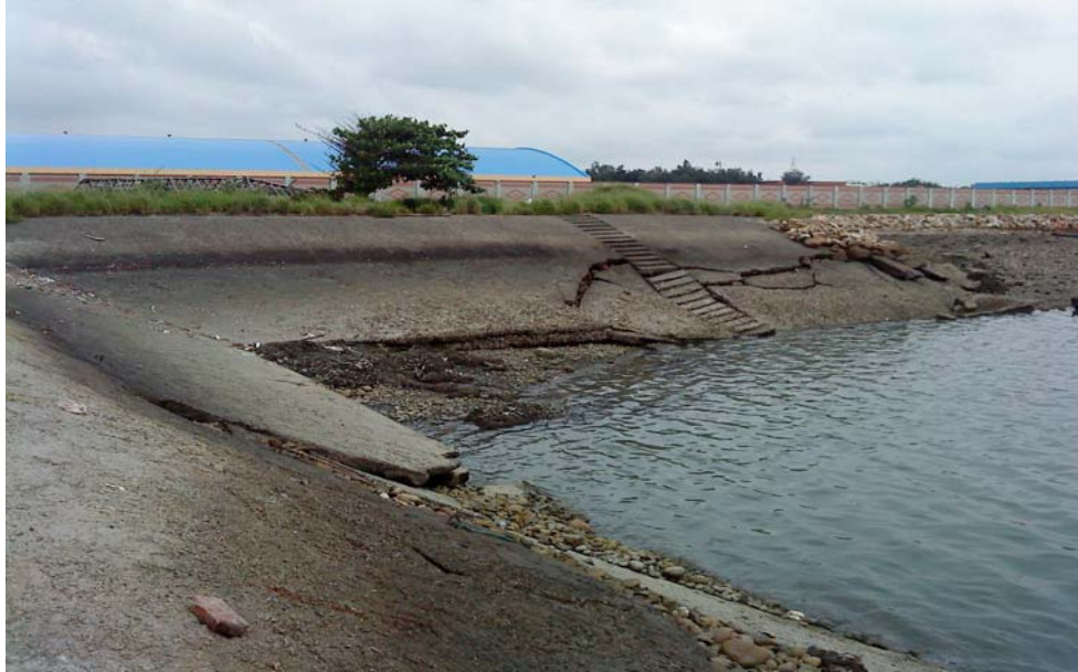
圖 3.5 臺中港中碼頭區第 15 與第 16 號碼頭中間之海堤現狀照片
