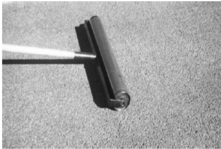
照片 3-6 藉由小滾筒壓密小區域透水混凝土 [32]
