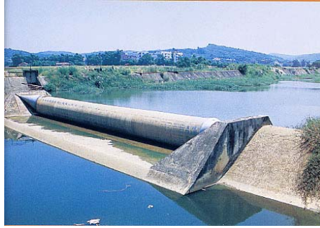
照片 2.4.1 河川工程所使用的橡皮壩
