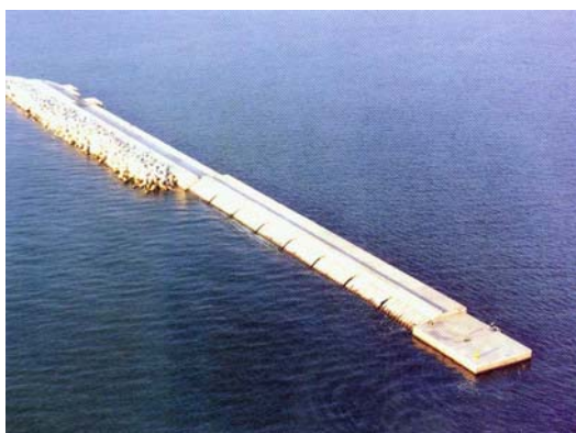
圖 4.1.9 凸型曲面防波堤(日本船川港)
