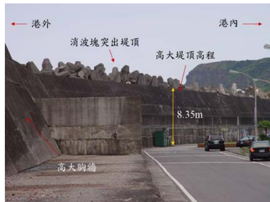
照片 4.1.1(b) 以高大海堤及消波塊構成之海岸保護工(左視)
