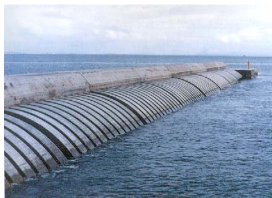
圖 4.1.9 凸型曲面防波堤(日本船川港)
