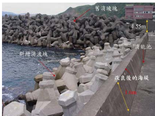
照片 4.1.1(c) 降低堤頂高程後之海洋大學工學院後方海堤
