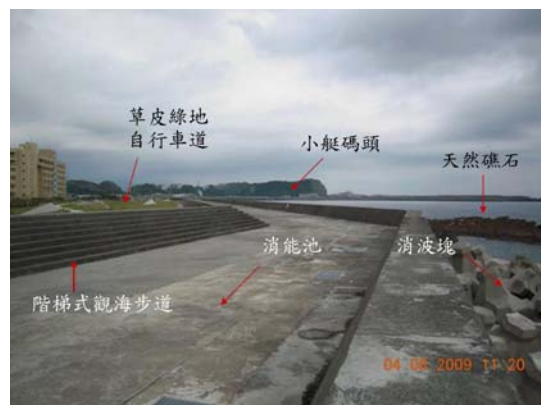
照片 4.1.1(c) 降低堤頂高程後之海洋大學工學院後方海堤
