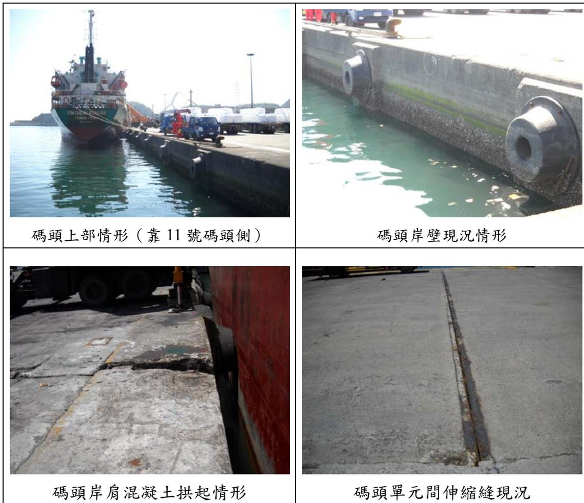
圖 3.26 蘇澳港 12 號碼頭上部結構檢測項目相關照片
