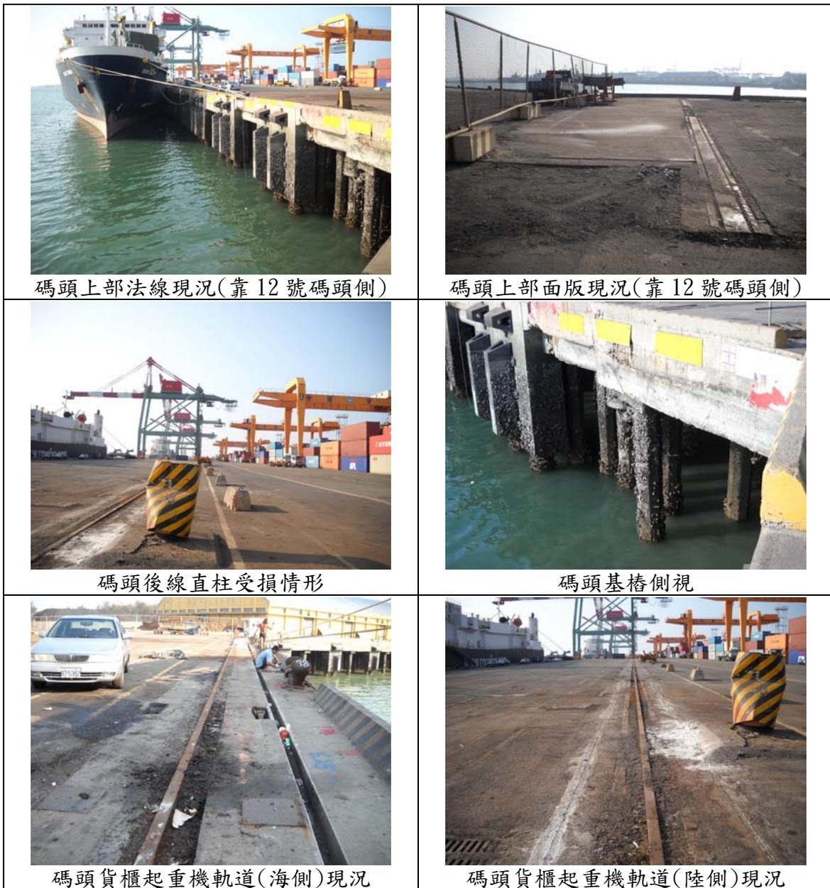
圖 3.21 臺中港 11 號碼頭上部結構檢測項目相關照片
