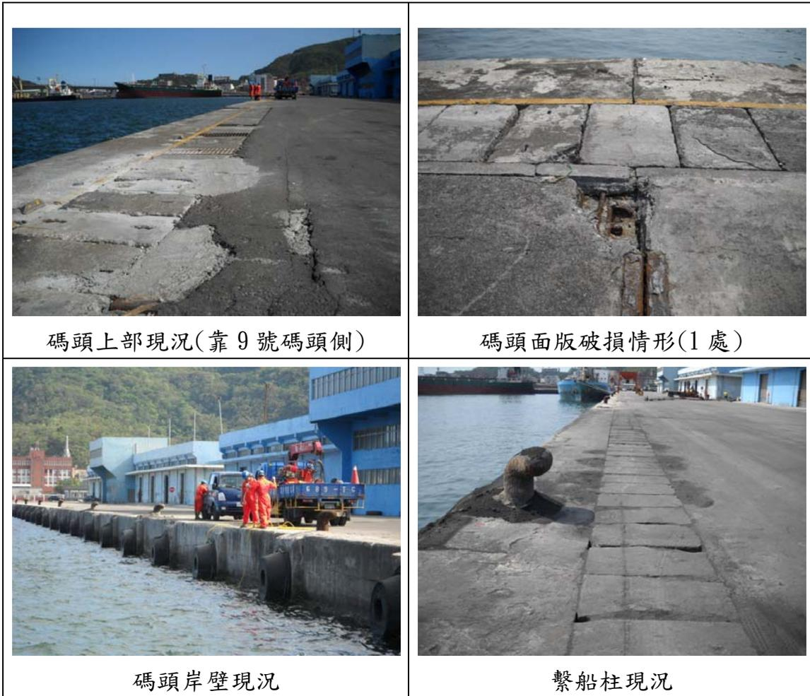
圖 3.24 蘇澳港 10 號碼頭上部結構檢測項目相關照片
