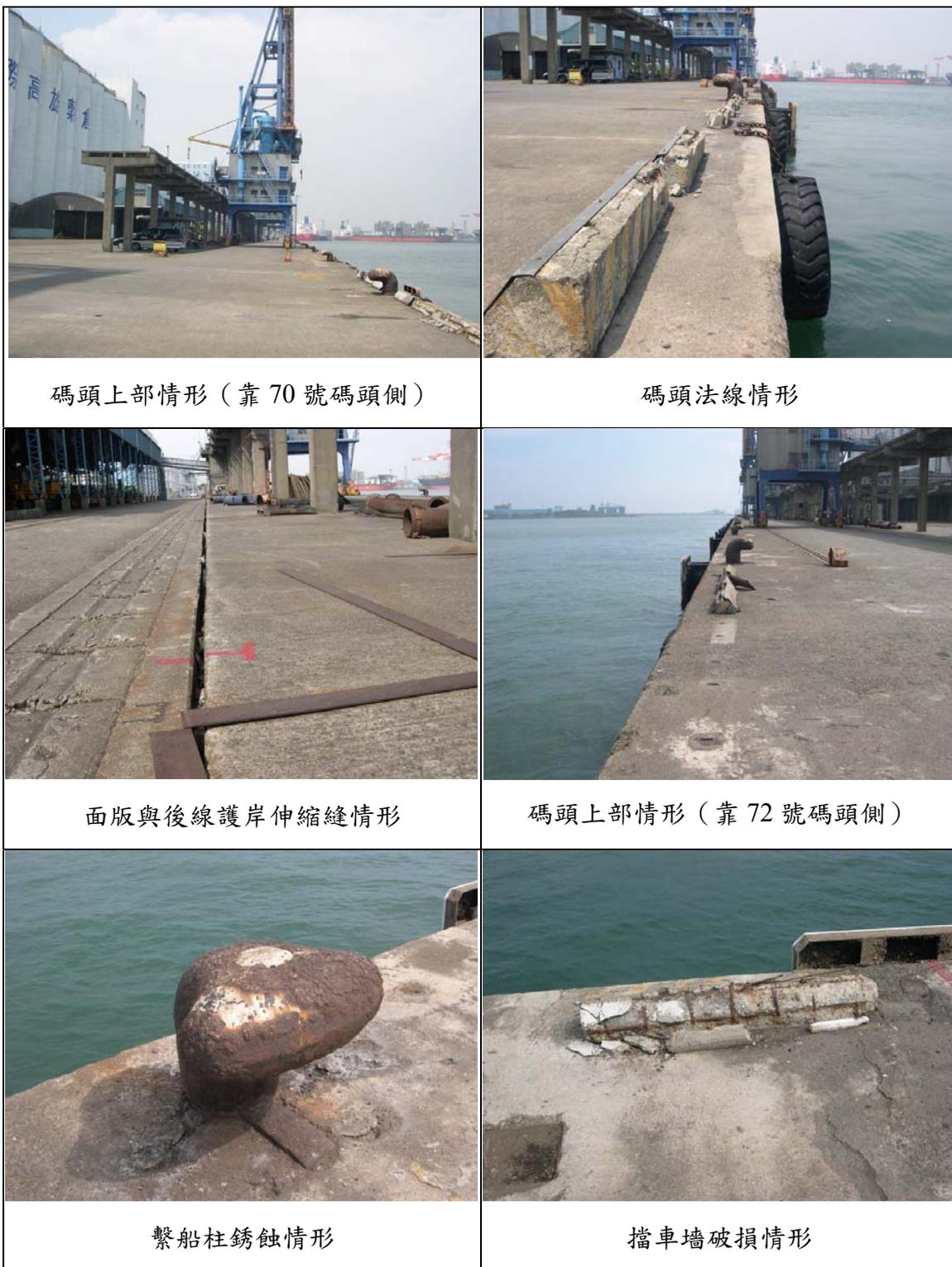
圖 3.29 高雄港 71 號碼頭上部結構檢測項目相關照片
