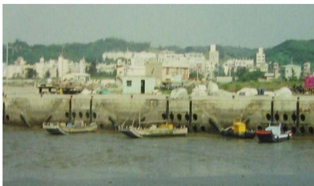
圖 4.3 具孔洞的重力式碼頭
