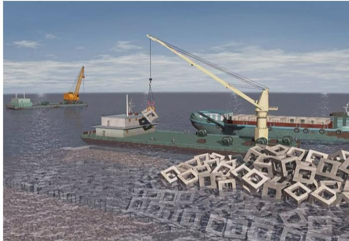
圖 4.15 空心混凝土塊堤（謝世悞提供）
