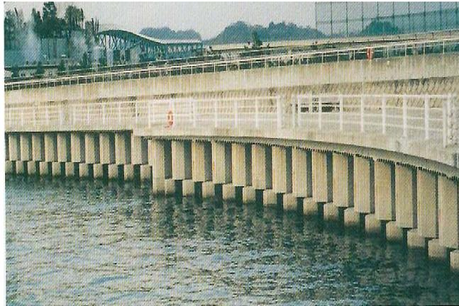
圖 4.12 直立開孔式混凝土護岸
