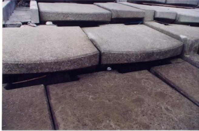
圖 4.13 階梯式護岸具有透水孔隙
