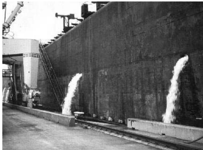
圖 4-22 船舶壓艙水排放管線
