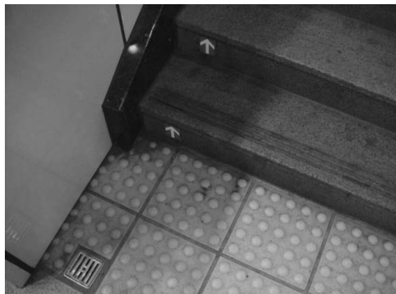
樓梯前警示設施位置設置錯誤(捷運板橋站)
