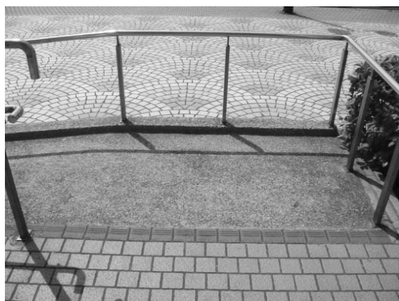
坡道與平臺未採用對比顏色(板橋車站)
