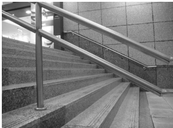
樓梯扶手高度不符規定(板橋車站)
