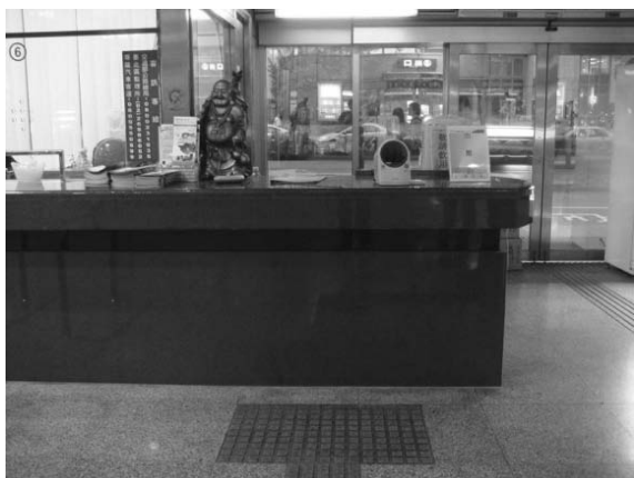
服務檯面與地板距離過高(板橋客運站)
