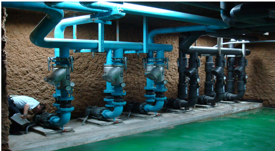
圖 3.9 板橋國道客運站冰水循環泵及冷卻水循環泵查訪
