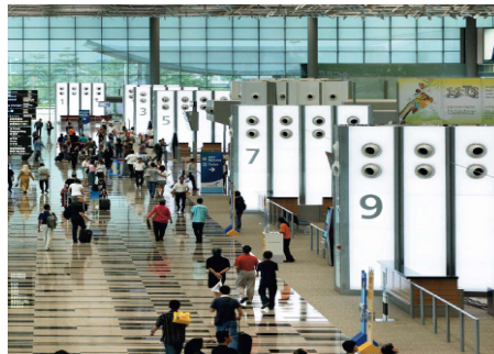
圖 5.2 樟宜機場-噴射式擴散器(jet diffuser)空調
