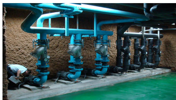
板橋客運站冰水循環泵及冷卻水循環泵
