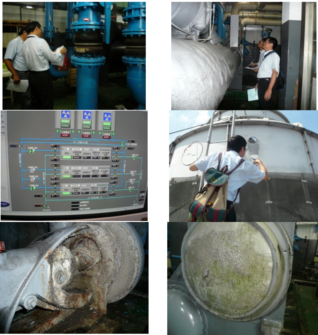
圖 3.5 臺北國際航空站現場查訪狀況及設備損壞情形
