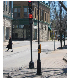
圖 5-38 美國符合輪椅、孩童使用高度信號機 [37]
