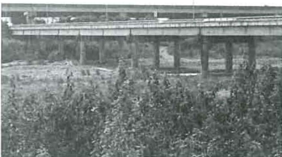
多跨簡支橋—構架式橋墩
