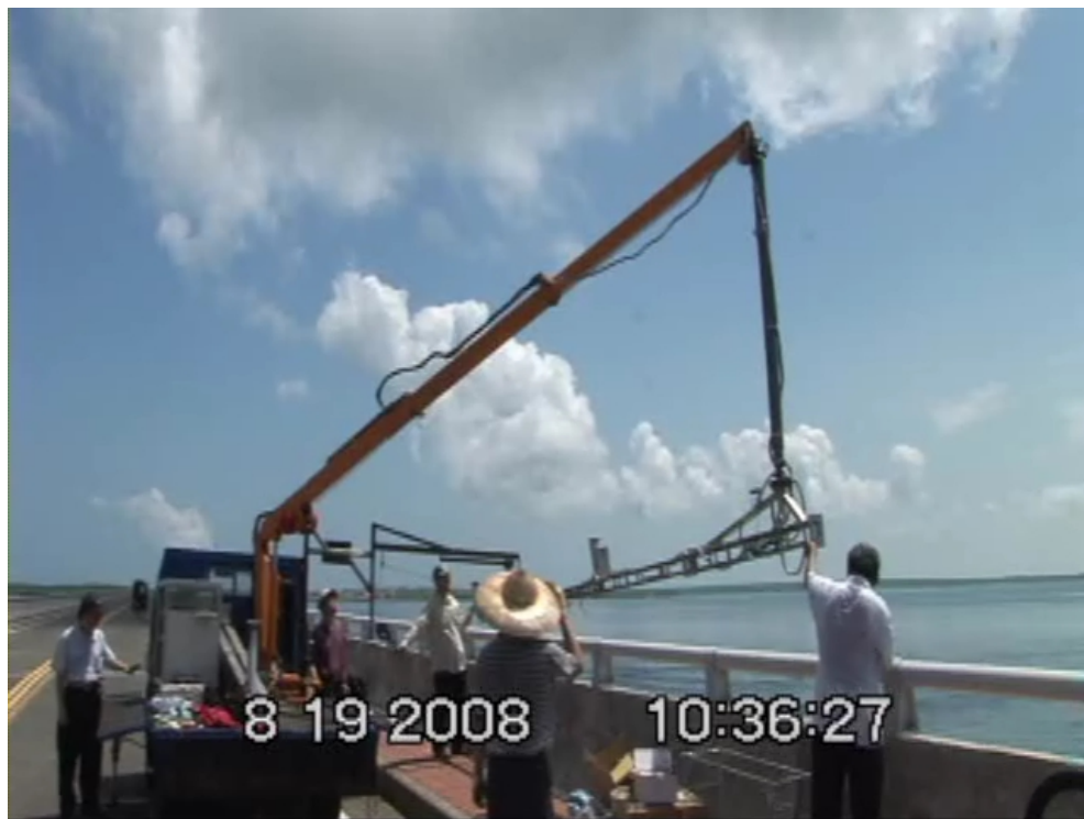
圖 4.25 操控第 3 臂及所承載之攝影機移出橋護欄外
