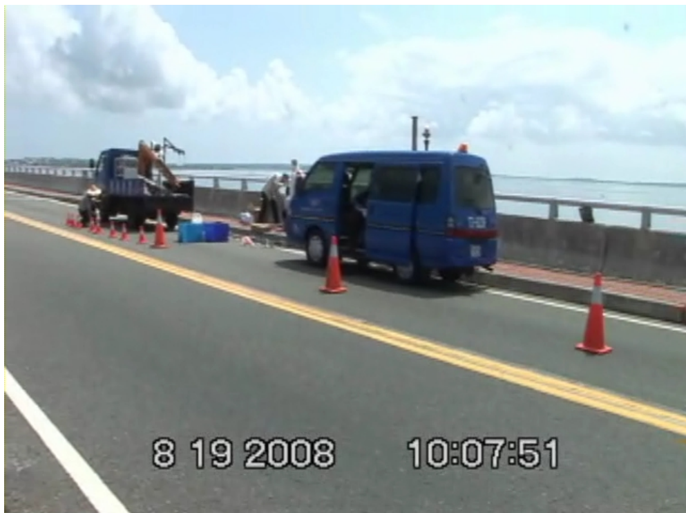
圖 4.22 執行檢測作業時之車道安全措施
