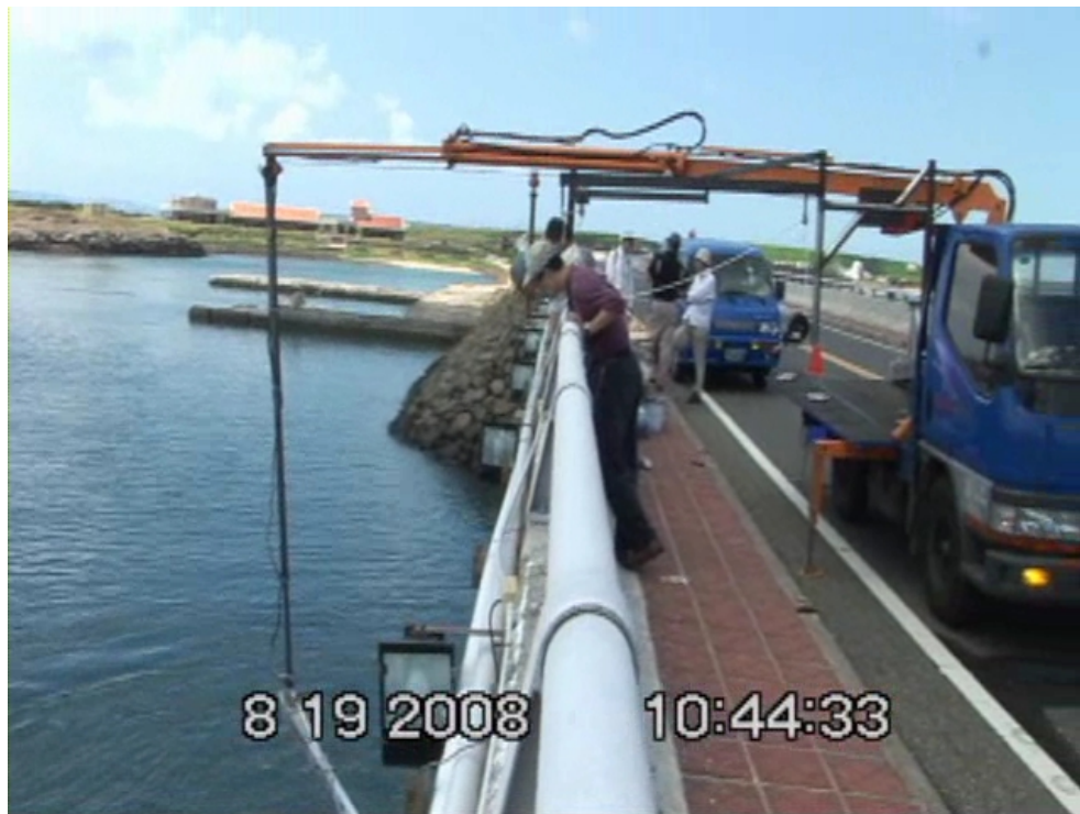
圖 4.27 迴轉機械手臂使攝影機深入橋面下進行拍攝工作
