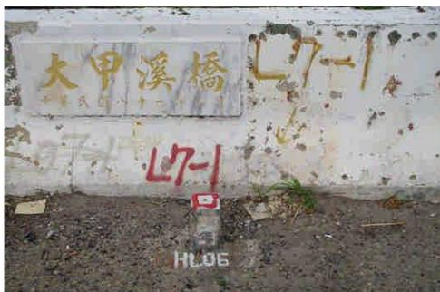
圖 4.3 水準測量控制點
