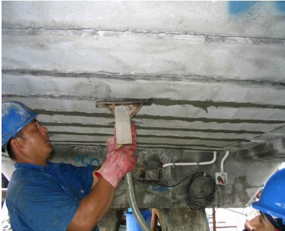
圖 6.7 溝槽以混凝土填實
