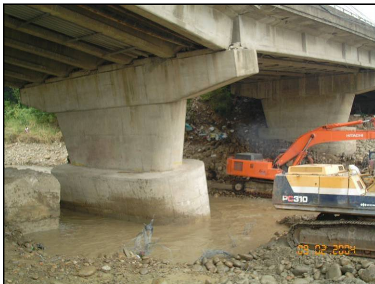
圖 3.14 沖刷造成之淺基礎損害
