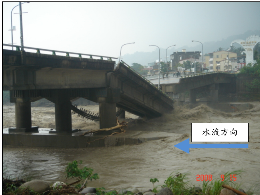
圖 5.13 台 20 線 58K+100 甲仙大橋橋墩傾斜破壞
