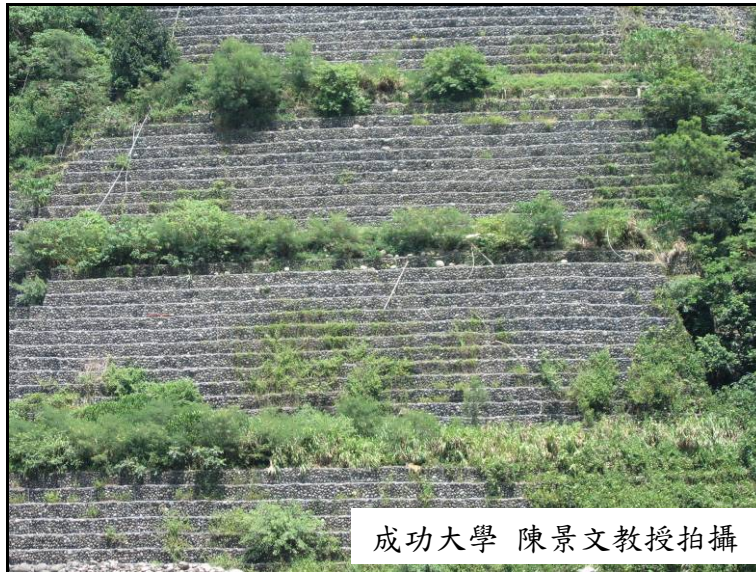
圖 6.46 以石籠作為路基穩定之工法
