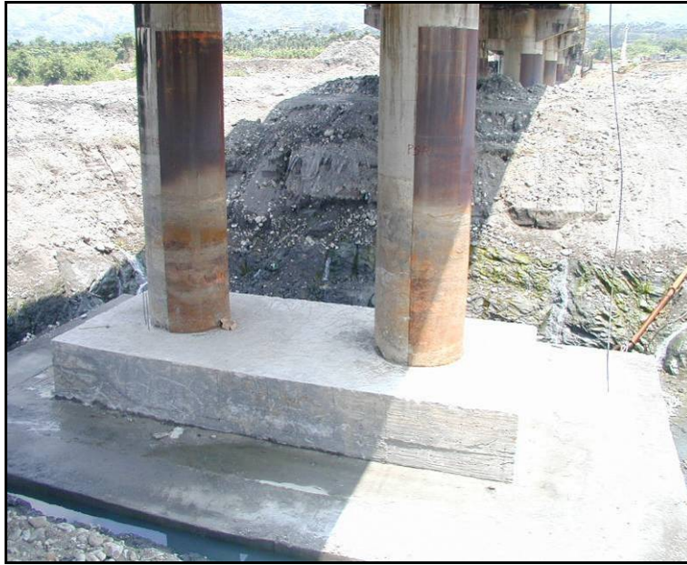
圖 3.43 加大墩座結構工法
