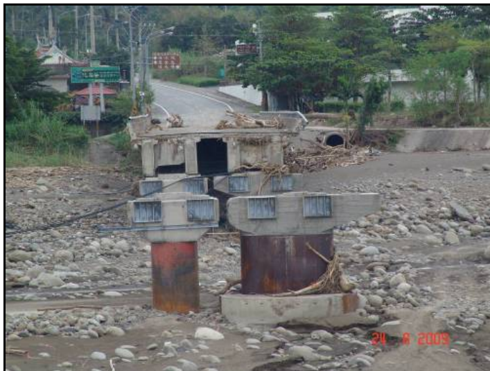
圖 6.27 因過大洪峰流量損害橋梁(李維峰，2009)
