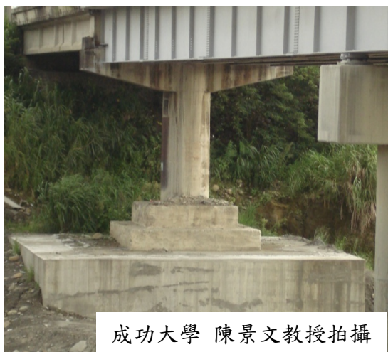
圖 3.47 PC 包墩補強(五虎寮橋)
