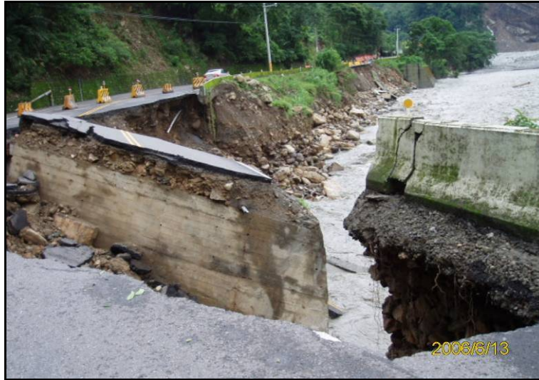
圖 6.9 下邊坡因洪水衝擊造成沖刷破壞
