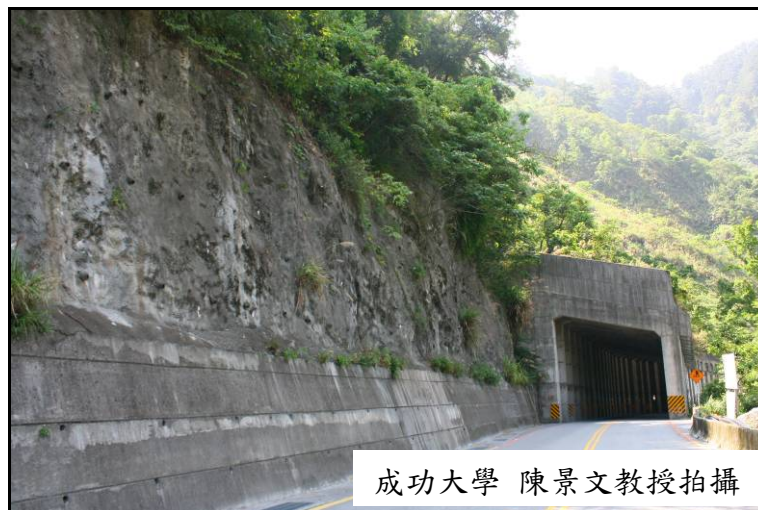
圖 6.19 台 8 線之明隧道
