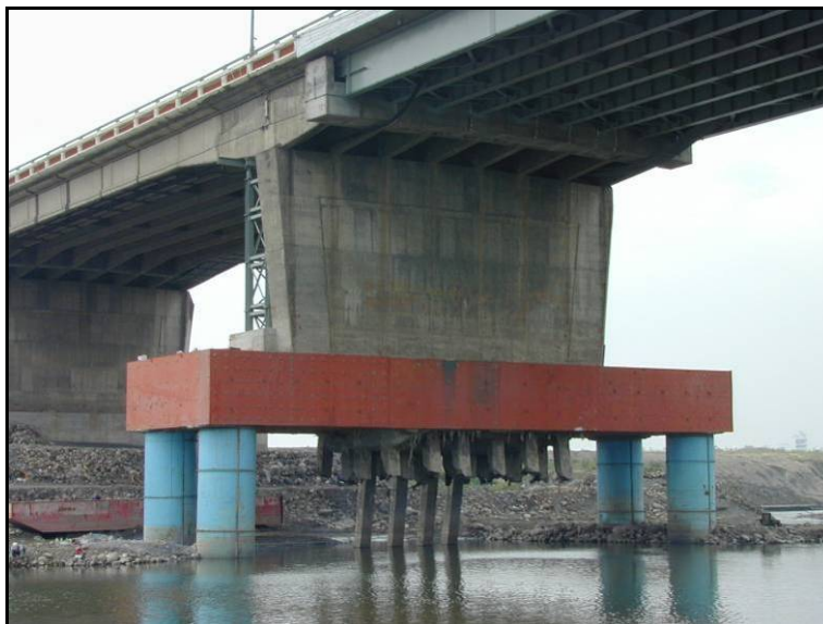
圖 3.22 深基礎橋梁受沖刷破壞與修復補強實例
