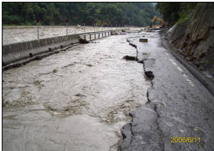
圖 6.12 漫地流集中渲洩於紐澤西護欄缺口所造成之下邊坡破壞
