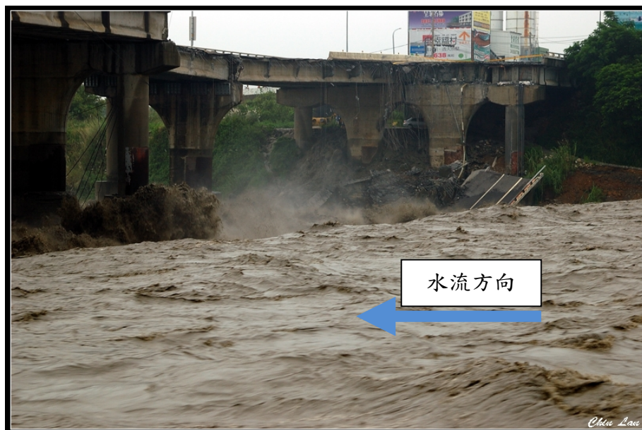
圖 5.14 台 13 線 065 K+629 后豐大橋橋墩傾斜破壞
