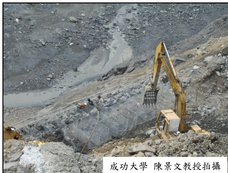
圖 6.17 台 27 線 6K 左右之道路路基搶修
