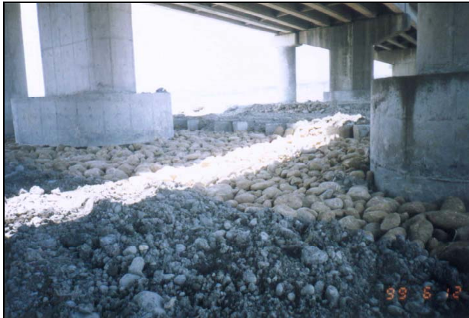
圖 3.31 拋石橋址保護工法(李維峰，2008)
