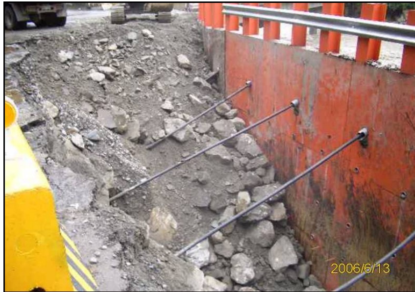
圖 6.11 擋土結構之回填材料就地取材後施工
