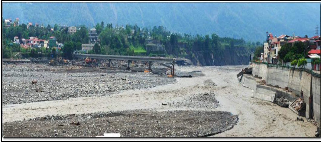
圖 6.28 因橋址位於水路攻擊處損害橋梁(李維峰，2009)
