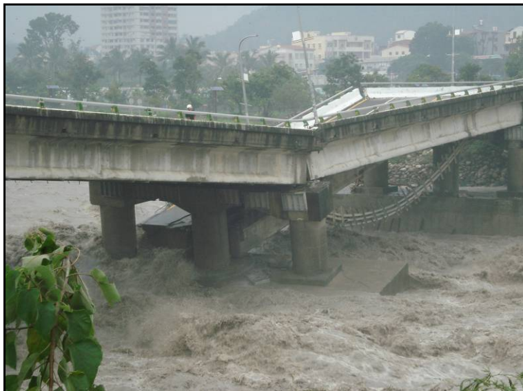
圖 3.18 沖刷產生基礎傾覆損壞情形
