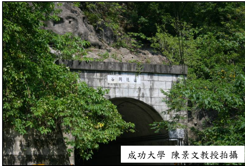
圖 6.18 台 8 線 36KM 處之谷關隧道
