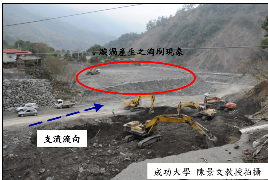
圖 5.11 主、支流匯流處產生漩渦侵蝕周遭邊坡
