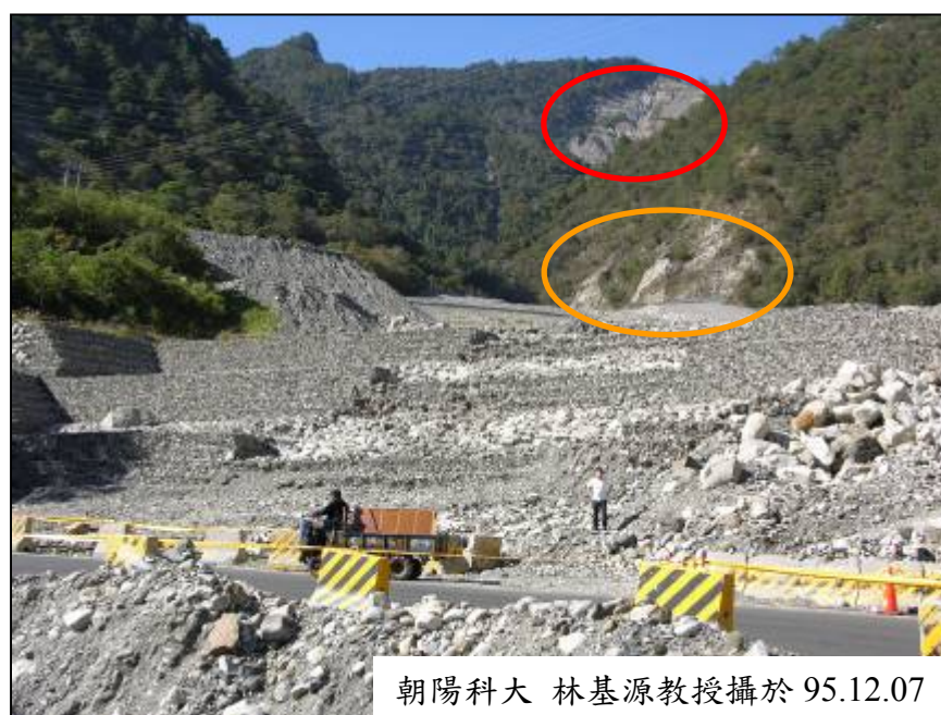
圖 4.78 95.12.07 現地拍攝照片(上邊坡)
