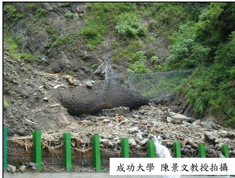
圖 6.16 逆向陡坡處之漁網狀防落石網
