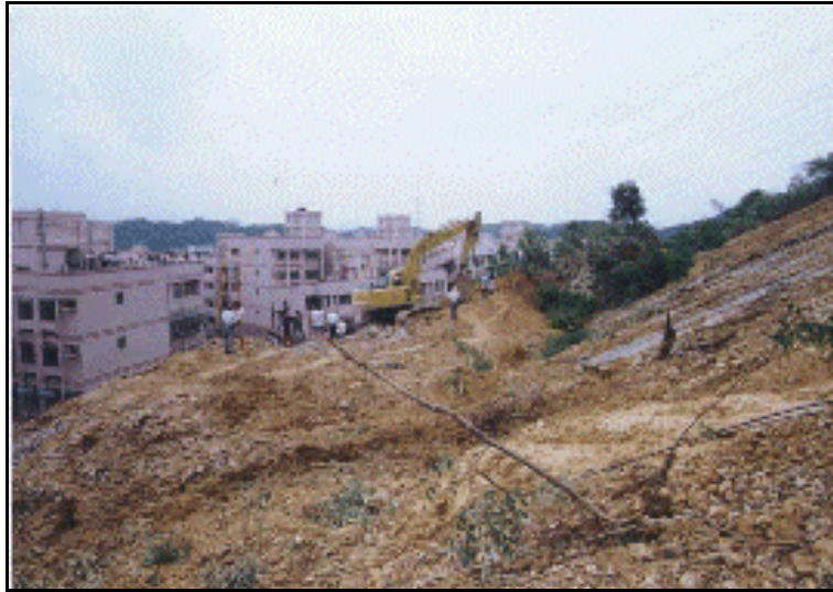
圖 6.5 順向坡滑動破壞案例
