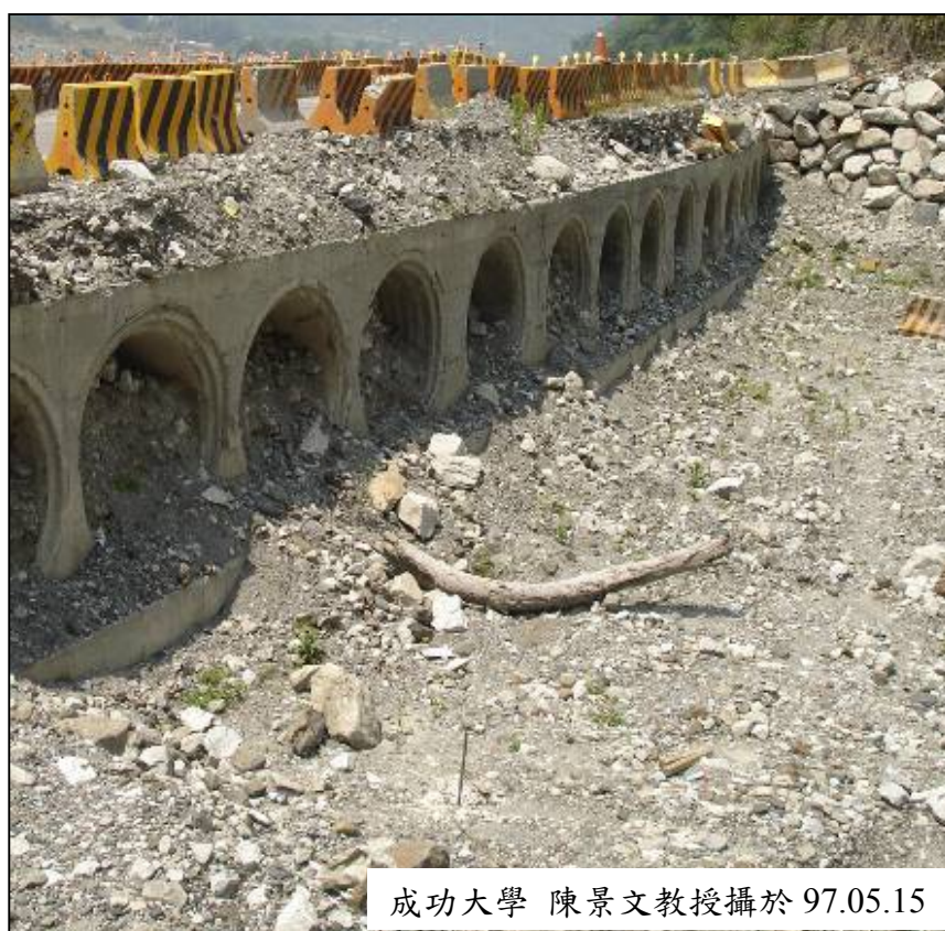
圖 4.82 97.5.15 現地拍攝照片(管涵後方)
