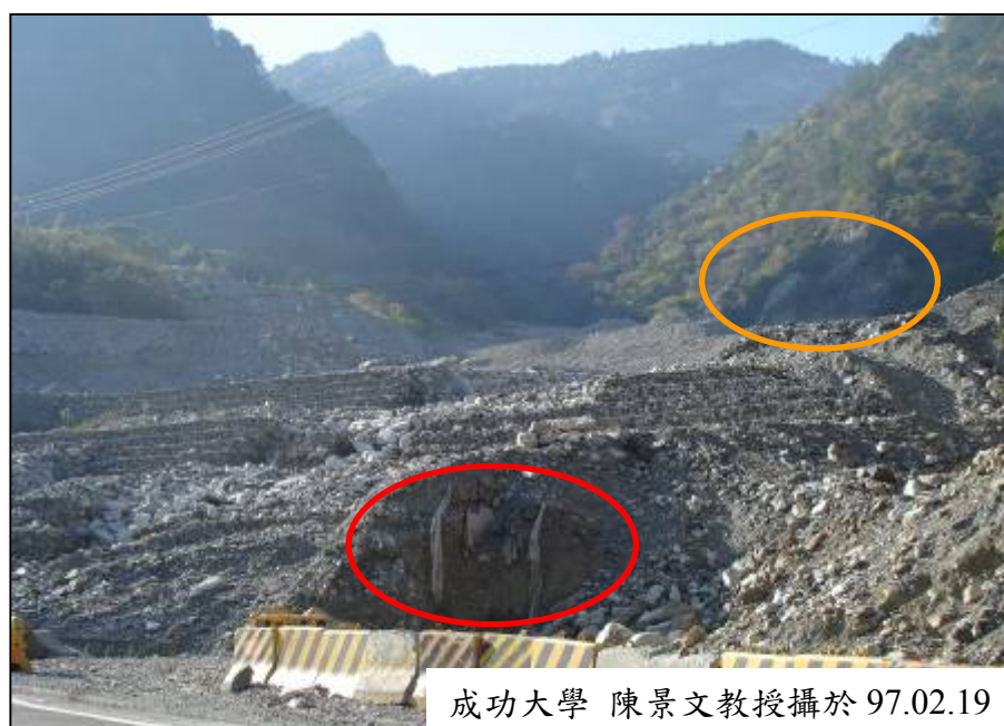
圖 4.79 97.02.19 現地拍攝照片(上邊坡)
