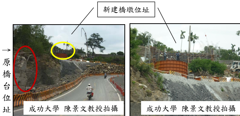
圖 6.35 新建之新發大橋，橋台往河道兩岸延伸(右岸)
