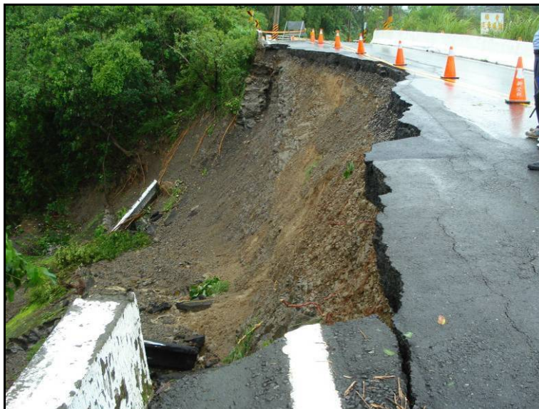
圖 6.8 坡趾沖刷造成下邊坡路基流失
