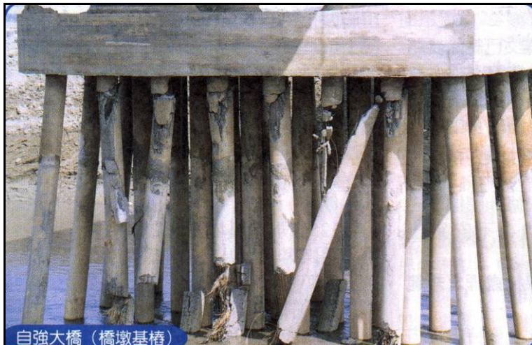
圖 3.28 橋梁基礎土壤流失損壞實例
