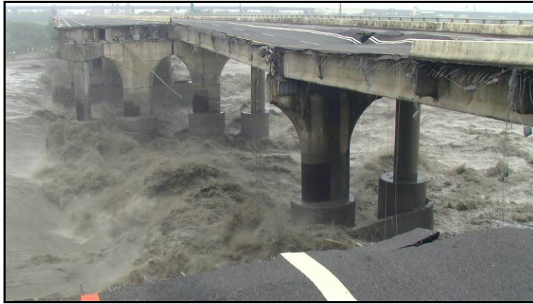
圖 3.27 河道異狀造成水躍淘刷與束縮淘刷實例(李維峰，2008)
