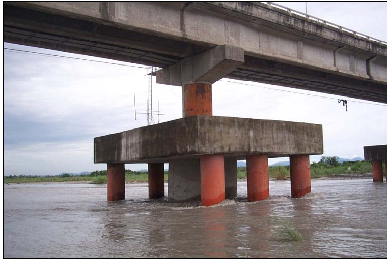
圖 3.45 橋梁基礎保護之托底工法
