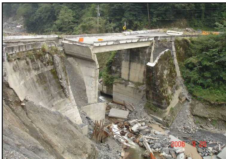
圖 3.25 橋台基腳遭淘空之破壞模式
