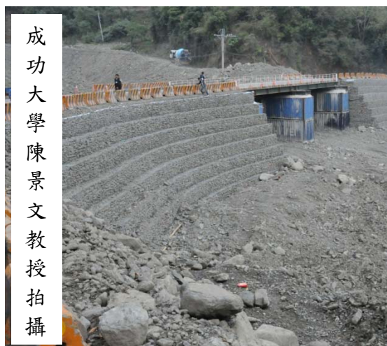
圖 3.48 石籠/蛇籠工法(台 20 線)
