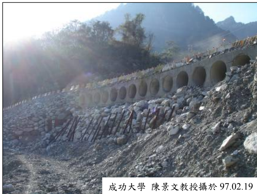
圖 4.81 97.02.19 現地拍攝照片(下邊坡)
