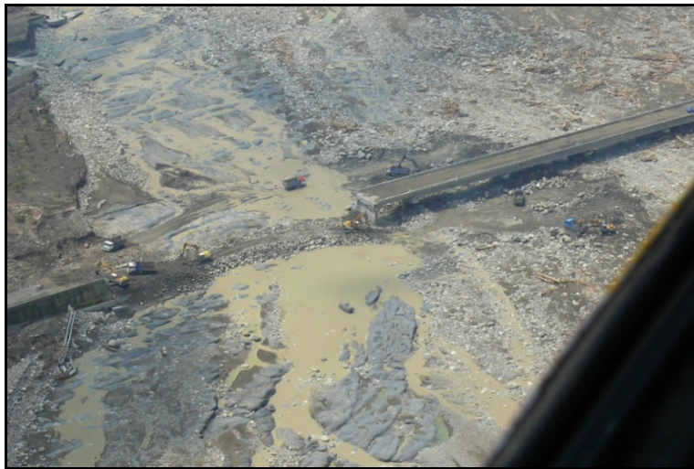
圖 6.29 因洪氾破壞橋梁相關構造物而損害的橋梁(李維峰，2009)
