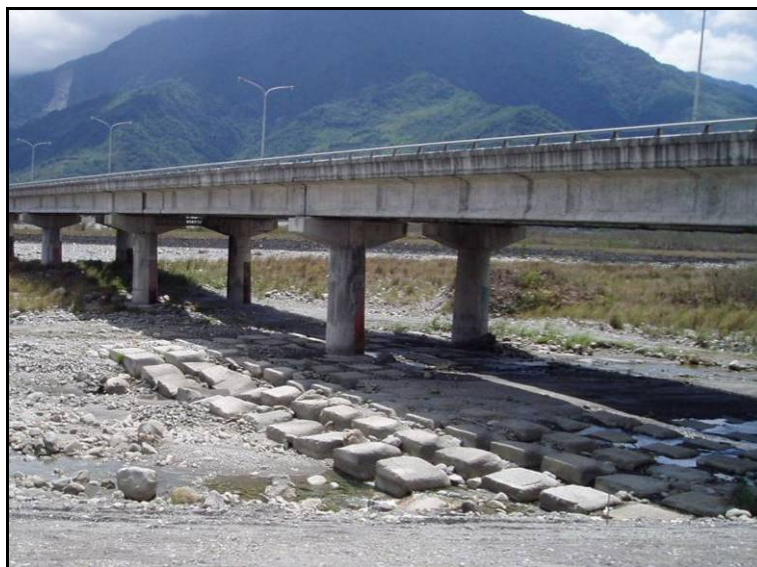
圖 3.30 混凝土塊橋址保護工法(李維峰，2008)
