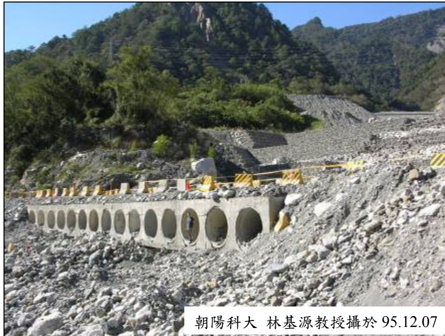
圖 4.80 95.12.07 現地拍攝照片(下邊坡)
