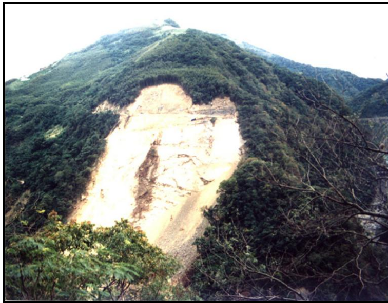
圖 6.1 淺層土壤滑動破壞案例
