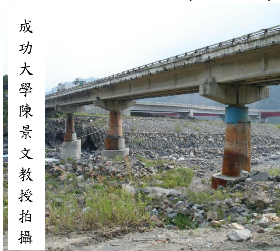
圖 3.49 鋼版圍繞工法(台 21 線)
