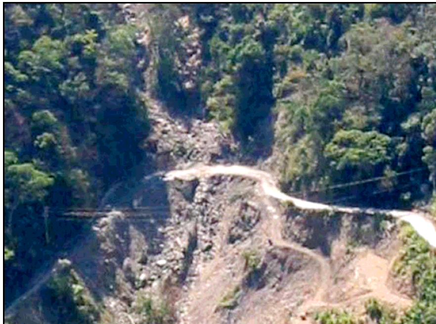
圖 6.10 道路下邊坡因向源侵蝕迫使道路向內改線， 形成回頭彎(吳淵洵等，2006)
