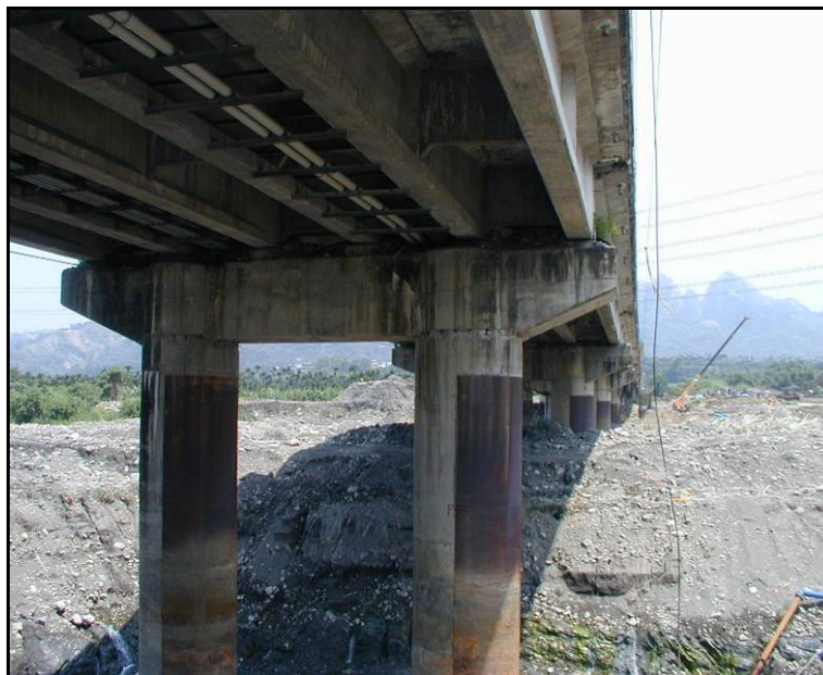
圖 3.41 橋墩鋼版補強工法(李維峰，2008)
