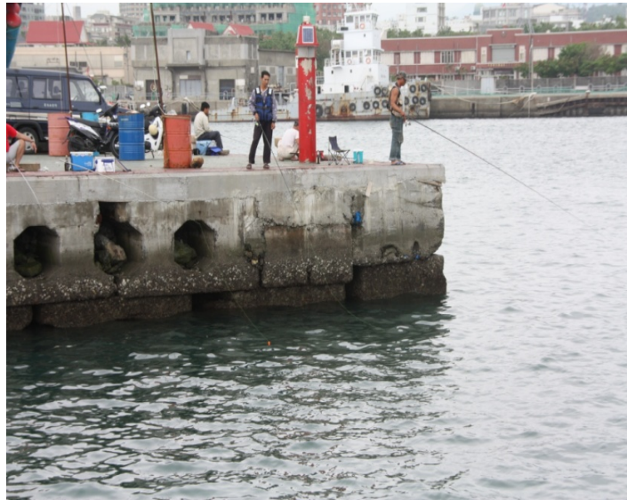
圖 5.38 孔洞型岸壁設計(花蓮港)
