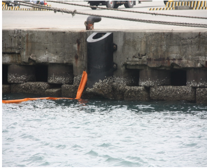
圖 5.41 置放鋼製受衝板的碰船墊
