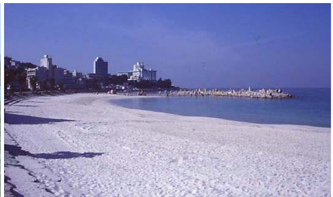
排水道和突堤與海岸線融合一體化
