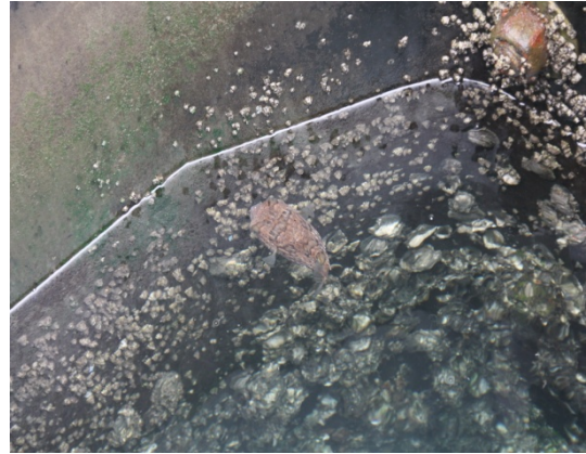
圖 5.25 水質乾淨之防舷材內部(二)
