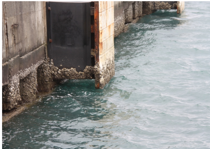
圖 5.42 置放鋼製受衝板的碰船墊
