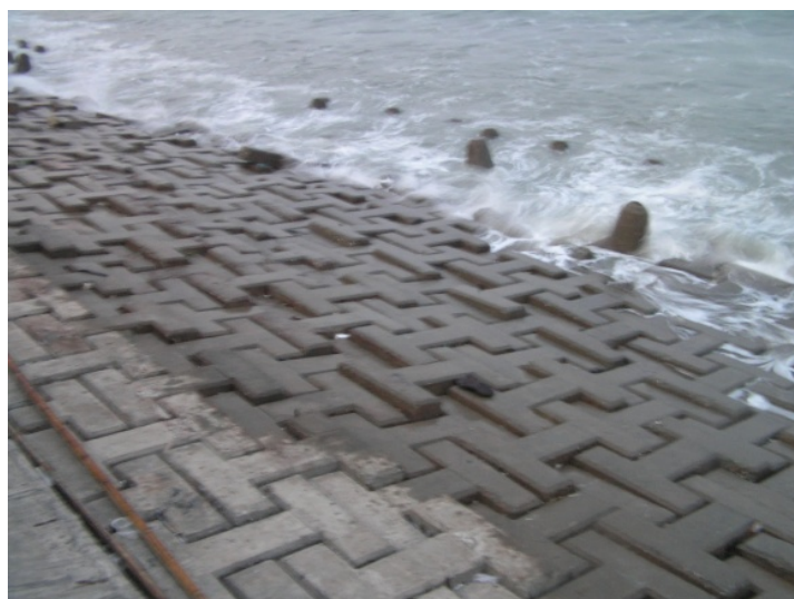
圖 5.51 旗津 海岸護坡
