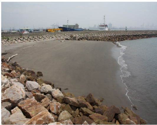
圖 5.12 消波塊與石塊所組成之保護工
