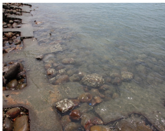
圖 5.5 台中港緩坡護岸(二)
