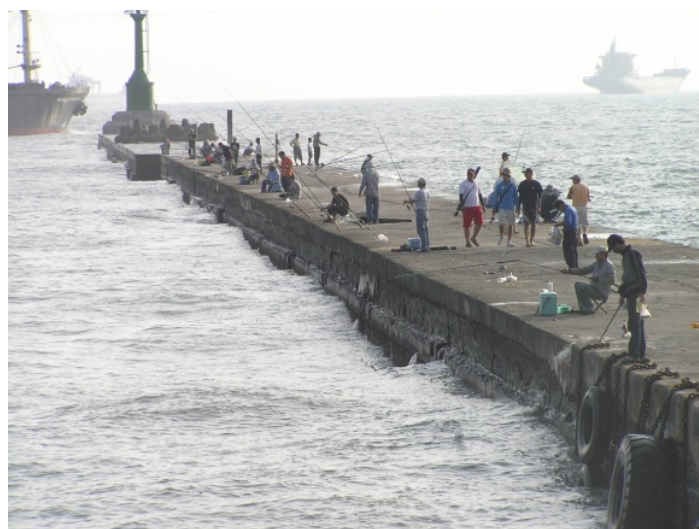
圖 5.35 沉箱防波堤內側海生較多
