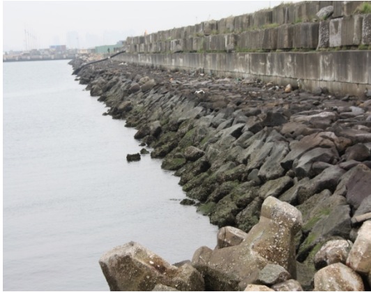
圖 5.22 台北港區內之拋石護岸(三)
