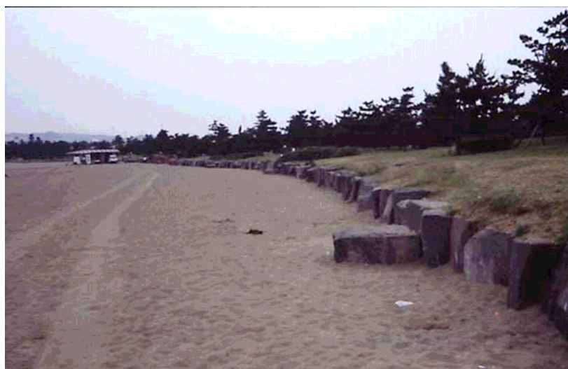
圖 6.29 自然石砌造的護岸
