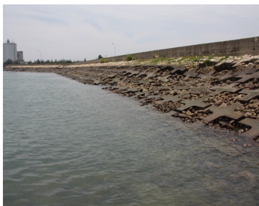
圖 5.4 台中港緩坡護岸(一)
