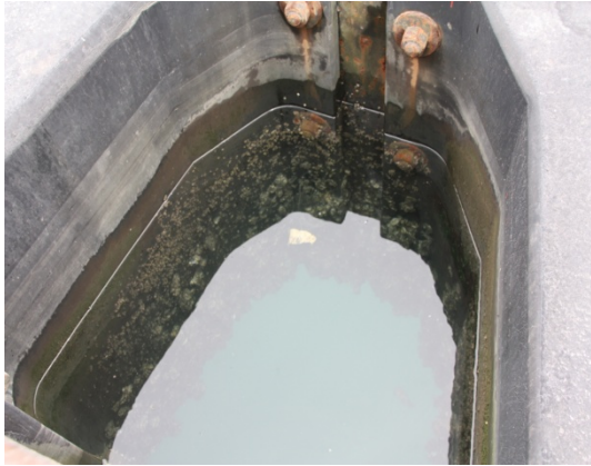
圖 5.24 水質乾淨之防舷材內部(一)
